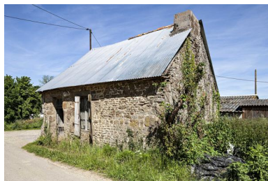
Ancienne maison, 1 La Beslinière Phot. Yves Guillotin IVR52_20215300672NUCA
