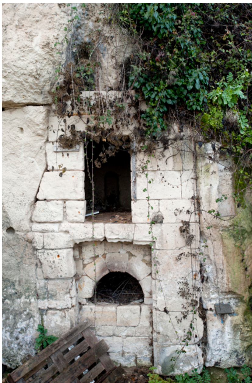
Habitat troglodytique abandonné, partiellement transformé en four à pain.
