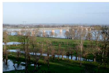
Vue, depuis le jardin, sur le pont de Montsoreau. Phot. Bruno Rousseau IVR52_20124900009NUCA
