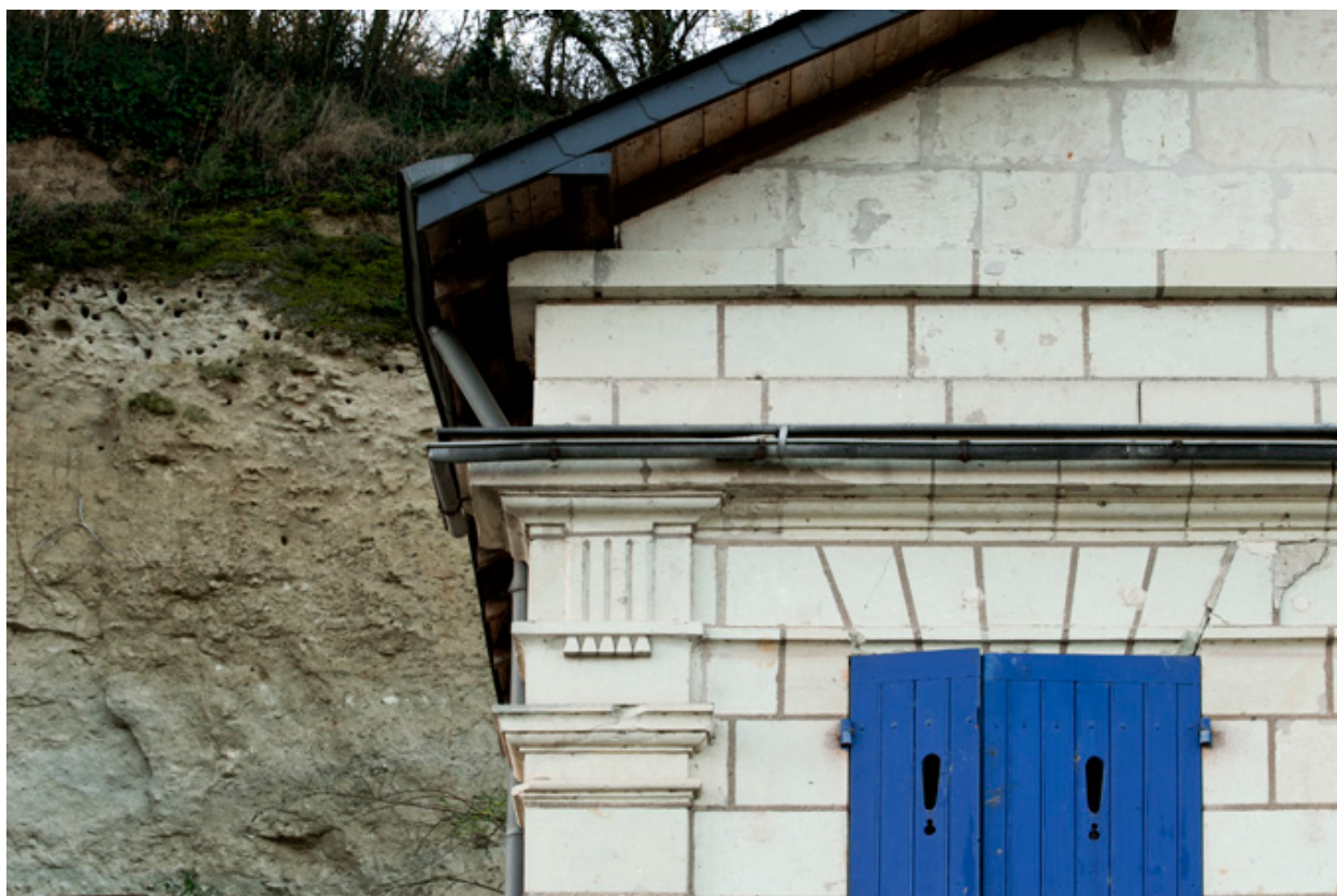
Détail du décor néoclassique de la façade : pilastre et entablement.
