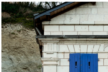
Détail du décor néoclassique de la façade : pilastre et entablement. Phot. Bruno Rousseau IVR52_20124900014NUCA
