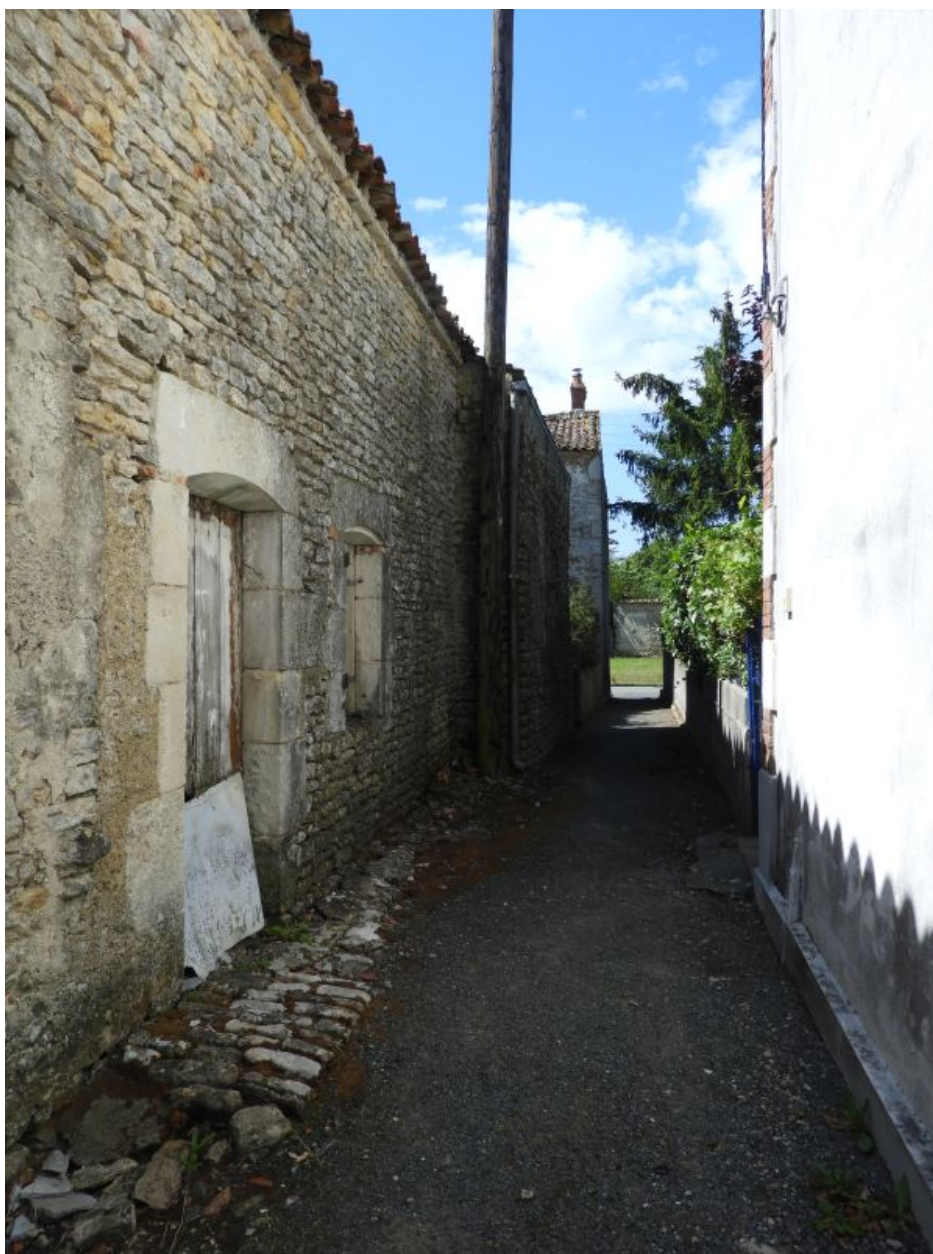
Anciennes maisons rue de la Quincaillerie, à l'arrière du hangar, vues depuis le nord.
