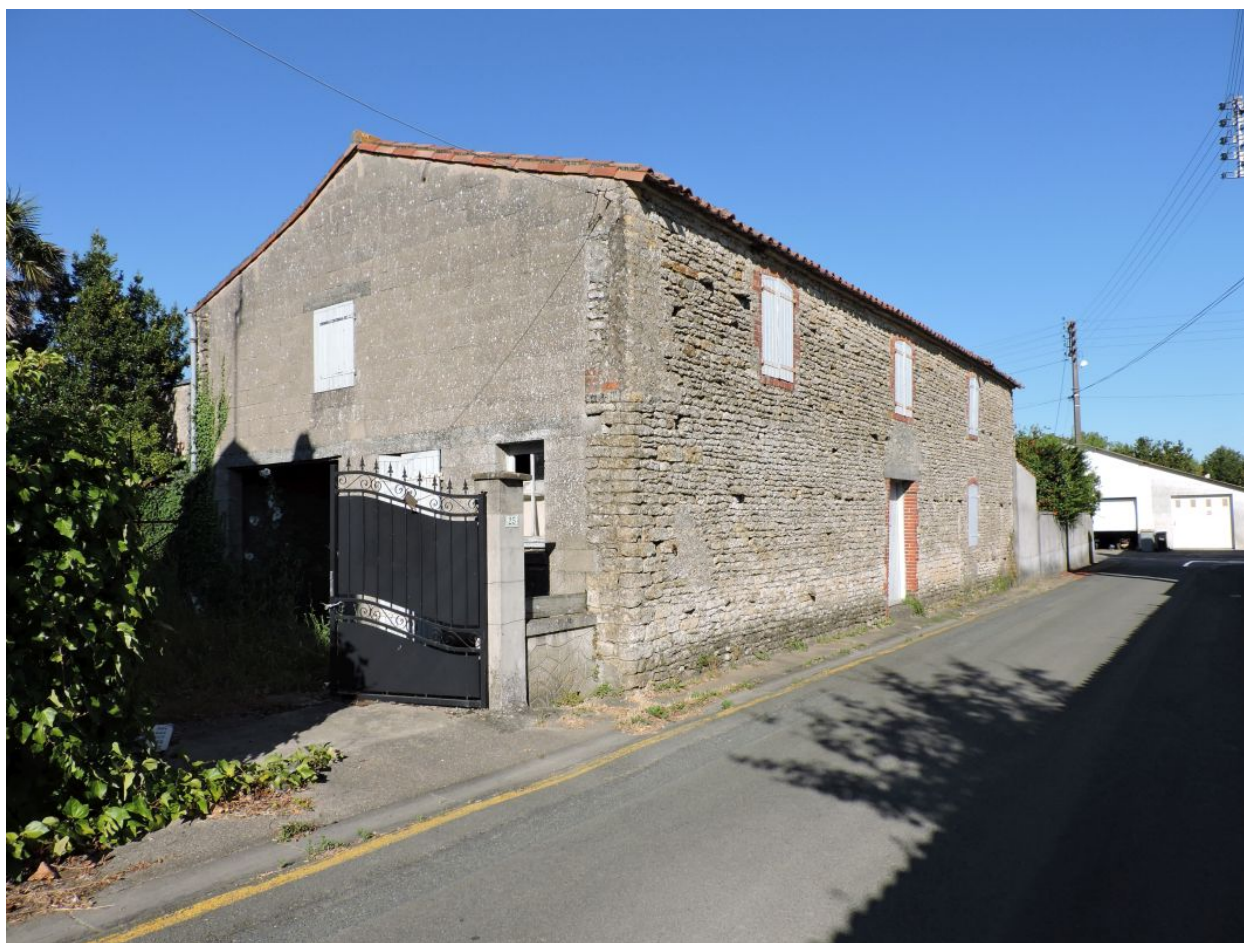
L'écurie vue depuis l'ouest.
