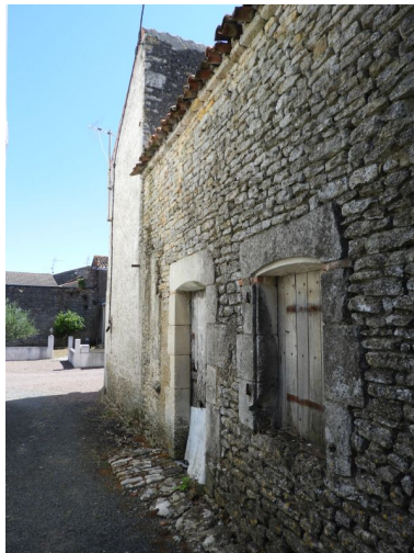
Petites baies vestiges d'une maison remplacée par le hangar, rue de la Quincaillerie. Phot. Yannis Suire IVR52_20198501854NUCA
