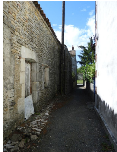
Anciennes maisons rue de la Quincaillerie, à l'arrière du hangar, vues depuis le nord. Phot. Yannis Suire IVR52_20198501857NUCA
