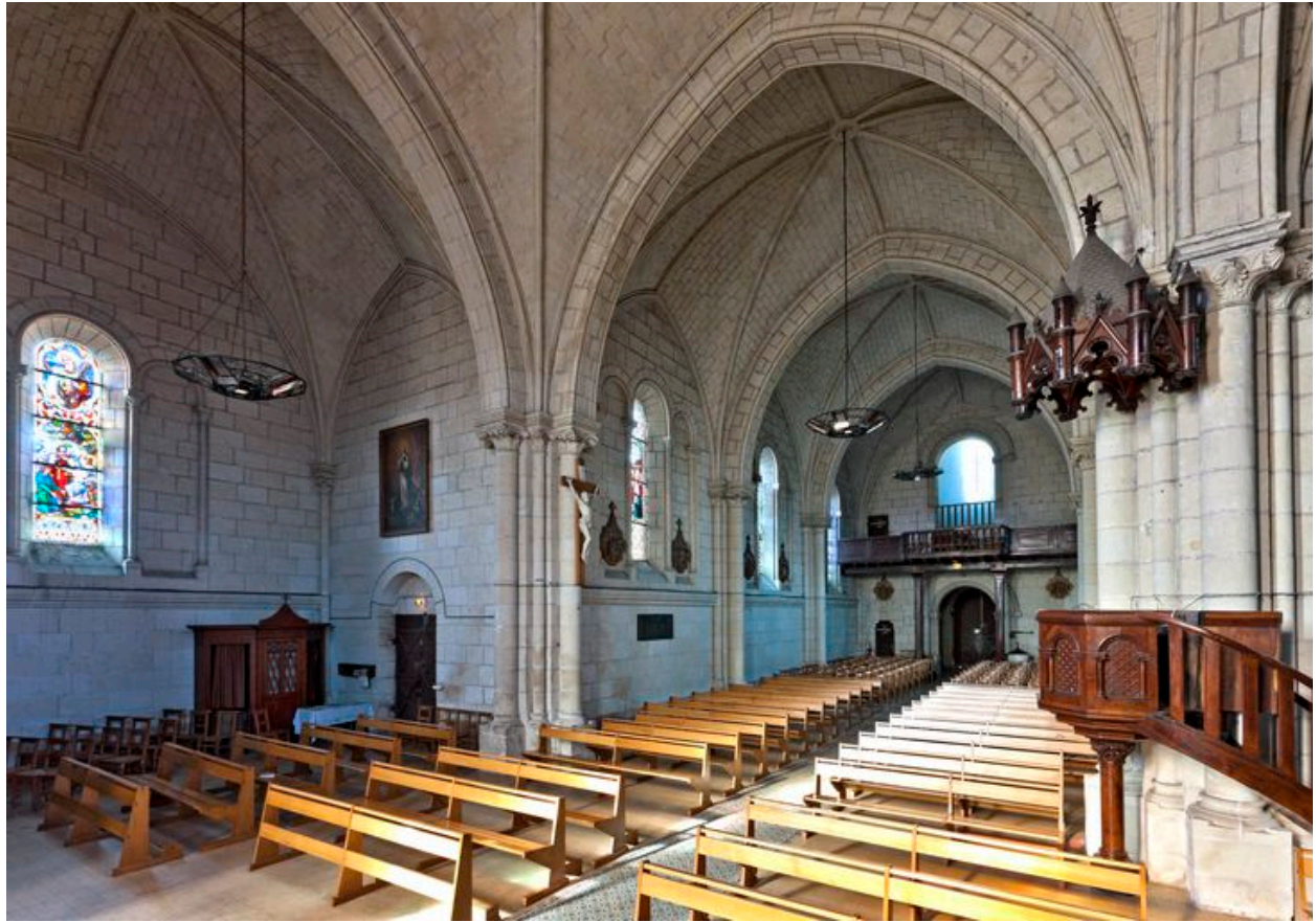
Vue du bras sud du transept et du côté sud de la nef avec le monument aux morts.
