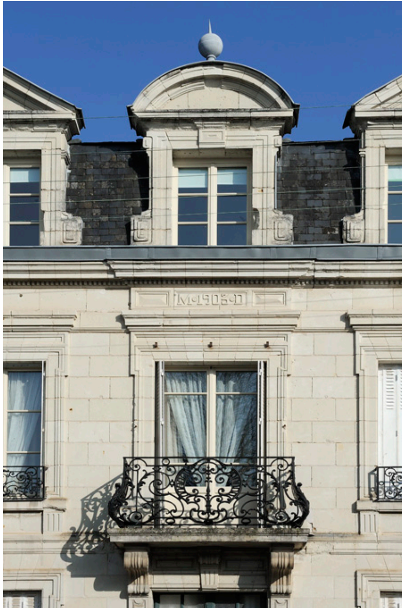
Détail de la travée axiale : baie de l'étage et lucarne
