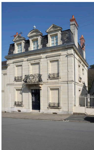
Vue générale. Phot. Bruno Rousseau, Phot. Youenn Communeau IVR52_20124901158NUCA
