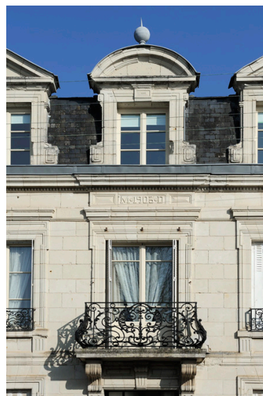
Détail de la travée axiale : baie de l'étage et lucarne Phot. Bruno Rousseau, Phot. Youenn Communeau IVR52_20114900681NUCA
