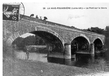
Le pont, vers 1910. IVR52_20104400701NUCA
