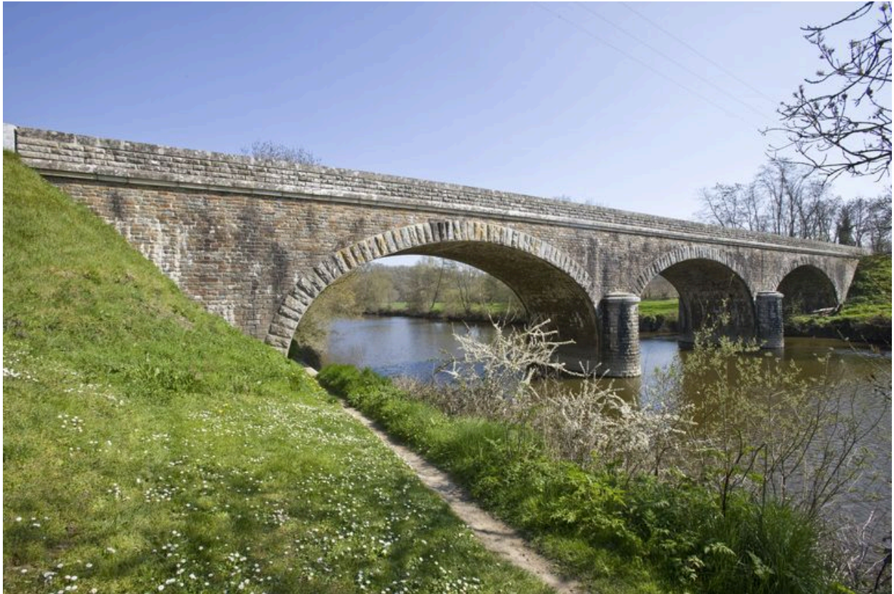
Le pont de la Haie-Fouassière.
