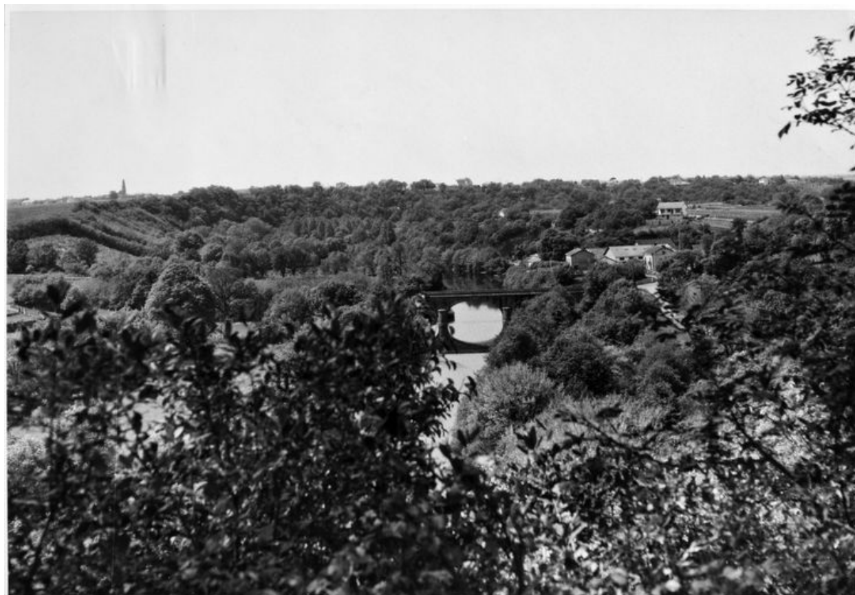
Le pont : vue aérienne à partir de l'est, vers 1960.
