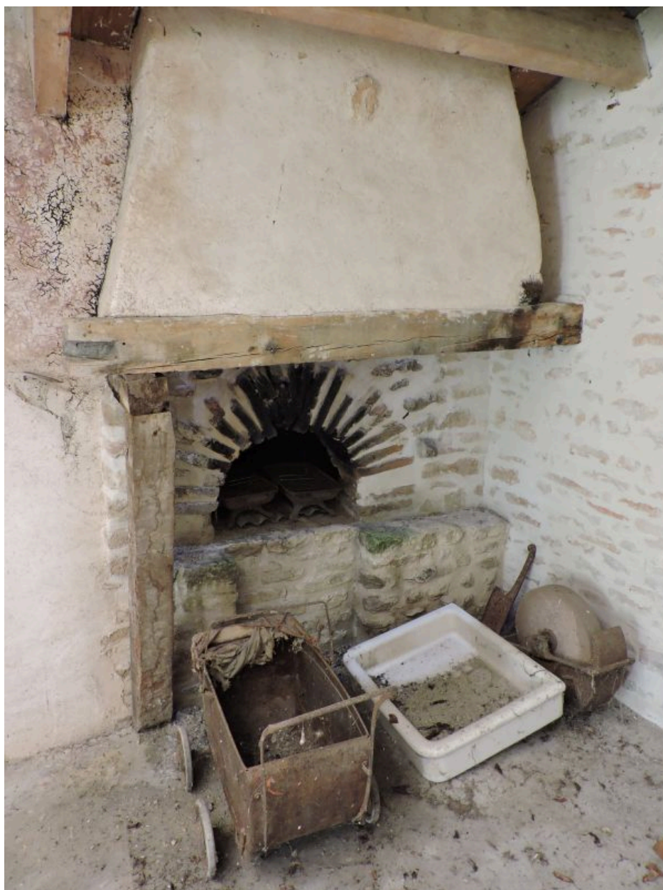
Four, 14 rue du Pont aux chèvres.
