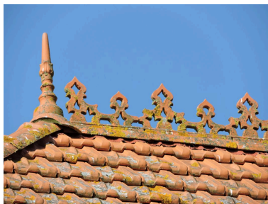
Nouveau type de décor à la fin du 19e siècle et au début du 20e : tuile mécanique, crête et épi de faîtage, 92 rue Georges Clemenceau. Phot. Yannis Suire IVR52_20198502329NUCA
