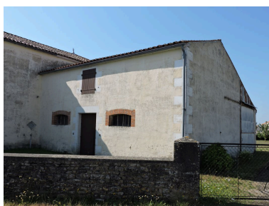
Grange-étable, 2 rue du Pont aux chèvres. Phot. Yannis Suire IVR52_20198502356NUCA
