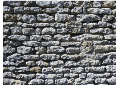
Mur en moellons, rue du Chevreau. Phot. Yannis Suire IVR52_20198501808NUCA
