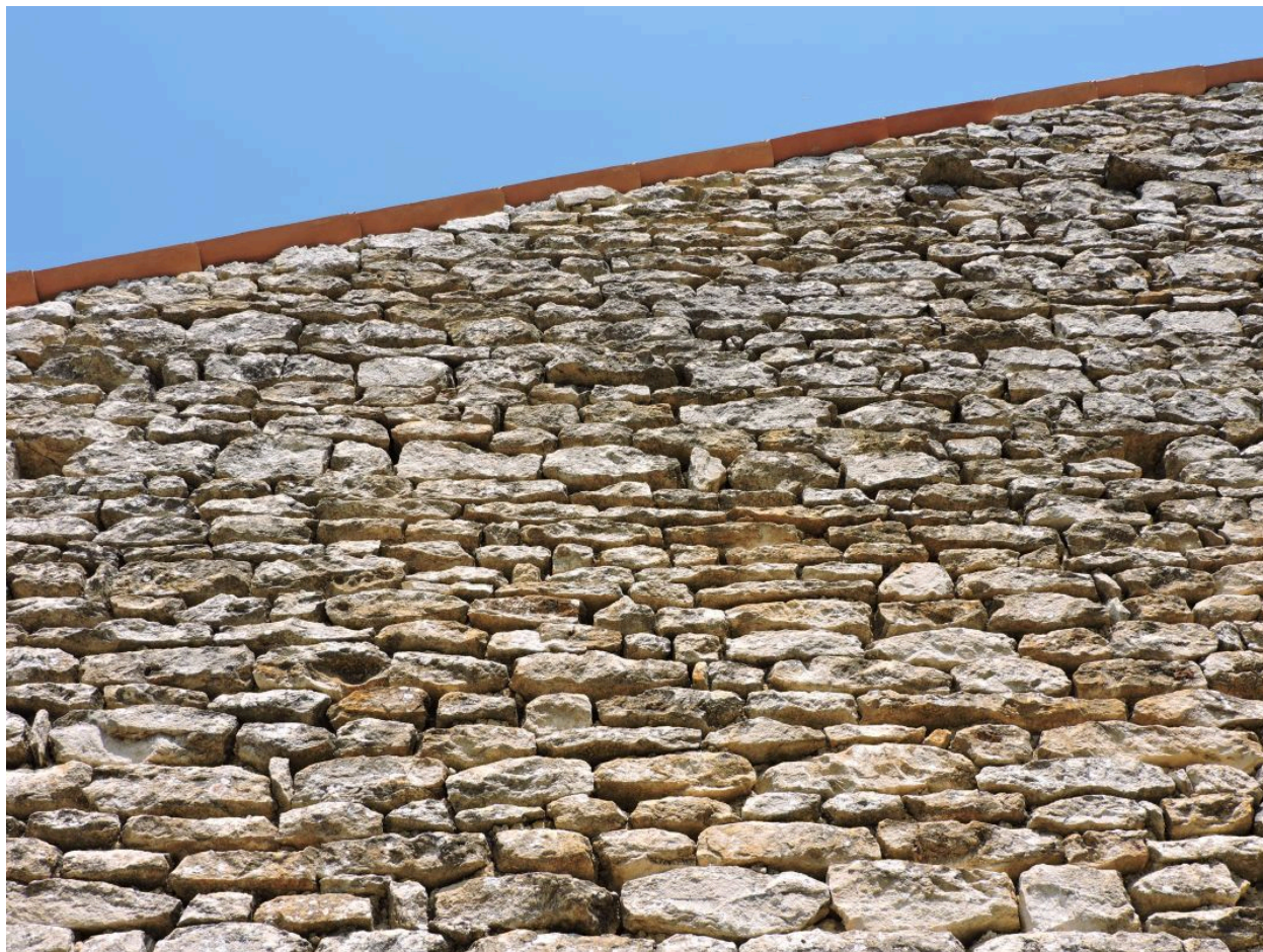
Mur en moellons, 83 rue Georges Clemenceau.
