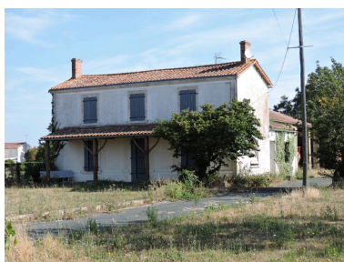
Ferme avec dépendances perpendiculaires à l'arrière, rue de la Marquiserie. Phot. Yannis Suire IVR52_20198502886NUCA
