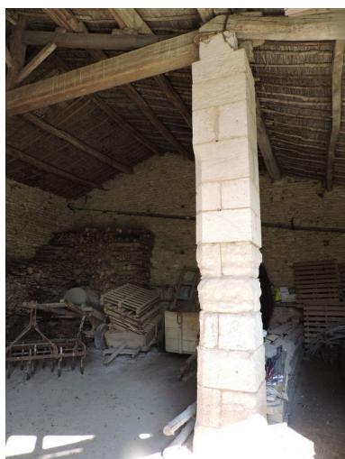
Hangar avec pilier en pierre et couverture en roseau, 12 rue de la Guilletrie. Phot. Yannis Suire IVR52_20198501926NUCA
