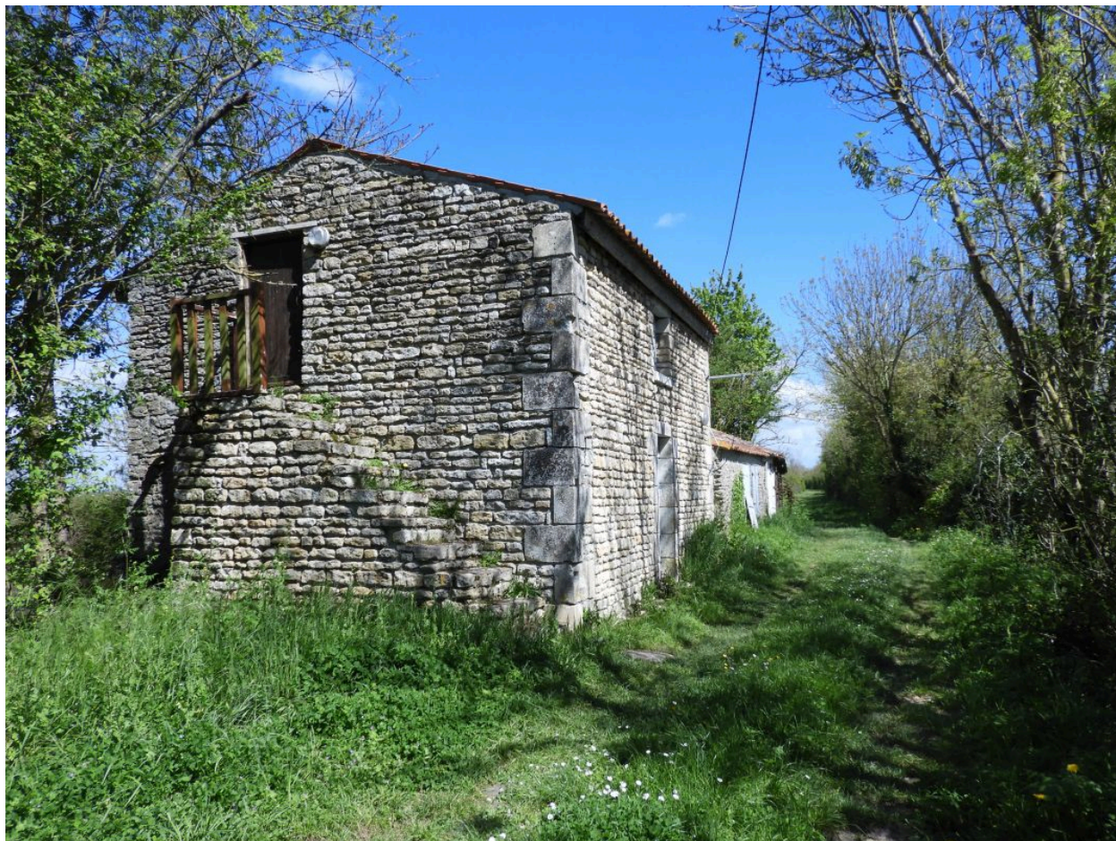
Une des huttes créées sur la Grande levée de Vix au 18e siècle, ici près du Grand Sablon.
