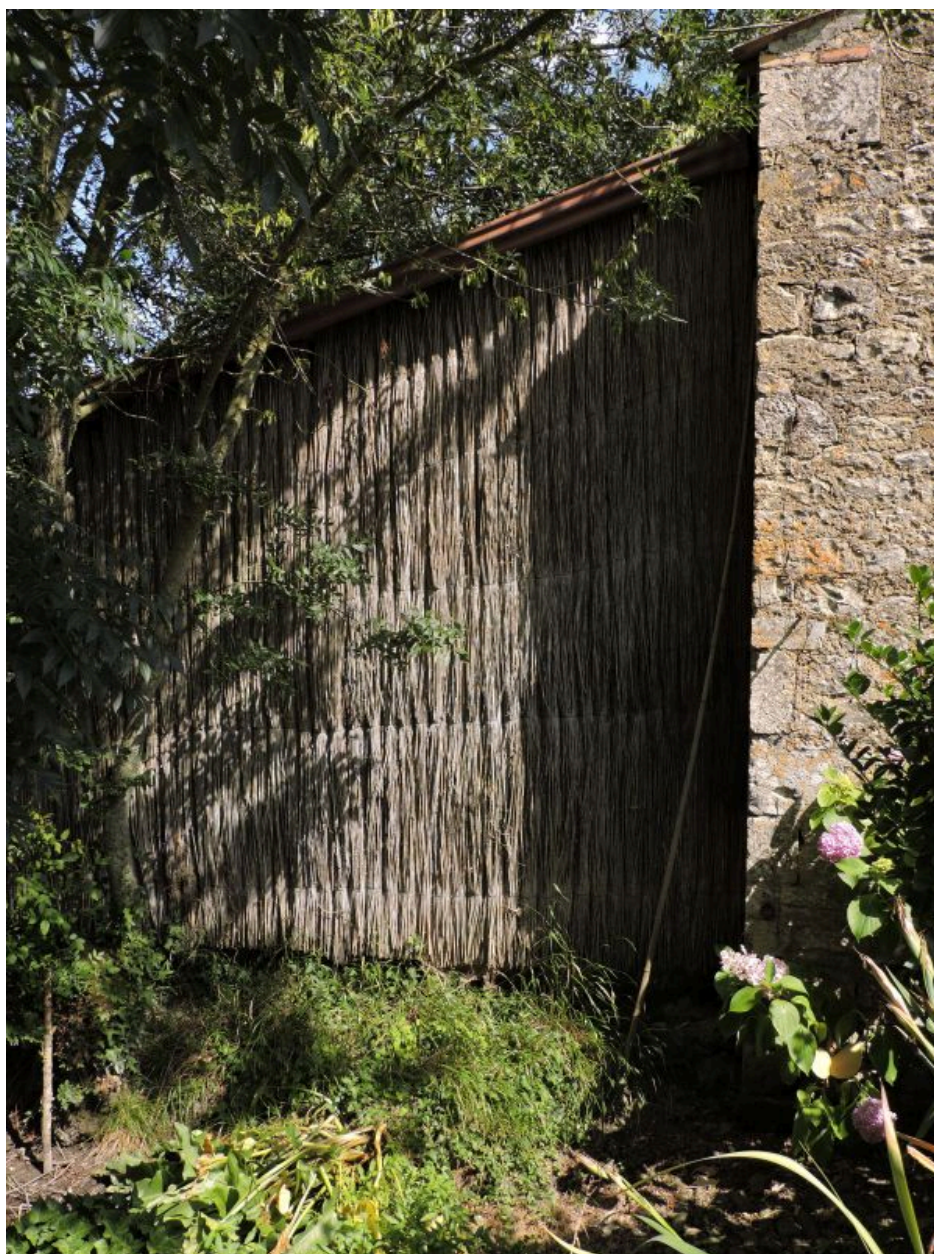
Bardage en roseau, à la ferme de la Lime ou de Digolet.
