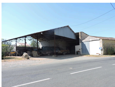
Hangar métallique, au Port Vieux. Phot. Yannis Suire IVR52_20198502934NUCA
