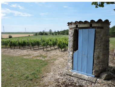
Puits coiffé, aux Terrières. Phot. Yannis Suire IVR52_20198502170NUCA
