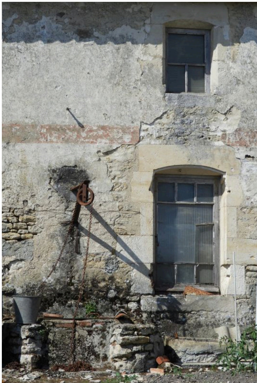
Baies du 18e siècle, rue Georges Clemenceau.
