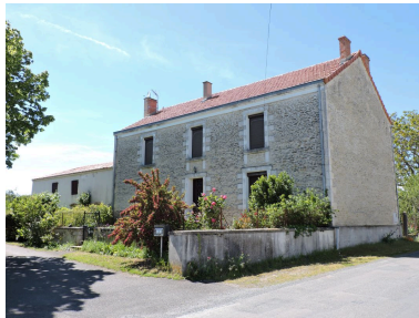
Logis de ferme des années 1930, à trois travées d'ouvertures en façade, 1 rue de Cassinelle. Phot. Yannis Suire IVR52_20198501479NUCA
