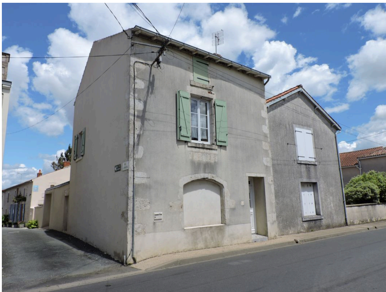
Maison avec ancien commerce, 19 rue Georges Clemenceau.
