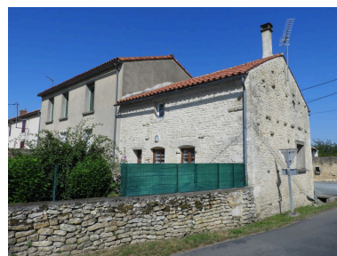
Maison de la fin du 18e siècle au Carq. Phot. Yannis Suire IVR52_20198501710NUCA
