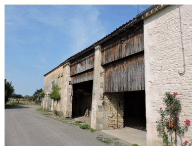
Hangar en pierre, 24 rue du Pont aux chèvres. Phot. Yannis Suire IVR52_20198502552NUCA
