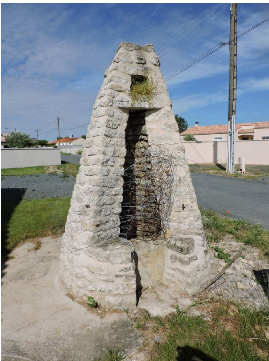
Puits coiffé, rue des Terrières.
