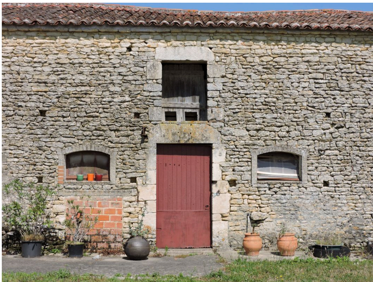
Grange-étable avec ouvertures réparties symétriquement autour de la porte centrale, 11 rue du Pont aux chèvres.
