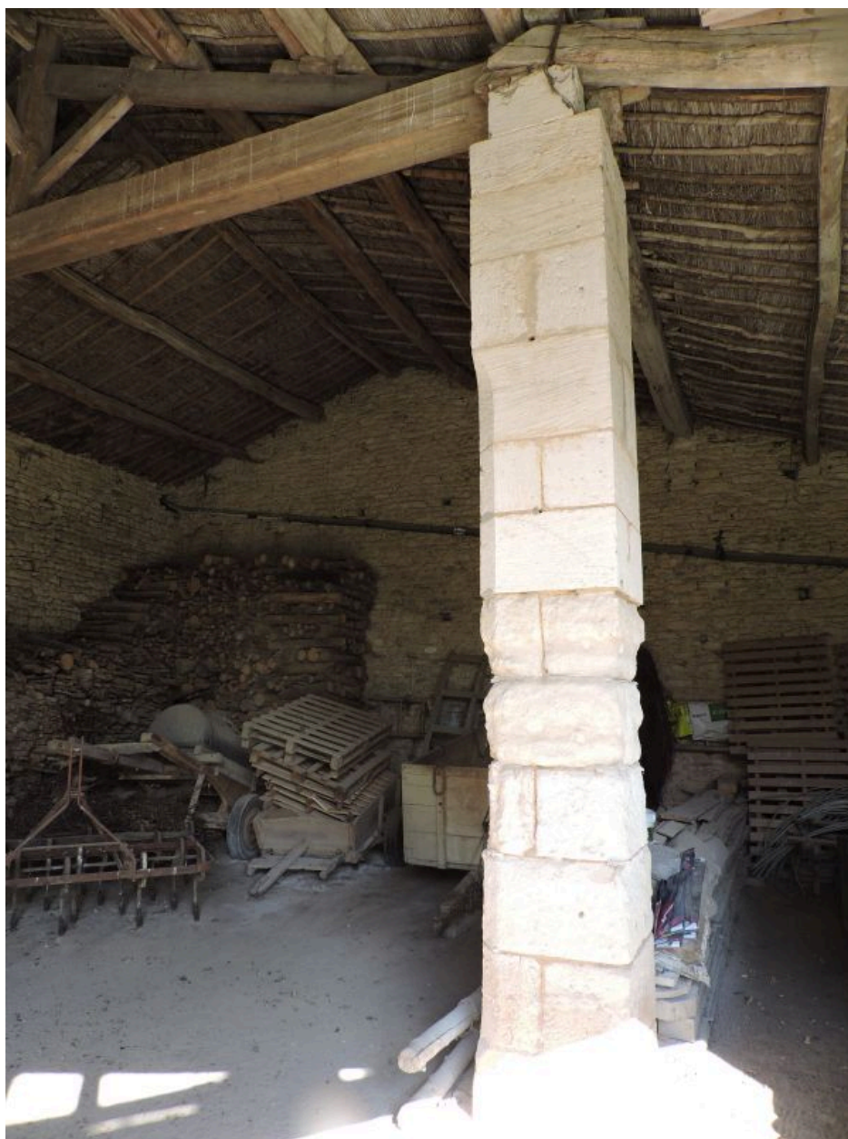
Hangar avec pilier en pierre et couverture en roseau, 12 rue de la Guilletrie.
