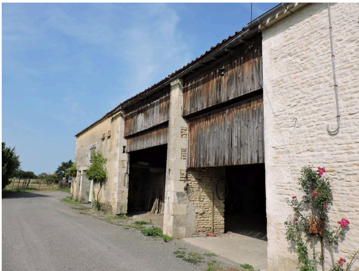
Hangar en pierre, 24 rue du Pont aux chèvres.
