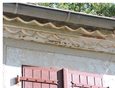
Génoise, élément de décor abandonné au milieu du 19e siècle, à Drapelle. Phot. Yannis Suire IVR52_20198502875NUCA
