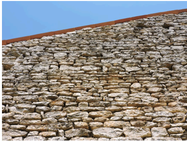
Mur en moellons, 83 rue Georges Clemenceau. Phot. Yannis Suire IVR52_20198502411NUCA
