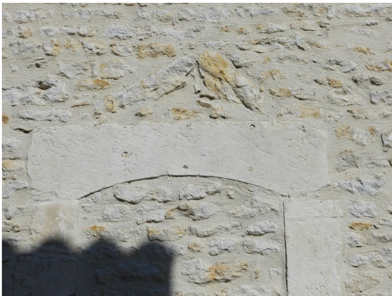
Ancienne baie du 18e siècle, murée, rue Georges Clemenceau.
