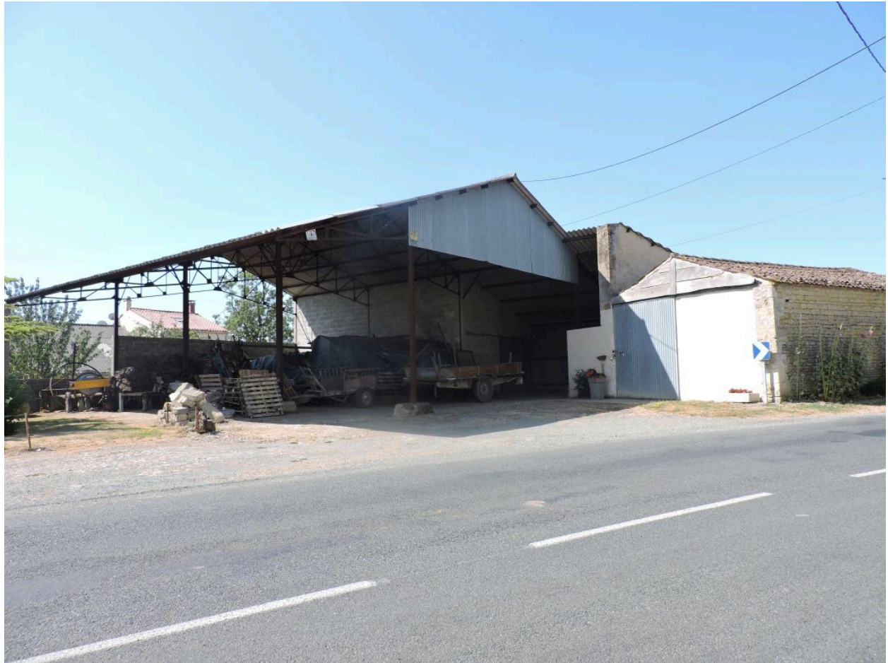
Hangar métallique, au Port Vieux.
