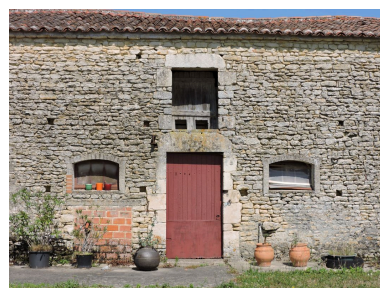
Grange-étable avec ouvertures réparties symétriquement autour de la porte centrale, 11 rue du Pont aux chèvres. Phot. Yannis Suire IVR52_20198502386NUCA
