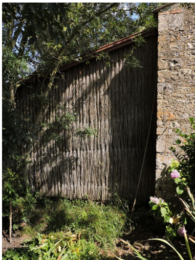
Bardage en roseau, à la ferme de la Lime ou de Digolet. Phot. Yannis Suire IVR52_20198503067NUCA
