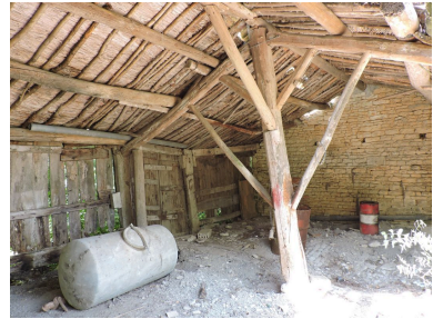
Dépendance en bois et en roseau, en Charouin. Phot. Yannis Suire IVR52_20198503045NUCA
