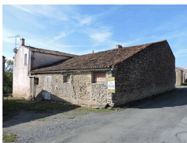
Ferme à bâtiments jointifs, à la Chaignée. Phot. Yannis Suire IVR52_20198503228NUCA
