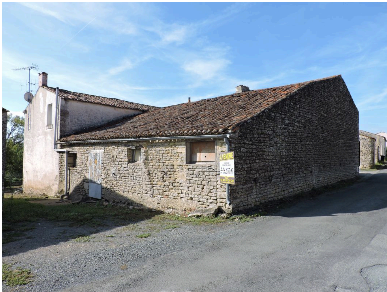
Ferme à bâtiments jointifs, à la Chaignée.
