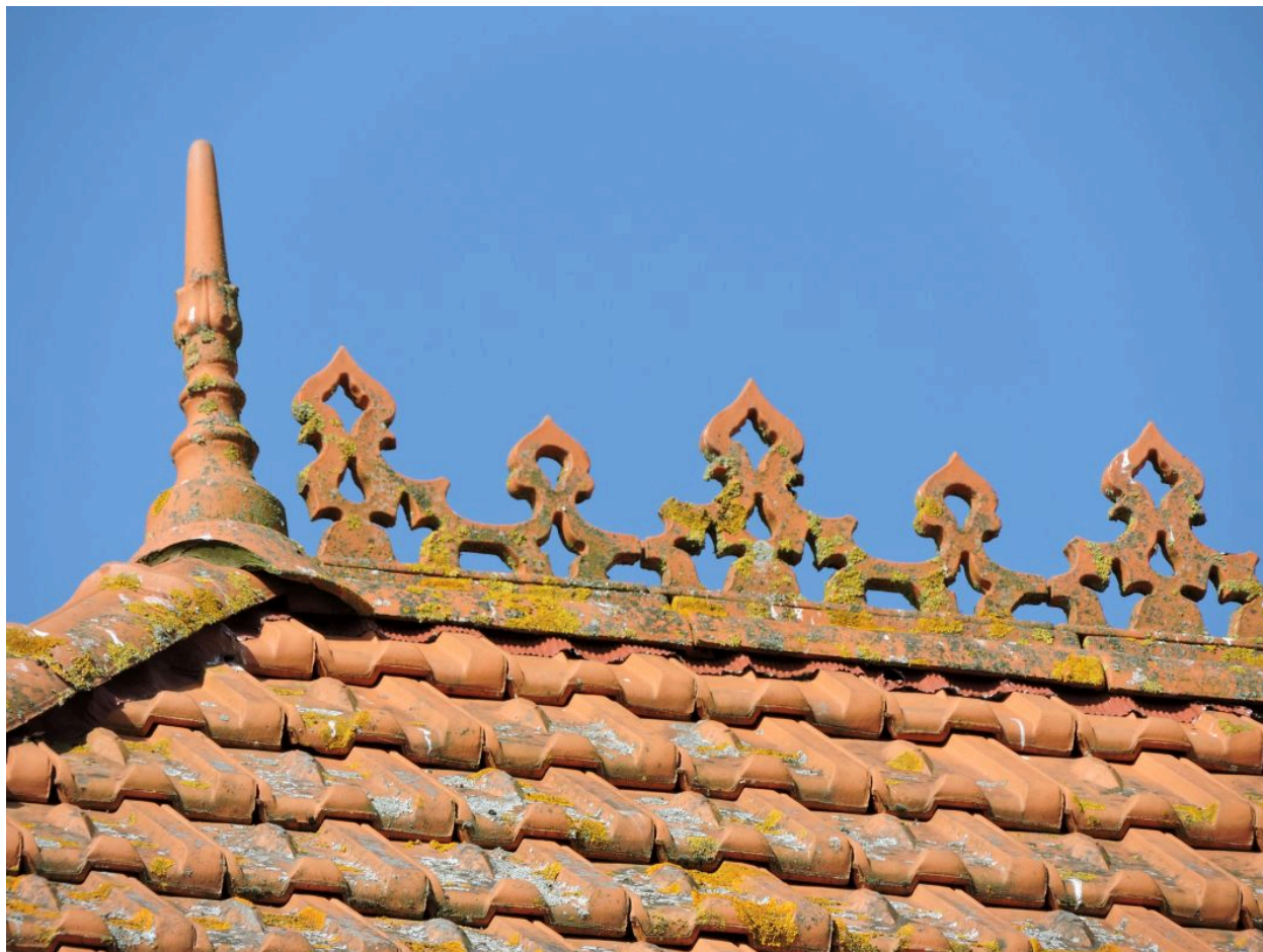
Nouveau type de décor à la fin du 19e siècle et au début du 20e : tuile mécanique, crête et épi de faîtage, 92 rue Georges Clemenceau.
