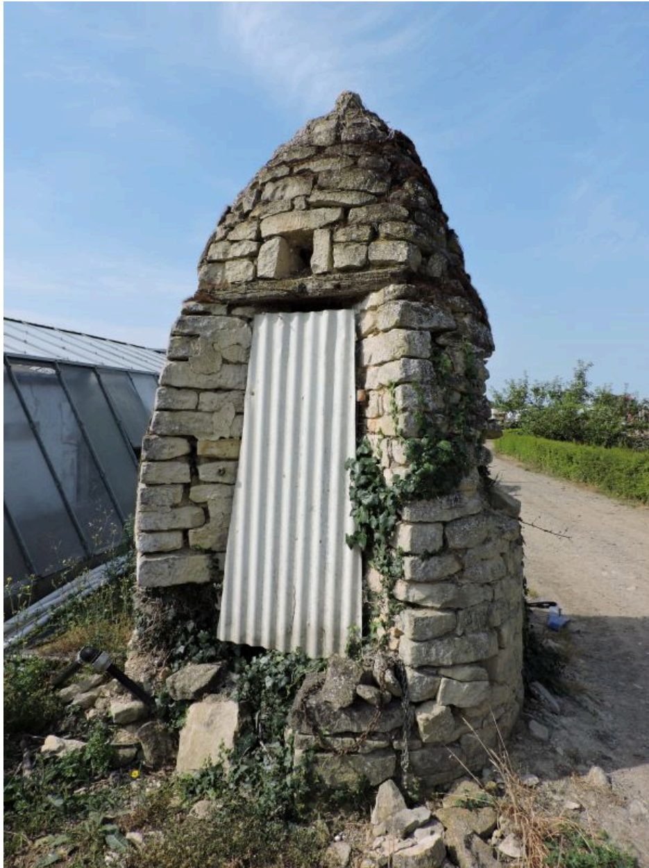
Puits coiffé, 20 rue du Pont aux chèvres.
