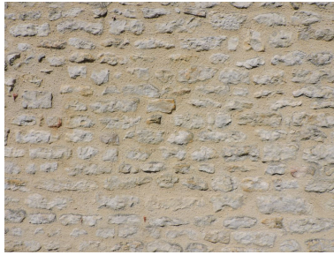
Mur de moellons partiellement enduits, rue du Bourbia. Phot. Yannis Suire IVR52_20198501529NUCA
