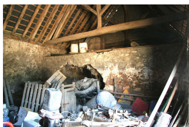
La grange étable. Phot. Jean-Baptiste Darrasse IVR52_20077200984NUCA
