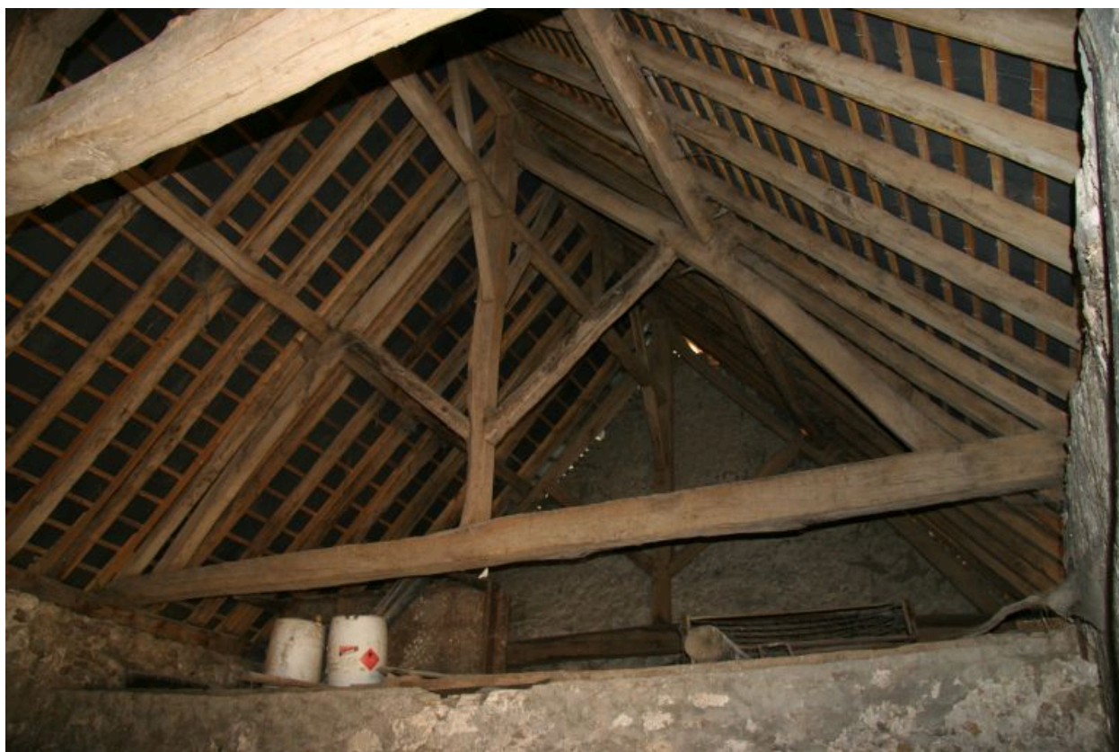
La grange-étable : la charpente.
