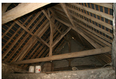
La grange-étable : la charpente. Phot. Jean-Baptiste Darrasse IVR52_20077200982NUCA
