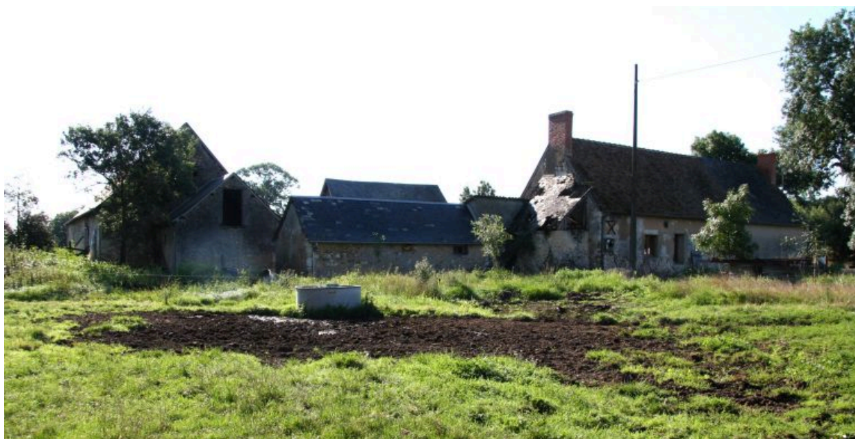
Vue d'ensemble prise du nord.
