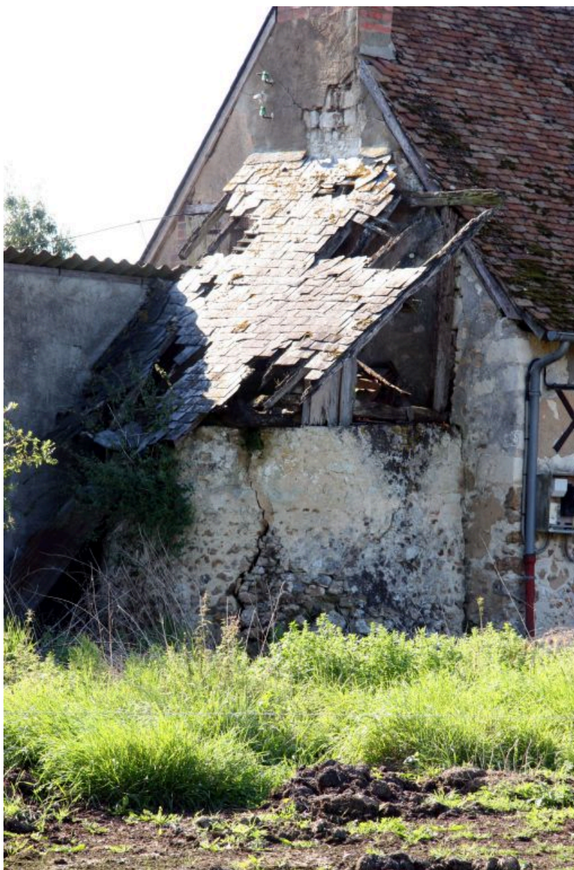
Pignon nord de la maison : four à pain.
