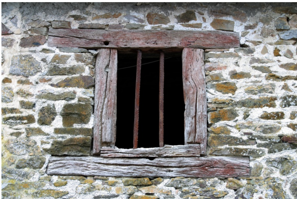
Fenêtre en bois de l'ancien logis-étable.
