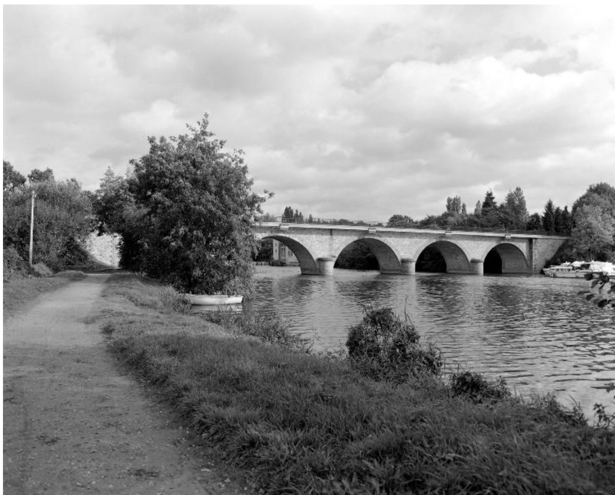
Vue d'aval depuis le chemin de halage, rive droite.
