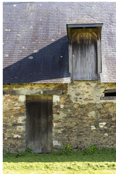
Un détail des ouvertures de l'étable. Phot. Pierre-Bernard Fourny IVR52_20225300285NUCA
