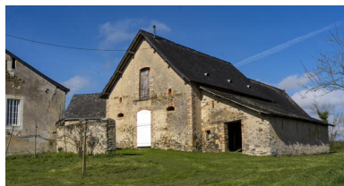
La grange-étable. Phot. Pierre-Bernard Fourny IVR52_20225300291NUCA
