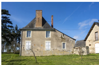
La façade latérale du logis. Phot. Pierre-Bernard Fourny IVR52_20225300292NUCA
