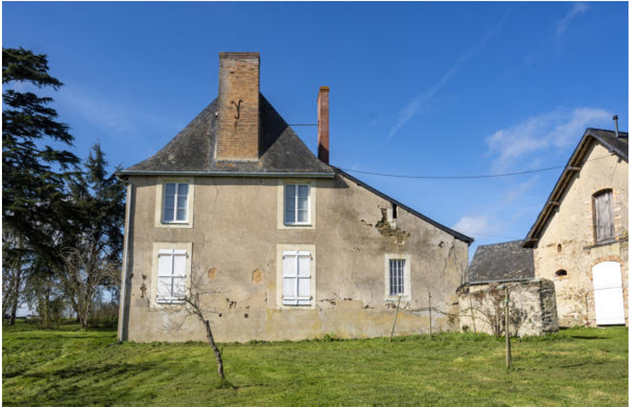
La façade latérale du logis.
