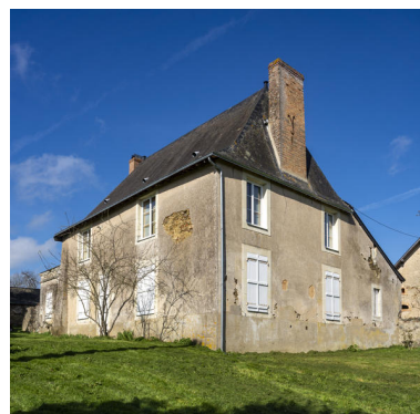
Le logis. Phot. Pierre-Bernard Fourny IVR52_20225300293NUCA
