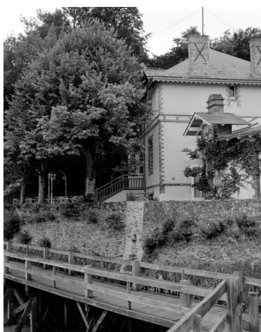
Vue du sud-est. Phot. Denis Pillet IVR52_19984401605X
