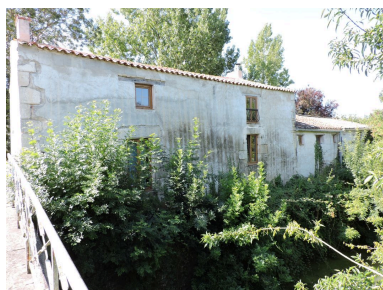
La hutte vue depuis le nord-est, en surplomb du canal de Vix. Phot. Yannis Suire IVR52_20198502900NUCA
