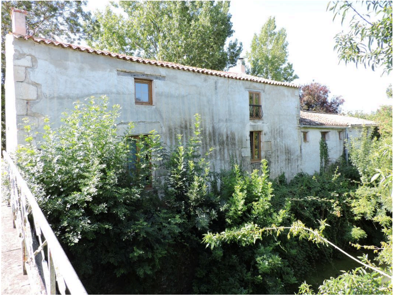
La hutte vue depuis le nord-est, en surplomb du canal de Vix.
