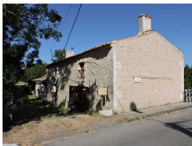
La hutte vue depuis l'est. Phot. Yannis Suire IVR52_20198502901NUCA
