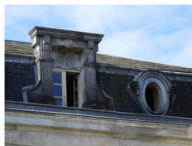
Détail des lucarnes.
