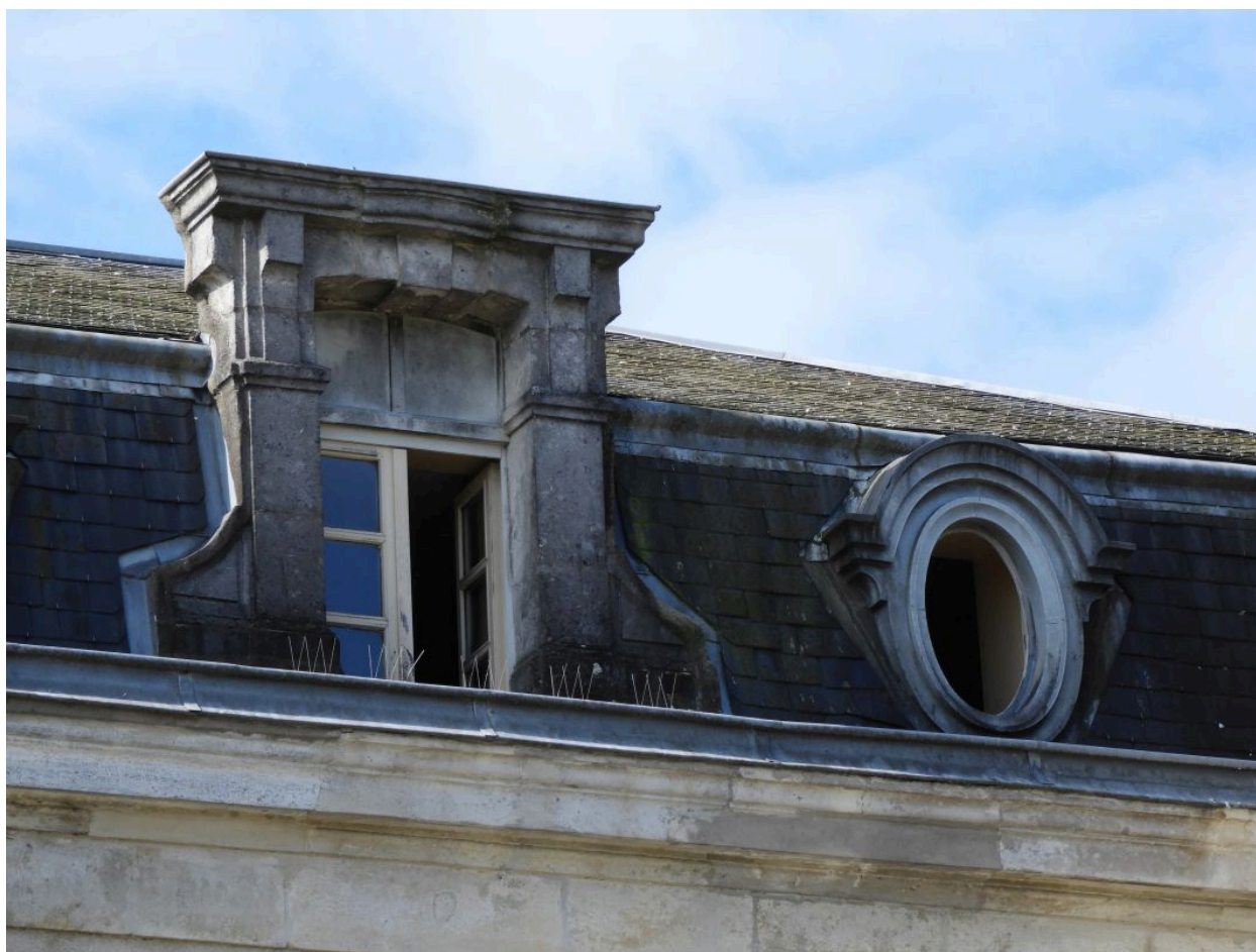
Détail des lucarnes.
