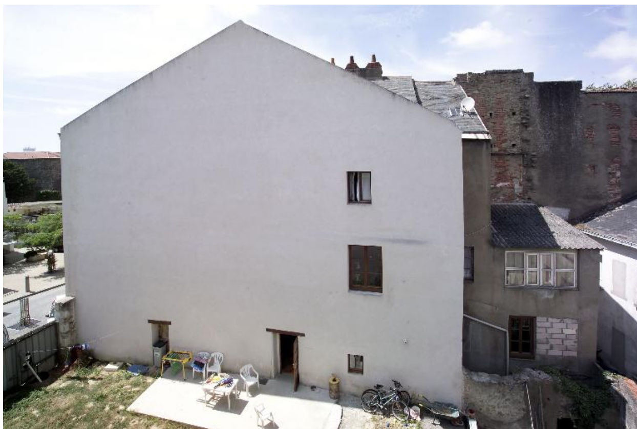
Vue d'ensemble depuis la maison n° 32.
