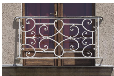
Un balcon du deuxième étage. Phot. Denis Pillet IVR52_20034400651NUCA
