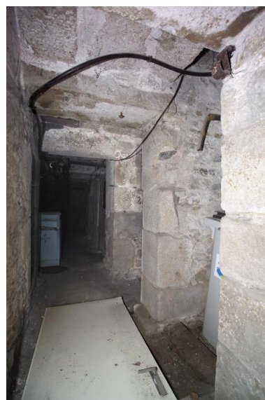
Le niveau des caves vue prise à hauteur du puits vers la rue du Général-De-Gaulle, à droite, le mur-noyau de l'escalier.
