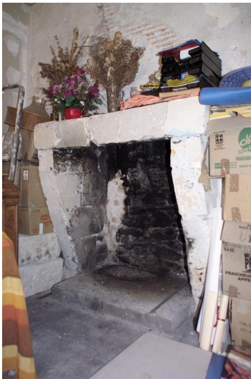
Le corps secondaire, premier étage, la cheminée.
