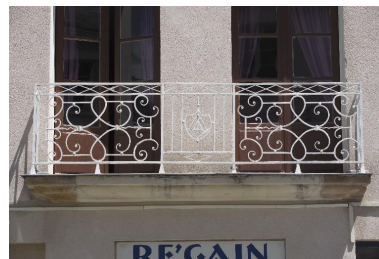
Le balcon filant du premier étage. Phot. Denis Pillet IVR52_20034400650NUCA
