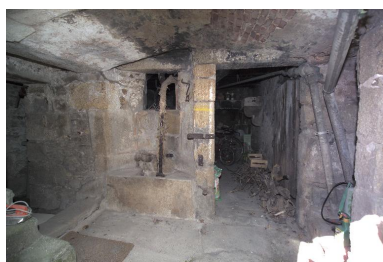
Le corps secondaire, l'entrée de la pièce située au niveau des caves.
