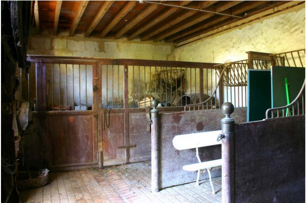
Les communs : les écuries.
