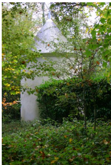
Ancienne tourelle d'angle. Phot. Jean-Baptiste Darrasse IVR52_20047204130NUCA
