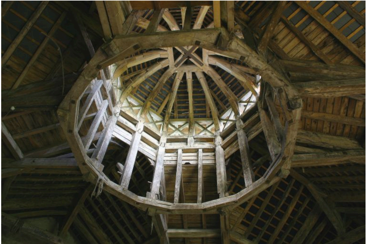
Le chais : puits de lumière construit comme une coupole à tambour en charpente.
