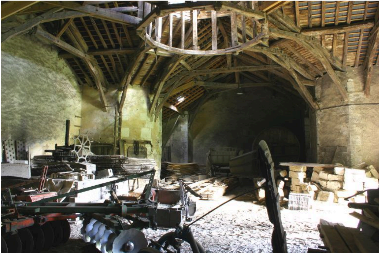
Le chais, intérieur : vue d'ensemble.
