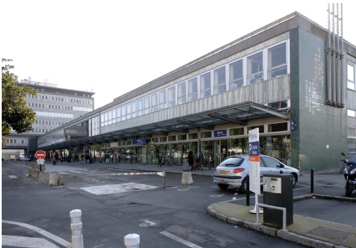
Accès nord, boulevard Stalingrad.
