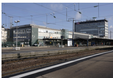
Accès nord, vue des quais. Phot. Denis Pillet IVR52_20114401230NUCA
