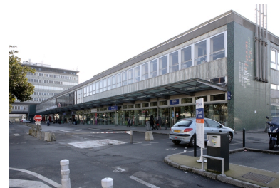
Accès nord, boulevard Stalingrad. Phot. Denis Pillet IVR52_20114400123NUCA
