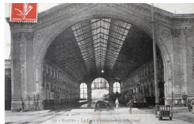
Grande halle voyageurs de Nantes, côté est. Phot. Denis Pillet IVR52_20104402379NUCA
