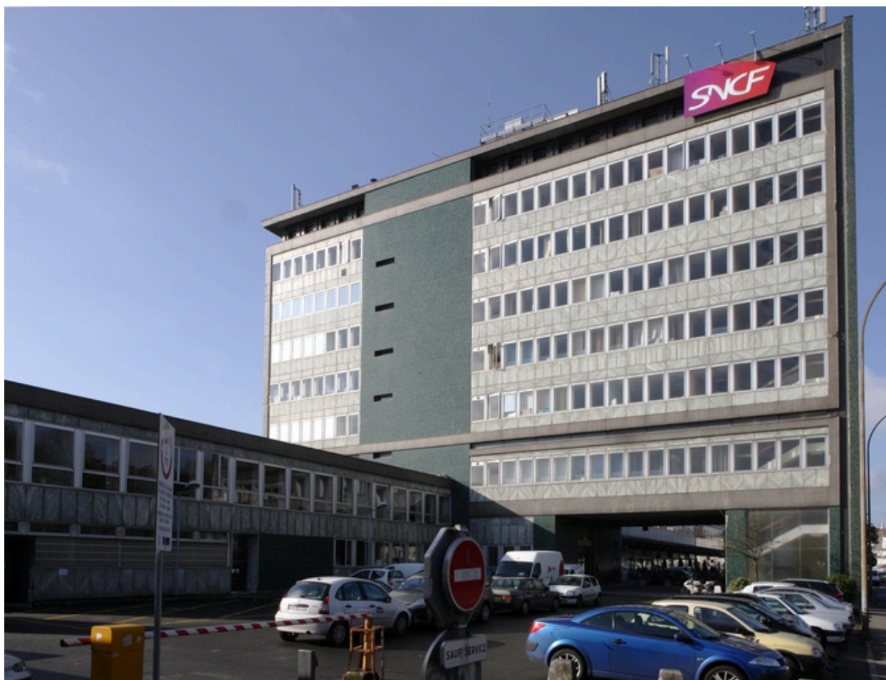
Bâtiment administratif, façade ouest.
