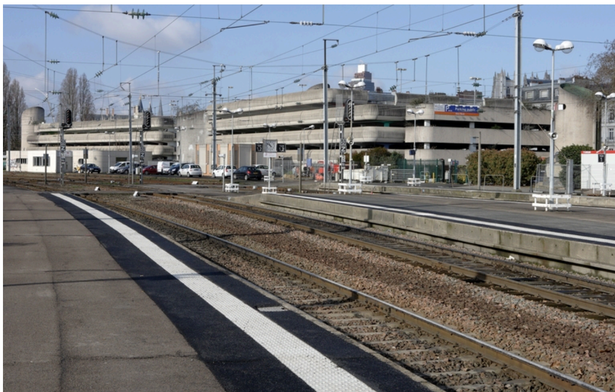
Parking, accès nord.
