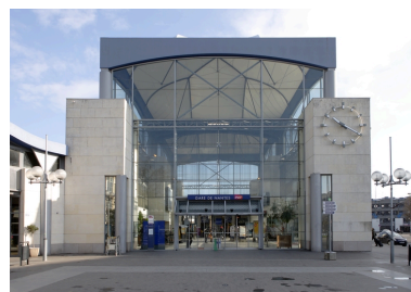
Accès sud. Phot. Denis Pillet IVR52_20114400118NUCA
