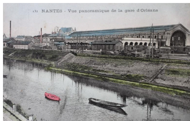
Ancienne gare d'Orléans. Repro. Denis Pillet IVR52_20104402376NUCA
