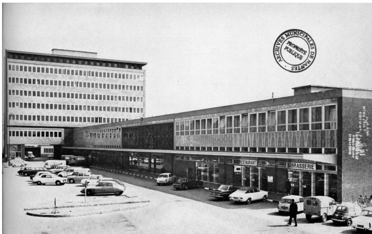
Facade nord du bâtiment des voyageurs et facade ouest du bâtiment administratif, 1971.
