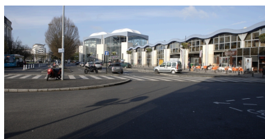
Accès sud. Phot. Denis Pillet IVR52_20114400116NUCA
