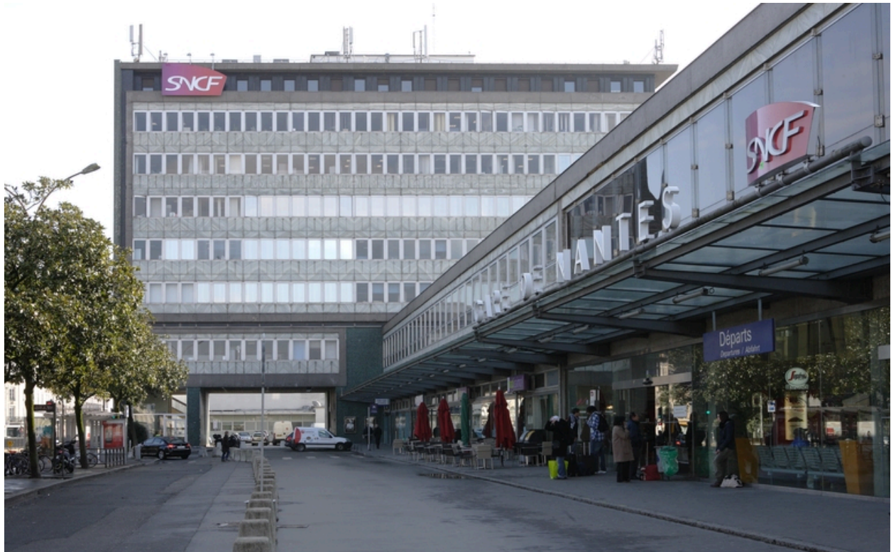
Bâtiment administratif, côté BV.
