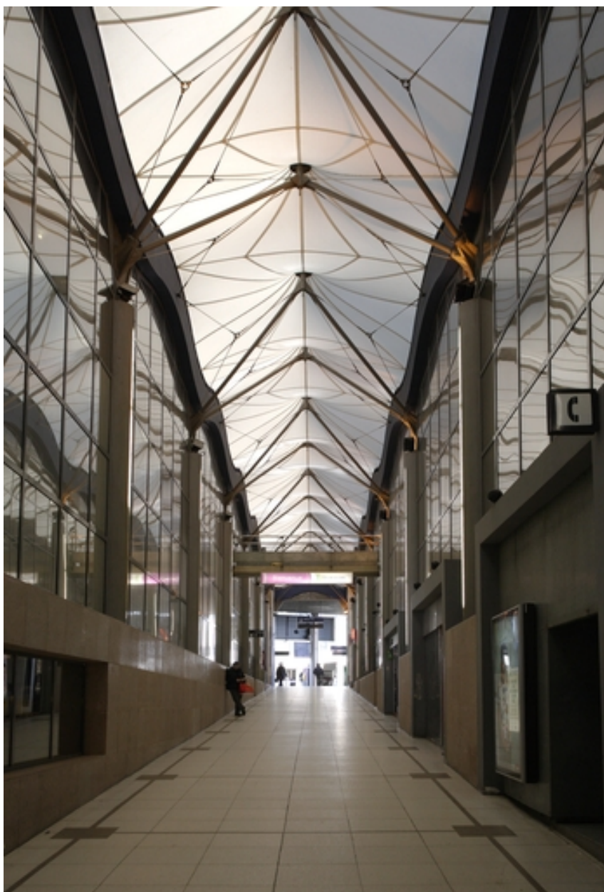
Accès sud : rampe d'accès aux quais.
