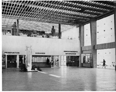
Intérieur du bâtiment des voyageurs, 1971. Repro. Patrick Jean IVR52_20144400026NUCA
