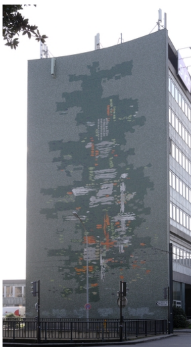
Bâtiment administratif, pignon nord. Phot. Denis Pillet IVR52_20114400128NUCA
