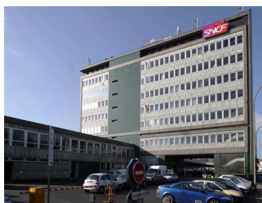
Bâtiment administratif, façade ouest. Phot. Denis Pillet IVR52_20114400127NUCA
