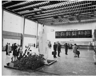
Intérieur du bâtiment des voyageurs, 1971. Repro. Patrick Jean IVR52_20144400027NUCA
