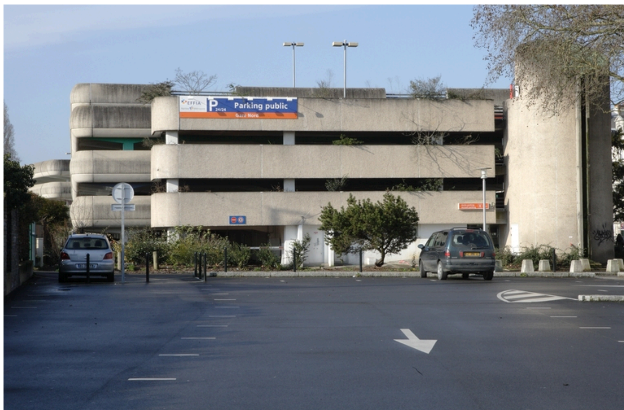
Parking, accès nord.
