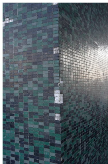
Bâtiment administratif, détail du revêtement de pâte de verre. Phot. Denis Pillet IVR52_20114400125NUCA
