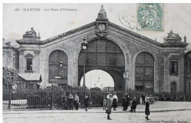
Grande halle voyageurs de Nantes, côté est. Phot. Denis Pillet IVR52_20124400237NUCA
