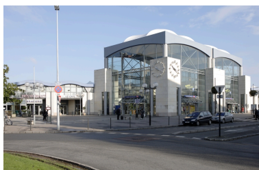
Accès sud. Phot. Denis Pillet IVR52_20114400117NUCA
