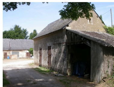
Écuries. Phot. Christine Toulhier IVR52_20047205330NUCA
