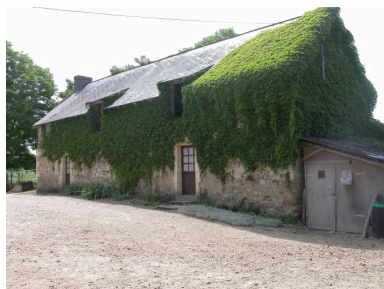
Maison d'habitation principale. Phot. Christine Toulhier IVR52_20047205326NUCA
