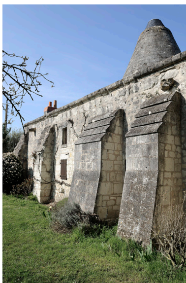
Moulin Neuf : contreforts de la façade sud Phot. Bruno Rousseau, Phot. Youenn Communeau IVR52_20114900803NUCA
