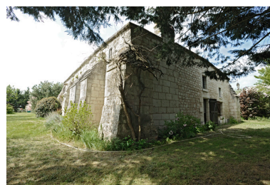
Moulin Neuf : angle sud-est. Phot. Bruno Rousseau, Phot. Youenn Communeau IVR52_20114901687NUCA
