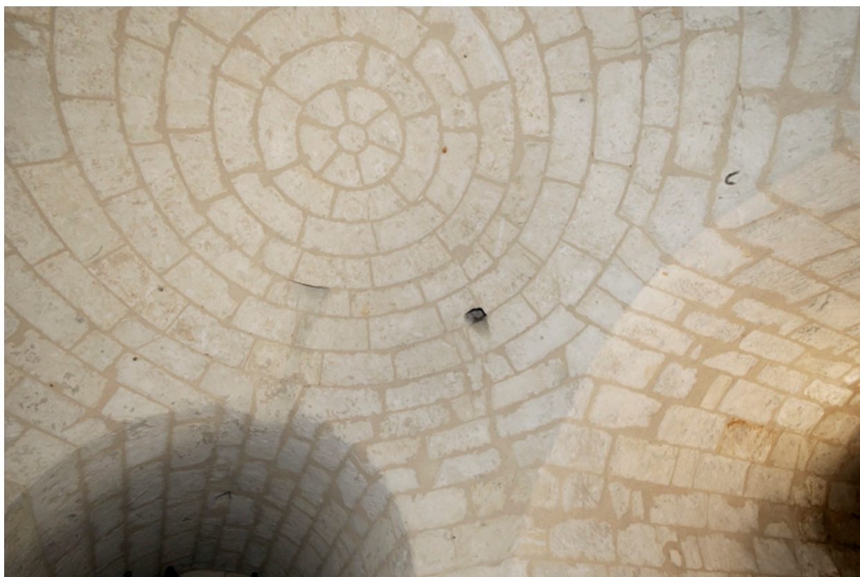
Moulin Picard (intérieur) : voûtes de la cave et du massereau.
