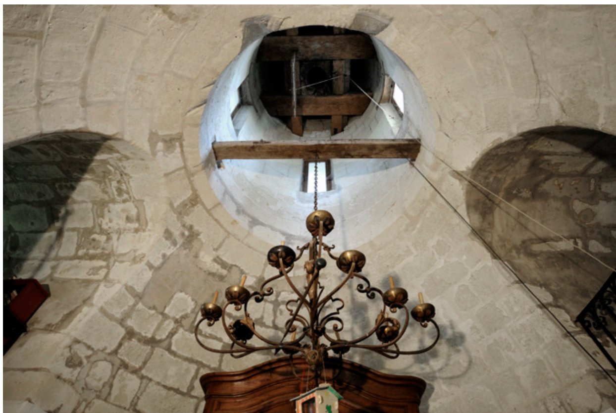
Moulin Neuf (intérieur) : voûtes de la cave du massereau, avec soles.
