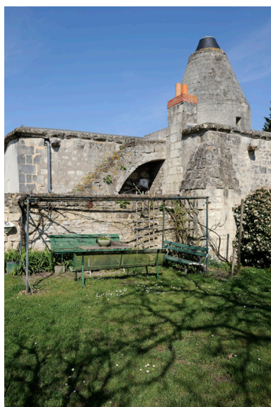
Moulin Neuf : angle sud-ouest (2). Phot. Bruno Rousseau, Phot. Youenn Communeau IVR52_20114900801NUCA
