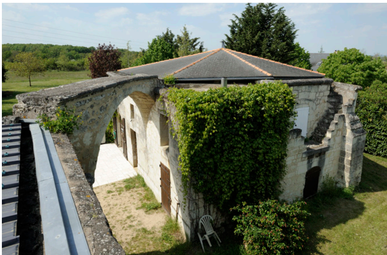
Passerelle et façade est du Moulin Picard.
