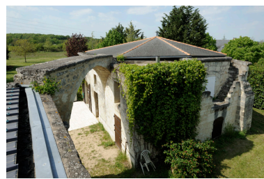
Passerelle et façade est du Moulin Picard. Phot. Bruno Rousseau, Phot. Youenn Communeau IVR52_20114901696NUCA
