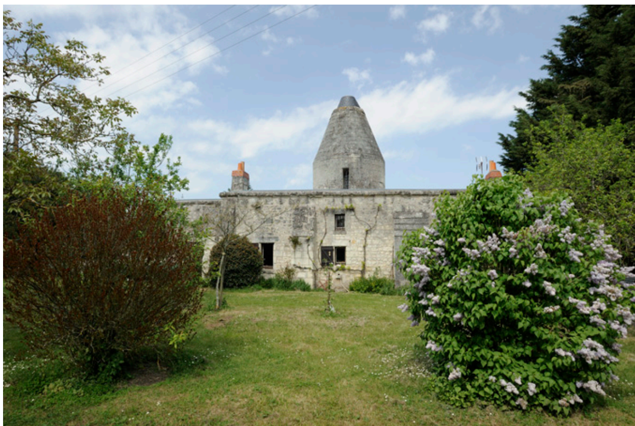
Moulin Neuf : vue d'ensemble de la façade sud.
