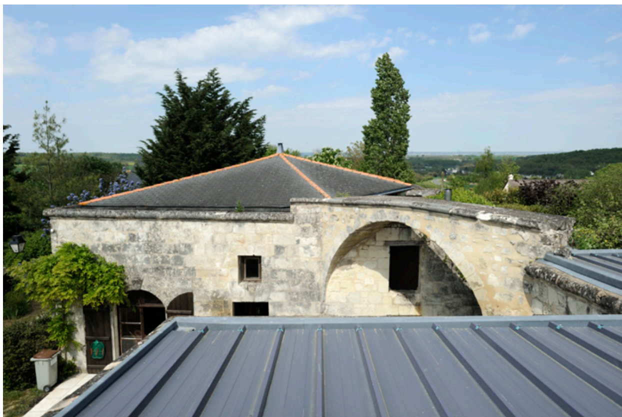
Passerelle de communication entre les couvertures du Moulin Neuf et du Moulin Picard.
