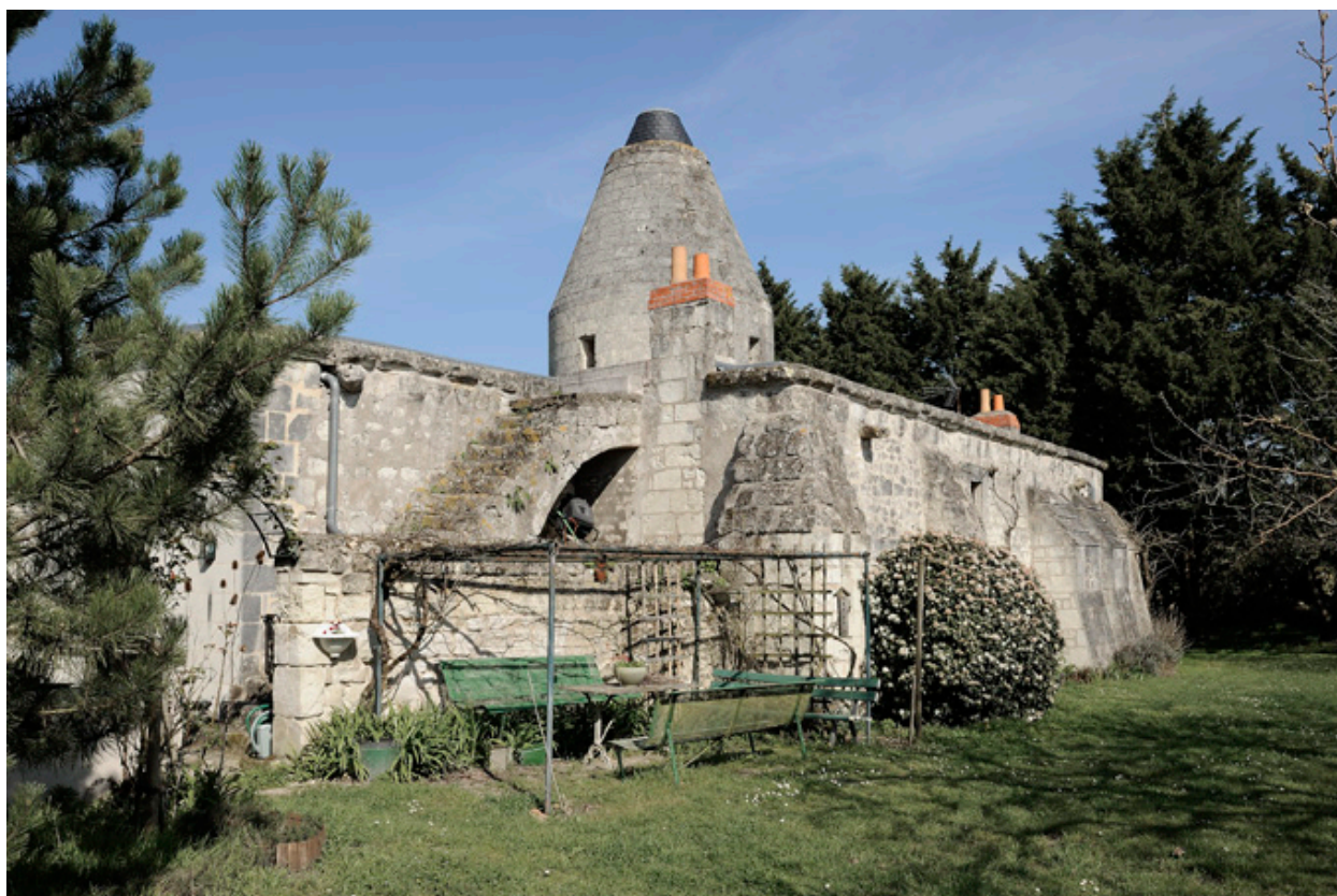
Moulin Neuf : façade sud
