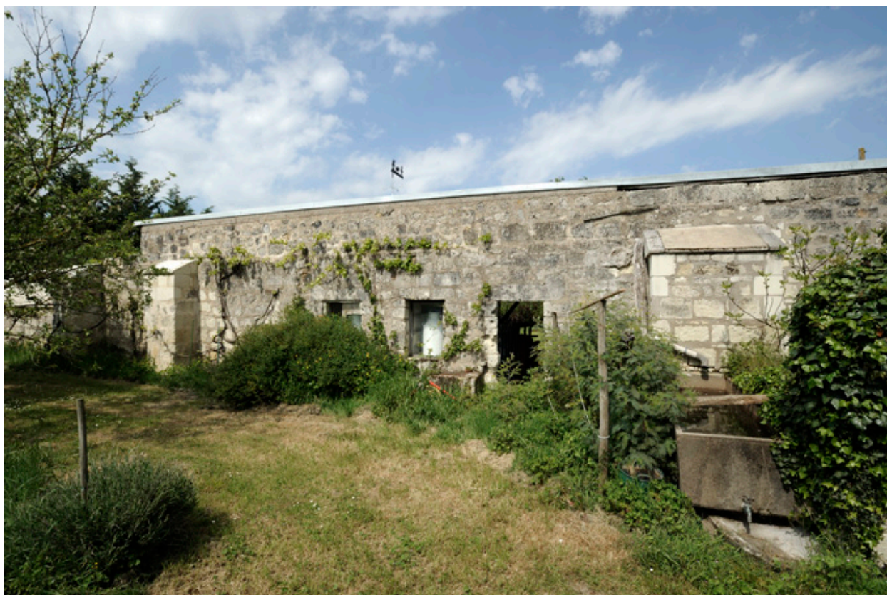
Moulin des Chaffaux : mur sud (extérieur).
