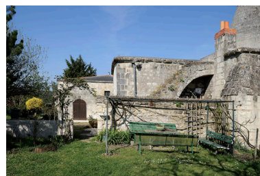
Moulin Neuf : angle sud-ouest. Phot. Bruno Rousseau, Phot. Youenn Communeau IVR52_20114900802NUCA
