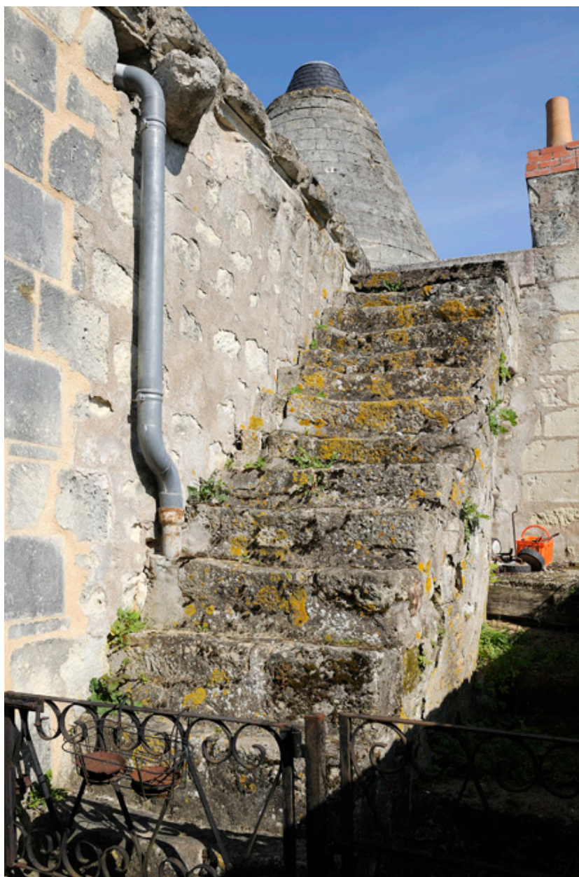
Moulin Neuf : escalier extérieur
