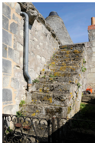
Moulin Neuf : escalier extérieur Phot. Bruno Rousseau, Phot. Youenn Communeau IVR52_20114900800NUCA
