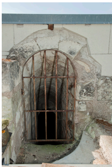
Moulin Neuf : issue de l'escalier intérieur, sur le toit. Phot. Bruno Rousseau, Phot. Youenn Communeau IVR52_20114901695NUCA
