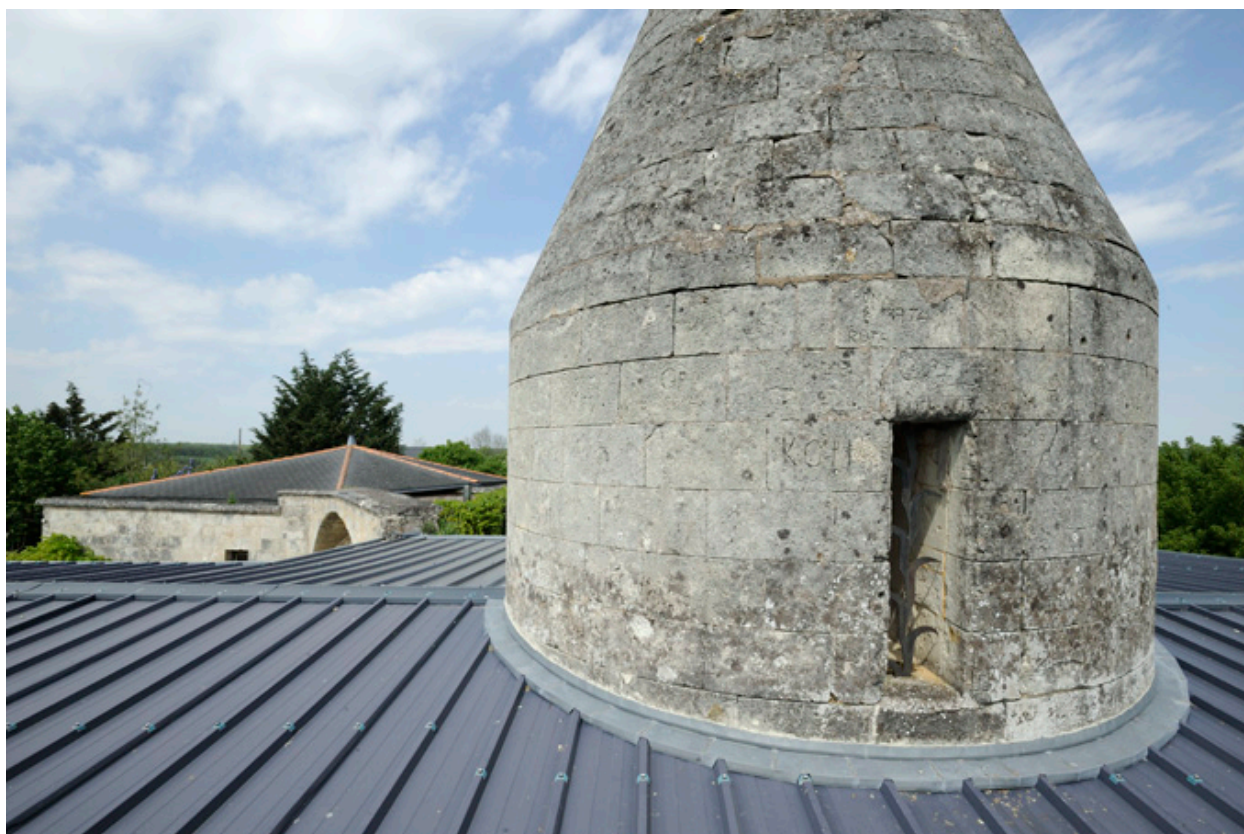
Moulin Neuf : massereau et couverture de la masse.
