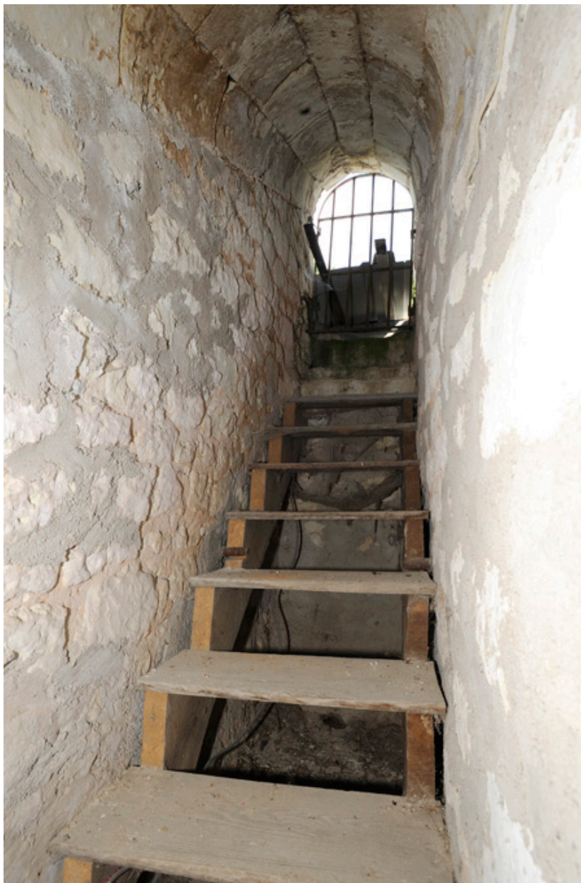
Moulin Neuf (intérieur) : escalier intérieur menant de l'étage au toit.
