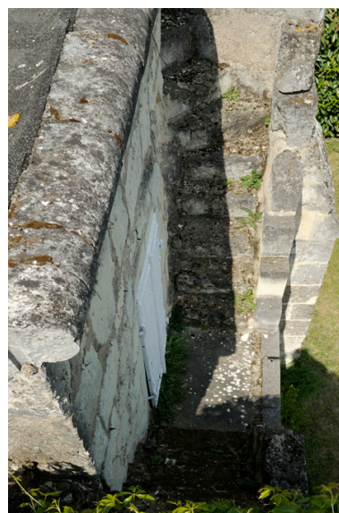
Moulin Picard : volée double à montées divergentes et tournantes, entre le palier de l'étage et la couverture de la masse. Phot. Bruno Rousseau, Phot. Youenn Communeau IVR52_20114901693NUCA
