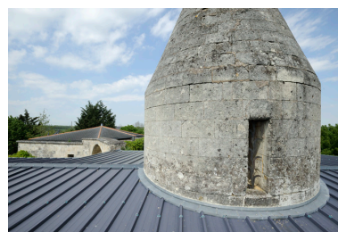
Moulin Neuf : massereau et couverture de la masse. Phot. Bruno Rousseau, Phot. Youenn Communeau IVR52_20114901689NUCA
