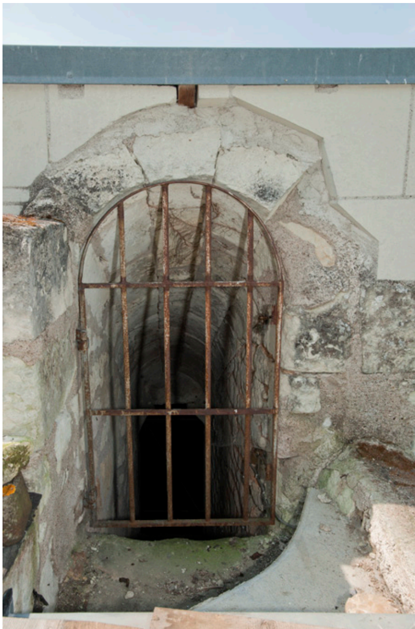
Moulin Neuf : issue de l'escalier intérieur, sur le toit.
