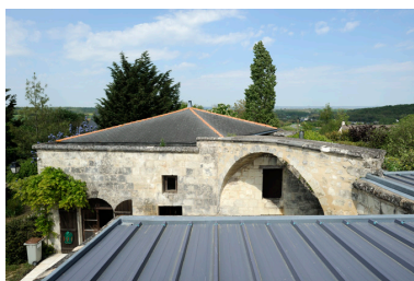
Passerelle de communication entre les couvertures du Moulin Neuf et du Moulin Picard. Phot. Bruno Rousseau, Phot. Youenn Communeau IVR52_20114901691NUCA
