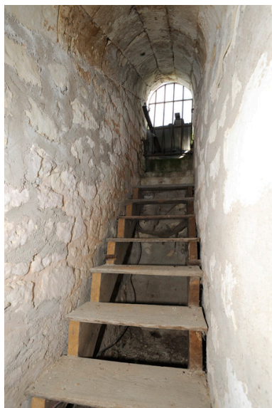
Moulin Neuf (intérieur) : escalier intérieur menant de l'étage au toit. Phot. Bruno Rousseau, Phot. Youenn Communeau IVR52_20114901704NUCA
