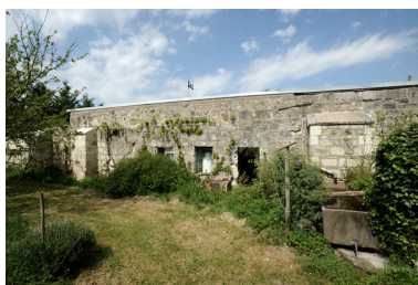
Moulin des Chaffaux : mur sud (extérieur). Phot. Bruno Rousseau, Phot. Youenn Communeau IVR52_20114901685NUCA
