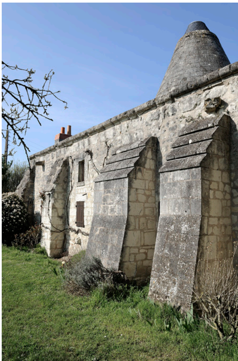
Moulin Neuf : contreforts de la façade sud
