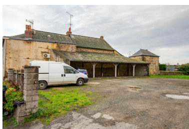
La cour et l'ancien préau. Phot. Pierre-Bernard Fourny IVR52_20225300982NUCA
