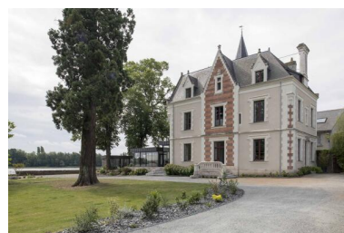
Vue d'ensemble depuis le nord. Phot. Armelle Maugin IVR52_20194900538NUCA
