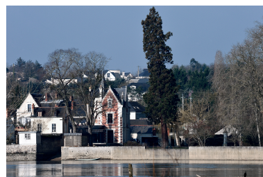
Vue d'ensemble depuis la Loire. Phot. Bruno Rousseau IVR52_20164900177NUCA
