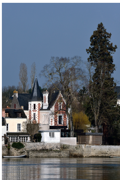
Vue d'ensemble depuis la Loire. Phot. Bruno Rousseau IVR52_20164900193NUCA
