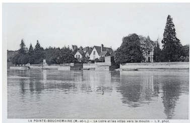
La Loire et les villas vers le moulin. L.V Phot. Repro. Bruno Rousseau IVR52_20134900383NUCA
