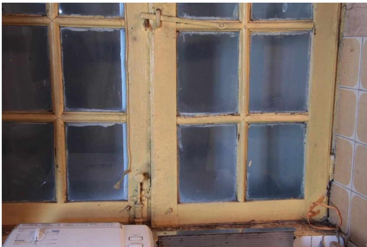
Aile en retour dans la ruelle : menuiserie de baie à petits bois et targette XVIIIe siècle.
