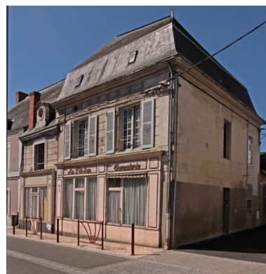
Vue de volume prise de la place Neuve. Phot. Jean-Baptiste Darrasse IVR52_20107201734NUCA
