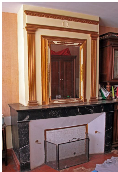
Rez-de-chaussée sur rue, la salle à manger : cheminée du XIXe siècle. Phot. Jean-Baptiste Darrasse IVR52_20107201742NUCA
