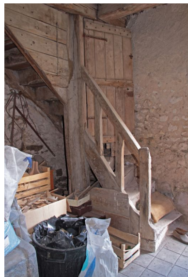
Les communs : escalier. Phot. Jean-Baptiste Darrasse IVR52_20107201743NUCA
