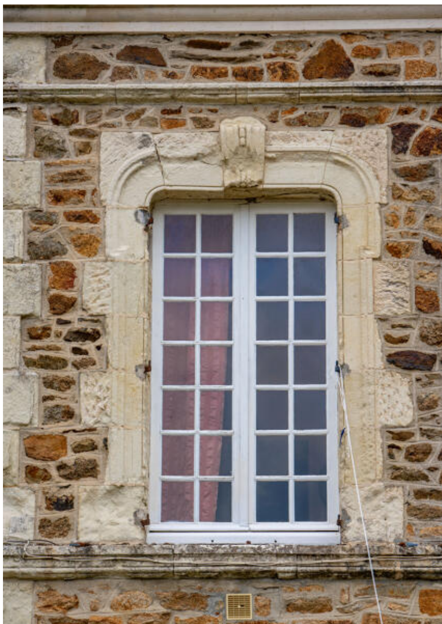
La fenêtre de la travée centrale.
