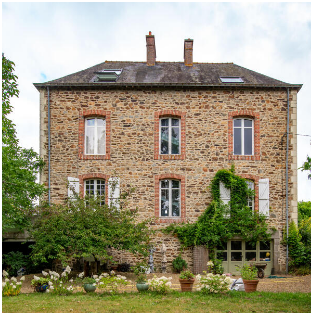
La façade postérieure.
