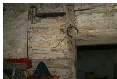
La buanderie : cloison en pan-de-bois. Phot. Jean-Baptiste Darrasse IVR52_20067207629NUCA
