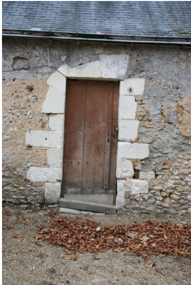
Porte d'entrée de l'écurie. Phot. Jean-Baptiste Darrasse IVR52_20067207631NUCA
