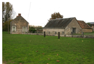
Vue d'ensemble prise de la vieille route de La Flèche. Phot. Jean-Baptiste Darrasse IVR52_20067207638NUCA
