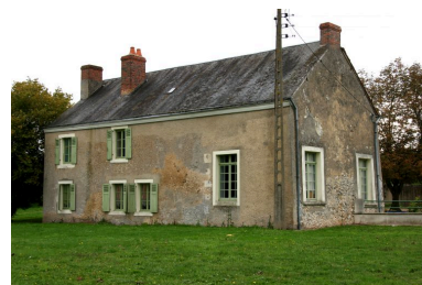
Vue de volume de la façade postérieure. Phot. Jean-Baptiste Darrasse IVR52_20067207640NUCA
