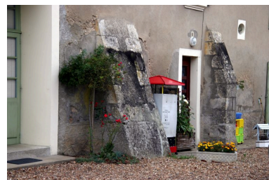
Façade antérieure sur cour, détail : contrefort. Phot. Jean-Baptiste Darrasse IVR52_20067207634NUCA
