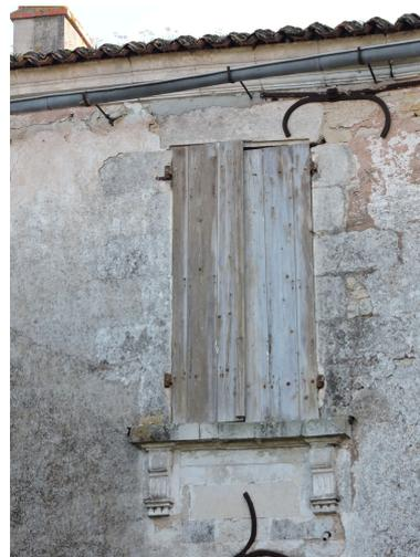
Appui de fenêtre avec consoles
