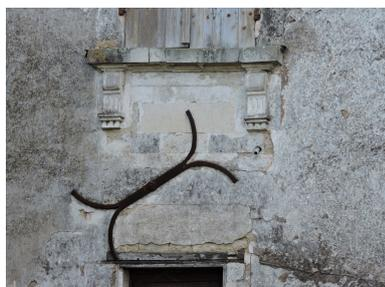
Appui de fenêtre avec consoles
