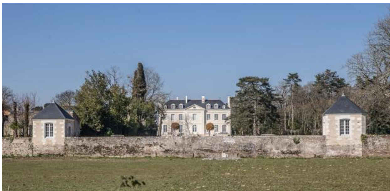
Façade sud sur jardin et pavillons.
