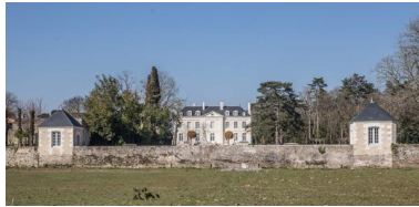
Façade sud sur jardin et pavillons. Phot. Pierre-Bernard Fourny IVR52_20194400161NUCA
