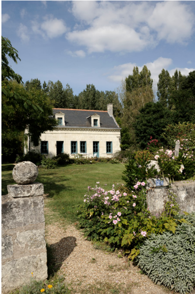
Vue d'ensemble depuis la rue.
