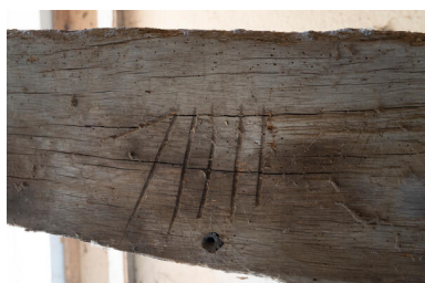
Charpente de la grange, détail du marquage. Phot. Thierry Seldubuisson IVR52_20235300414NUCA
