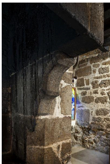
Corbeau droit de la cheminée. Phot. Yves Guillotin IVR52_20195301274NUCA
