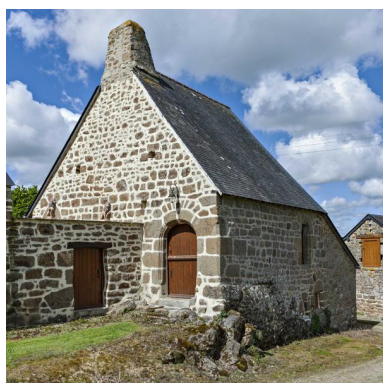
Manoir de la Fortinière. Phot. Yves Guillotin IVR52_20215300605NUCA
