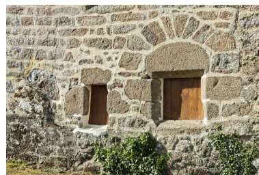
Baies de la cave, façade nord. Phot. Yves Guillotin IVR52_20215300649NUCA
