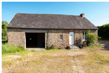
Vue extérieure de la grange à structure poteaux. Phot. Thierry Seldubuisson IVR52_20235300411NUCA
