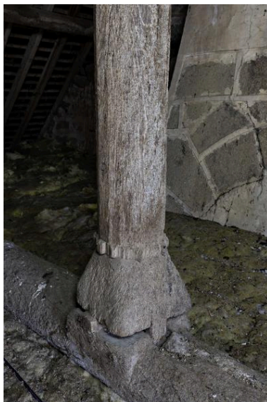
Charpente. Détail de la base du poinçon. Phot. Yves Guillotin IVR52_20195301269NUCA
