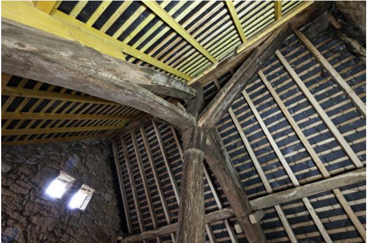
Charpente. Partie haute.
