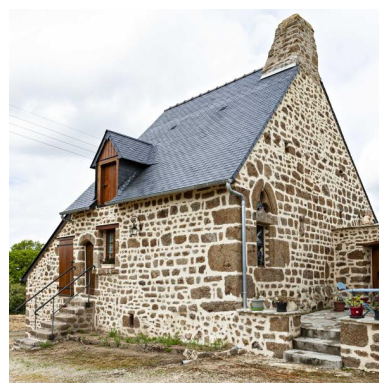
Manoir de la Fortinière, vu depuis le sud-est. Phot. Yves Guillotin IVR52_20215300581NUCA
