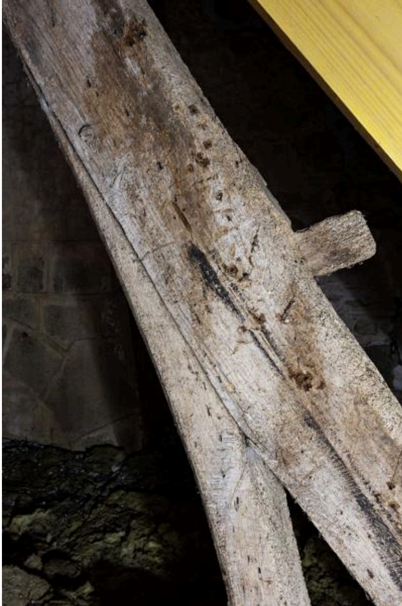
Charpente. Détail de l'assemblage de l'arbalétrier sud et de la jambette.
