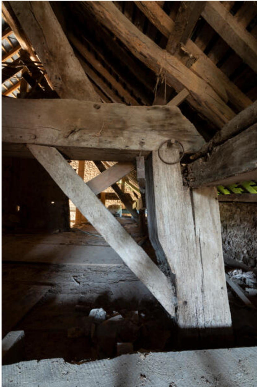
Détail de l'assemblage entrain, poteau, sablière.
