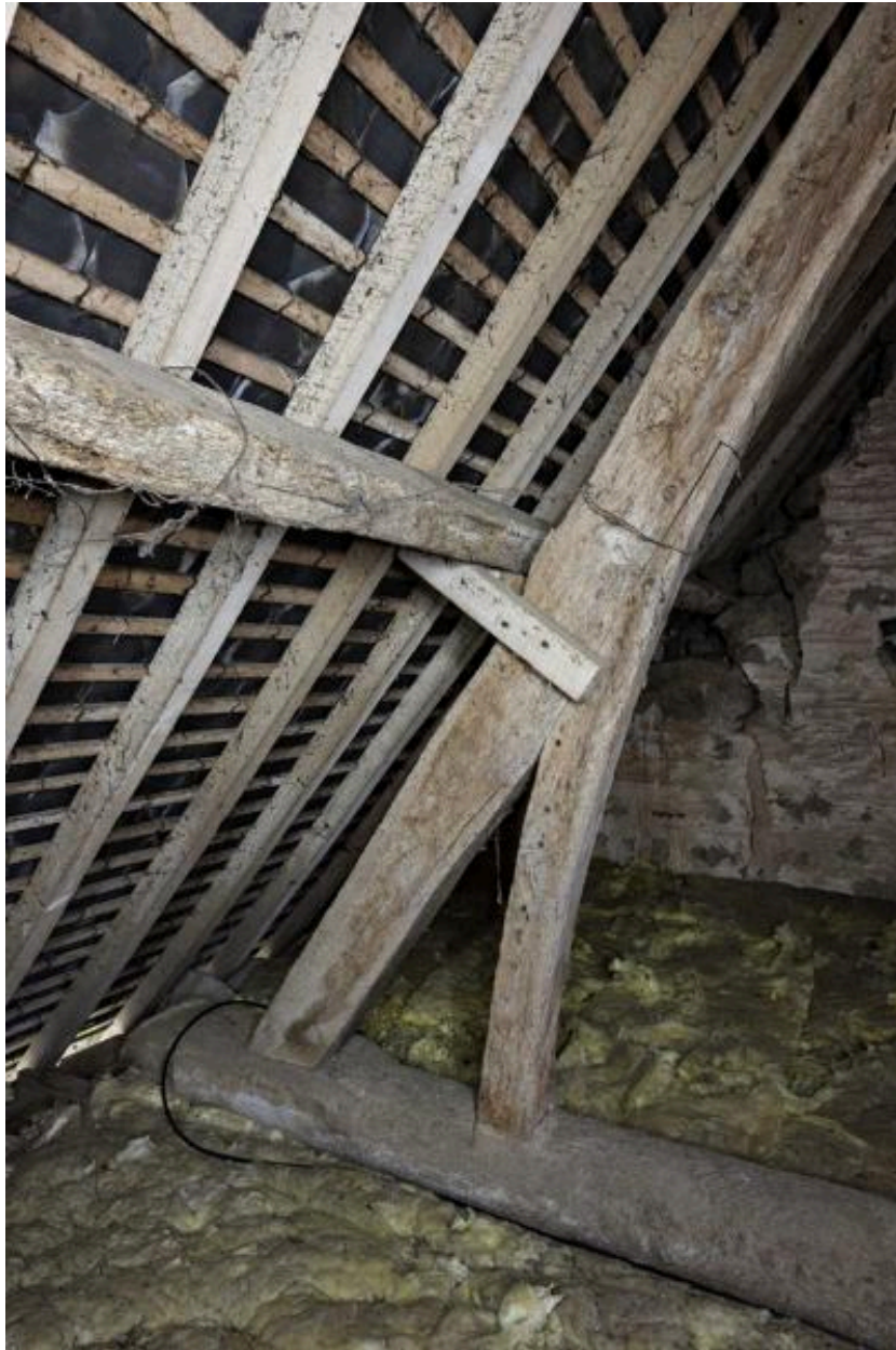
Charpente. Arbalétrier et jambette nord.
