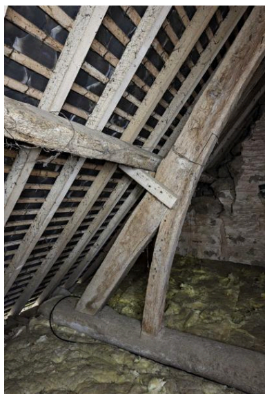
Charpente. Arbalétrier et jambette nord. Phot. Yves Guillotin IVR52_20195301272NUCA
