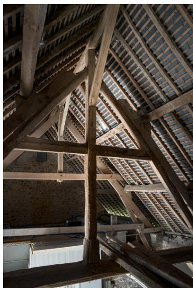
Charpente de la grange, ferme centrale. Phot. Thierry Seldubuisson IVR52_20235300432NUCA
