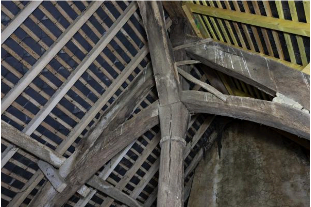
Charpente. Haut du poinçon et liens.
