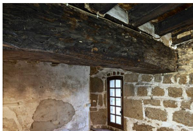
Mur-gouttereau nord et poutre transversale. Phot. Yves Guillotin IVR52_20195301281NUCA
