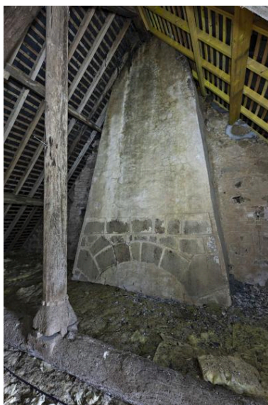
Poinçon et arc de décharge souligné d'enduit du manteau de cheminée. Phot. Yves Guillotin IVR52_20195301270NUCA
