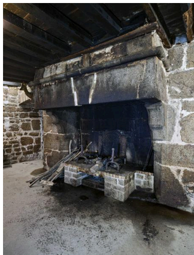
Cheminée de la salle basse. Phot. Yves Guillotin IVR52_20195301273NUCA
