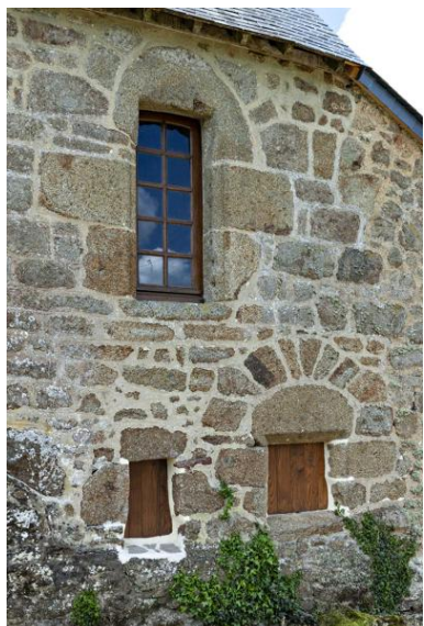
Baies de la façade nord. Phot. Yves Guillotin IVR52_20215300608NUCA
