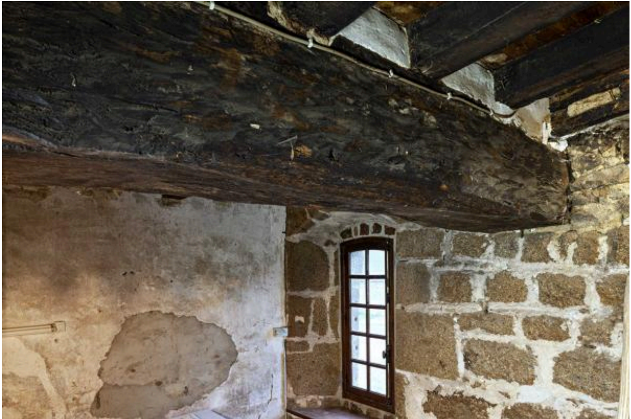
Mur-gouttereau nord et poutre transversale.
