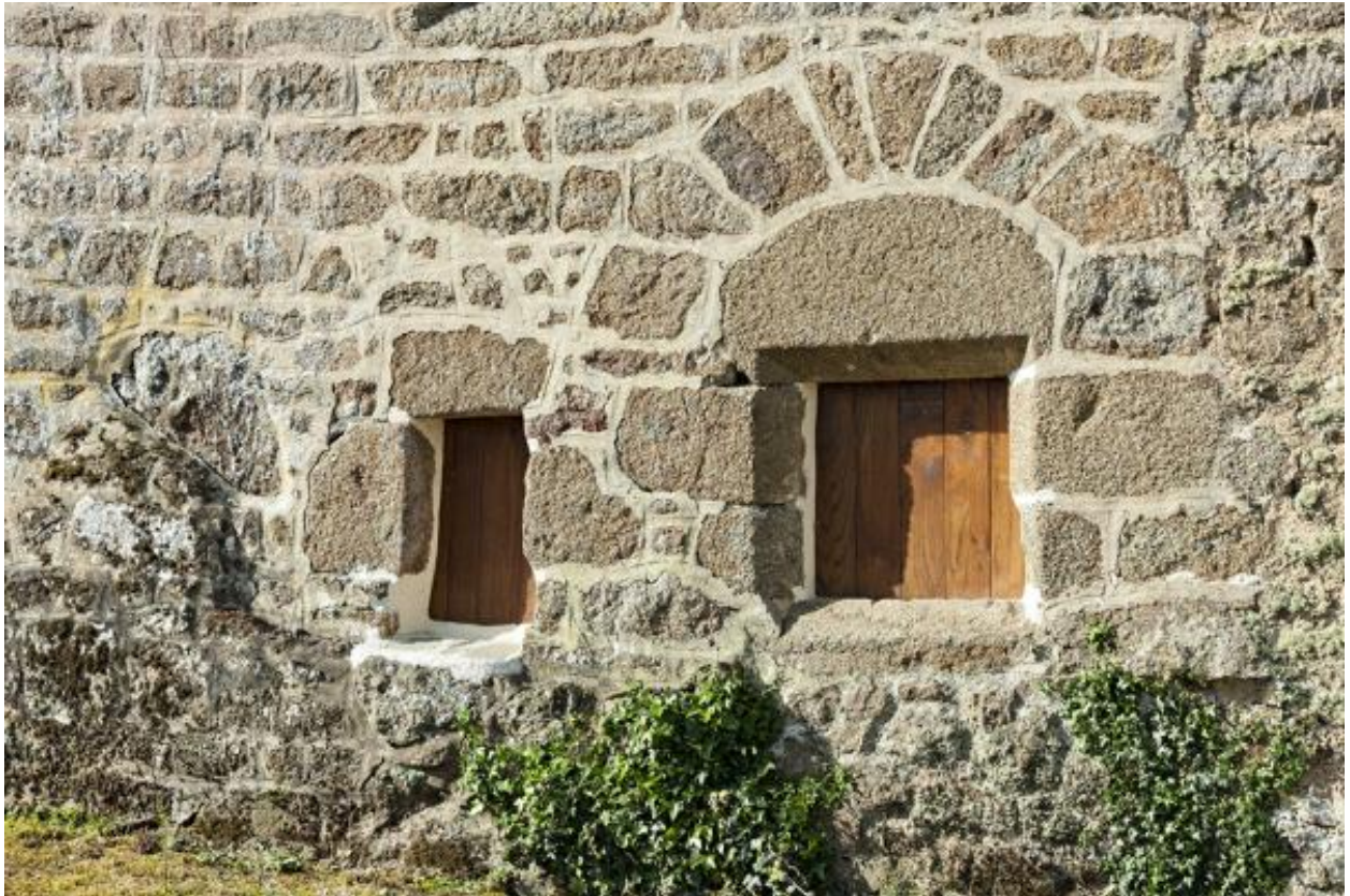
Baies de la cave, façade nord.
