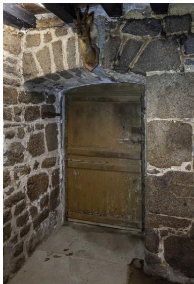
Revers de la porte du mur-pignon oriental. Phot. Yves Guillotin IVR52_20195301277NUCA
