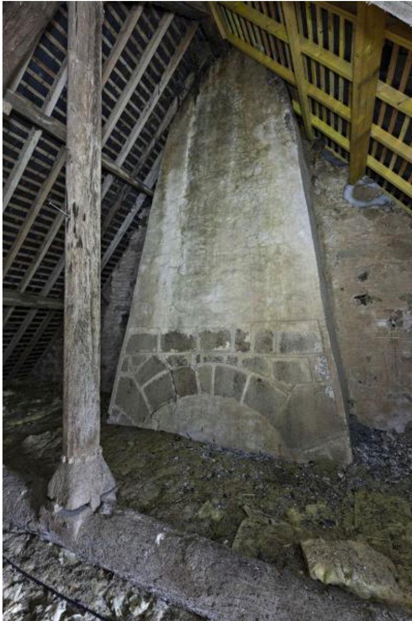
Poinçon et arc de décharge souligné d'enduit du manteau de cheminée.
