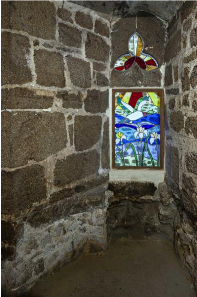
Ebrasement intérieur de la baie trilobée.
