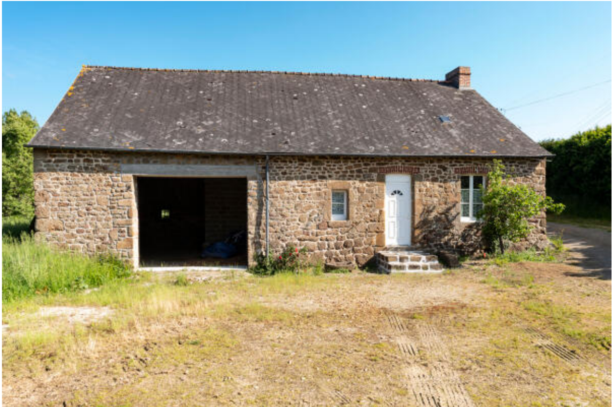
Vue extérieure de la grange à structure poteaux.
