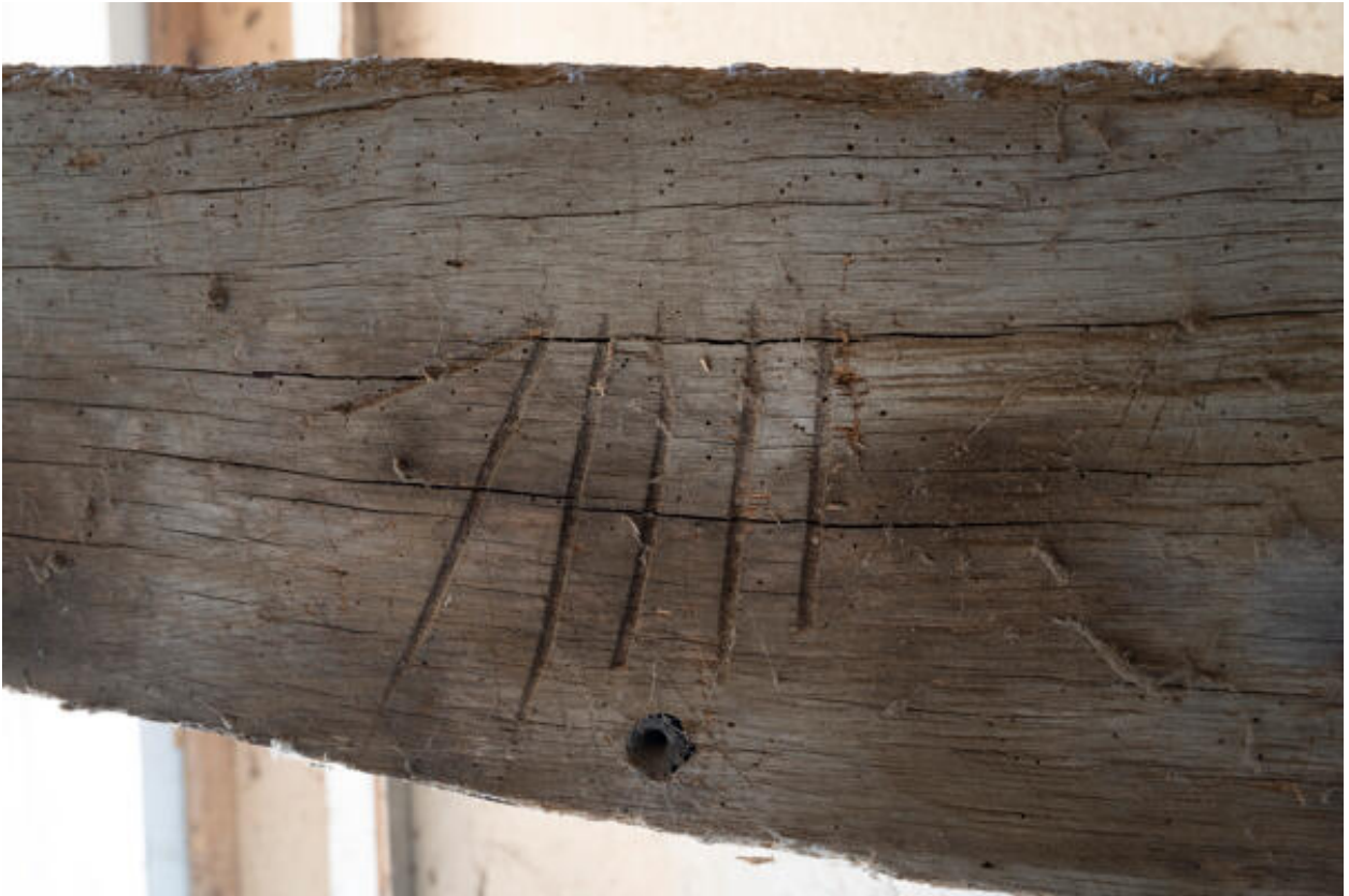
Charpente de la grange, détail du marquage.
