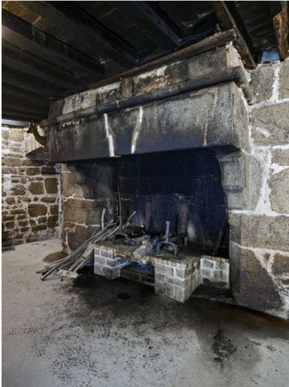
Cheminée de la salle basse.
