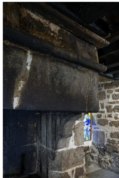
Corbeau droit de la cheminée. Phot. Yves Guillotin IVR52_20195301275NUCA
