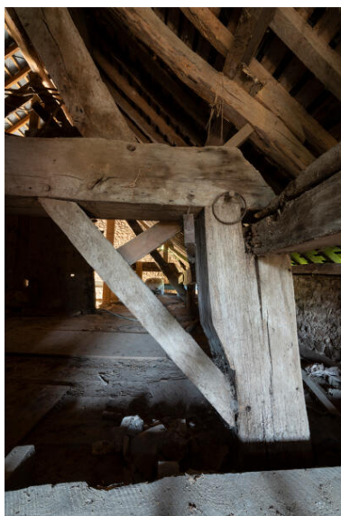
Détail de l'assemblage entrain, poteau, sablière. Phot. Thierry Seldubuisson IVR52_20235300413NUCA
