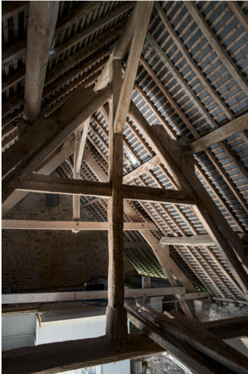
Charpente de la grange, ferme centrale.
