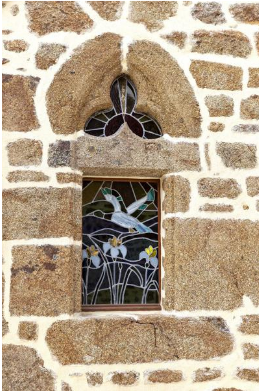
Baie trilobée du mur-pignon oriental.
