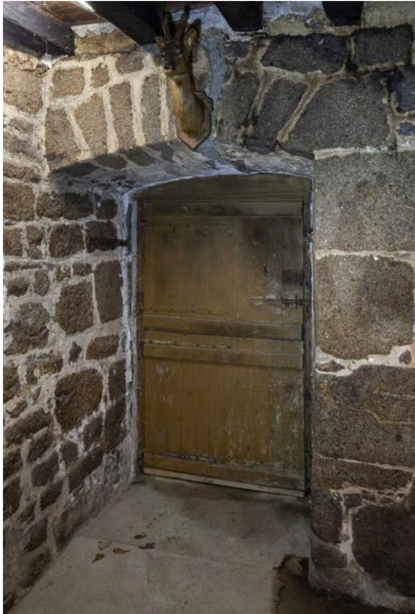
Revers de la porte du mur-pignon oriental.
