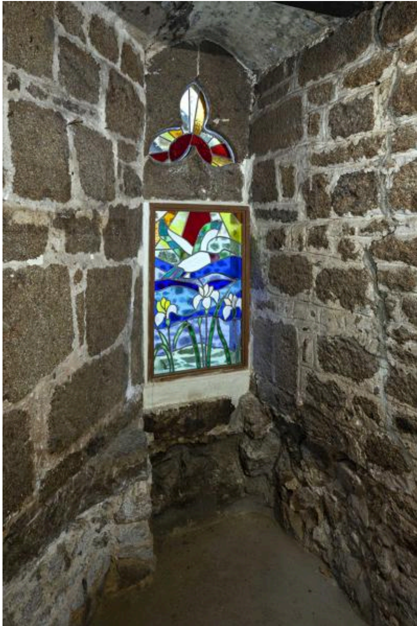
Ebrasement intérieur de la baie trilobée.
