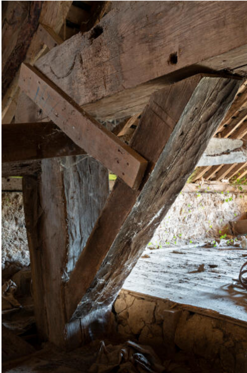
Assemblage entrain, poteau, sablière : détail du marquage et traces de doloir sous le lien.
