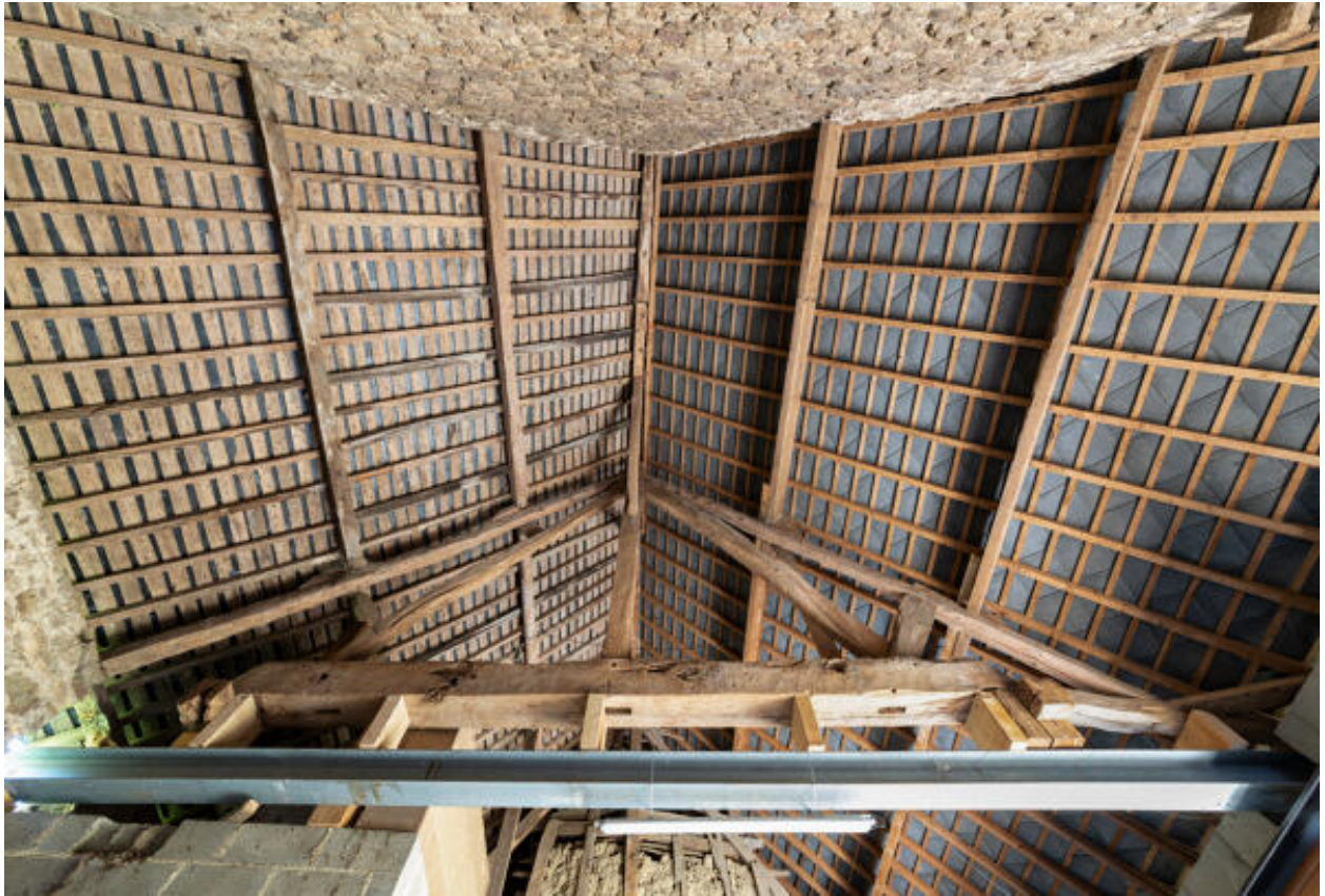
Ferme de charpente à poteaux porteurs.
