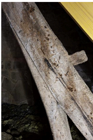
Charpente. Détail de l'assemblage de l'arbalétrier sud et de la jambette. Phot. Yves Guillotin IVR52_20195301268NUCA
