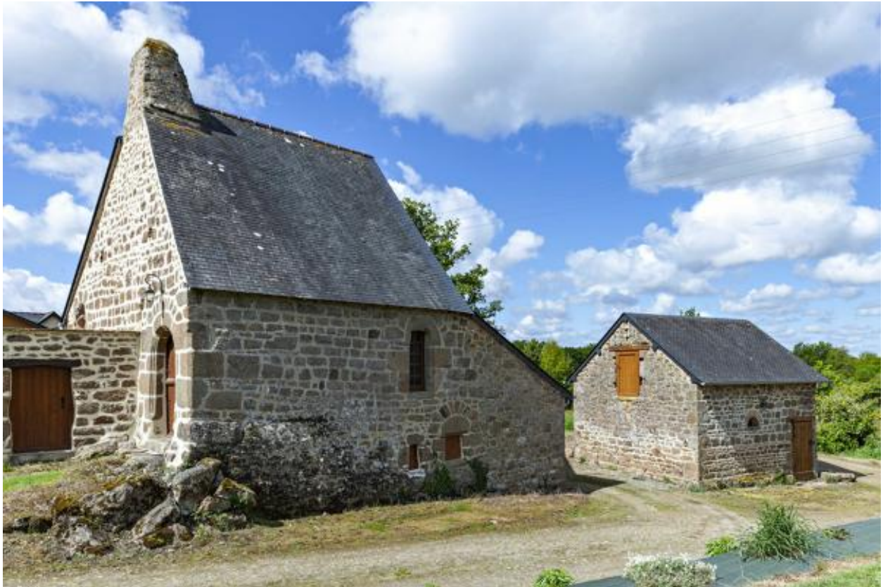
Manoir de la Fortinière et remise, vus depuis le nord.
