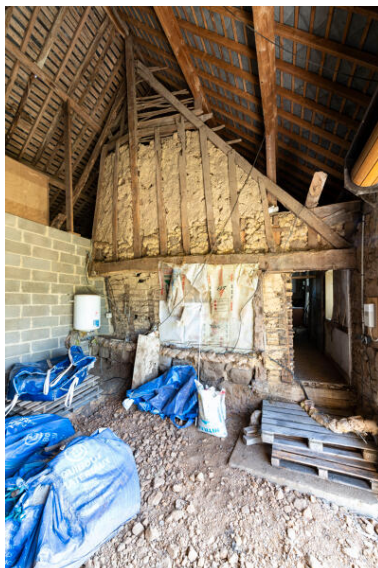
Ferme de charpente centrale. Phot. Thierry Seldubuisson IVR52_20235300410NUCA
