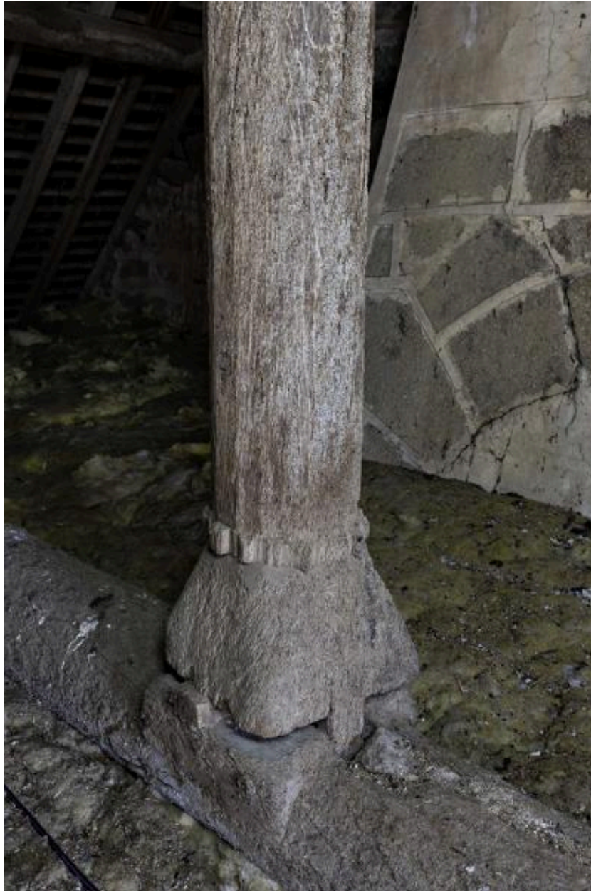
Charpente. Détail de la base du poinçon.
