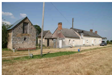
La Beusseraie : ferme. Phot. Jean-Baptiste Darrasse IVR52_20067206107NUCA
