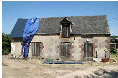
Hameau de la Bordelière : toits à porcs. Phot. Jean-Baptiste Darrasse IVR52_20067205788NUCA
