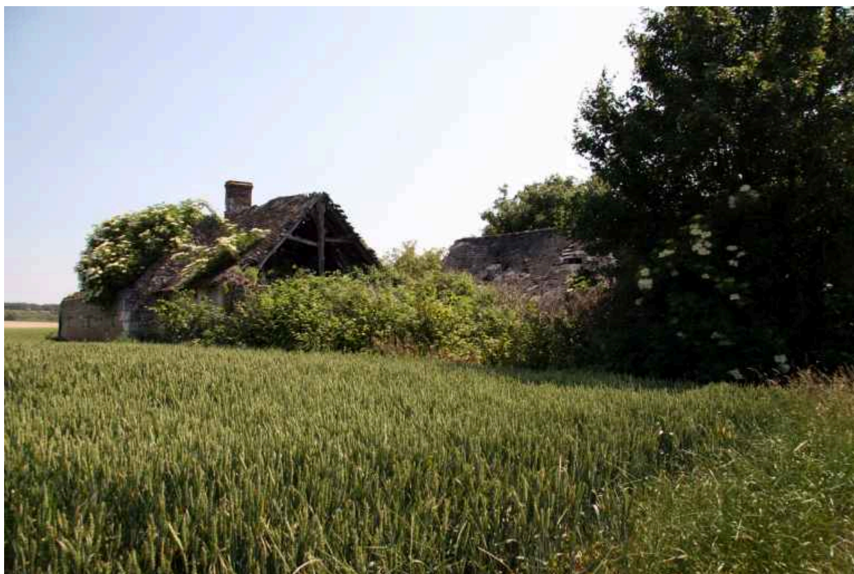
La Cheminée : vue d'ensemble.
