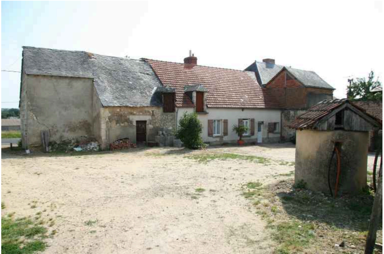
Le Raillon, maison 2 : façade sur cour.
