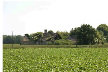
La Cheminée : vue d'ensemble de la 1ère maison. Phot. Jean-Baptiste Darrasse IVR52_20067205645NUCA
