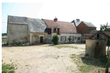
Le Raillon, maison 2 : façade sur cour. Phot. Jean-Baptiste Darrasse IVR52_20067206032NUCA
