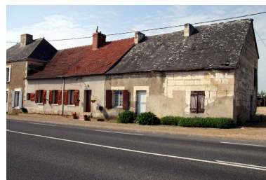
Le Raillon, maison 2 : façade sur la route de Château-la-Vallière. Phot. Jean-Baptiste Darrasse IVR52_20067206031NUCA
