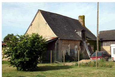
Les Piclinières : maison. Phot. Jean-Baptiste Darrasse IVR52_20067205725NUCA
