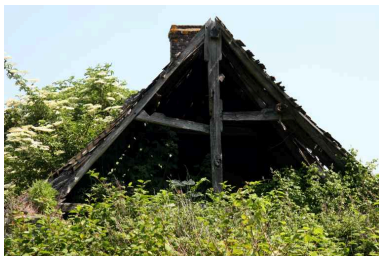
La Cheminée, ferme : charpente. Phot. Jean-Baptiste Darrasse IVR52_20067205642NUCA
