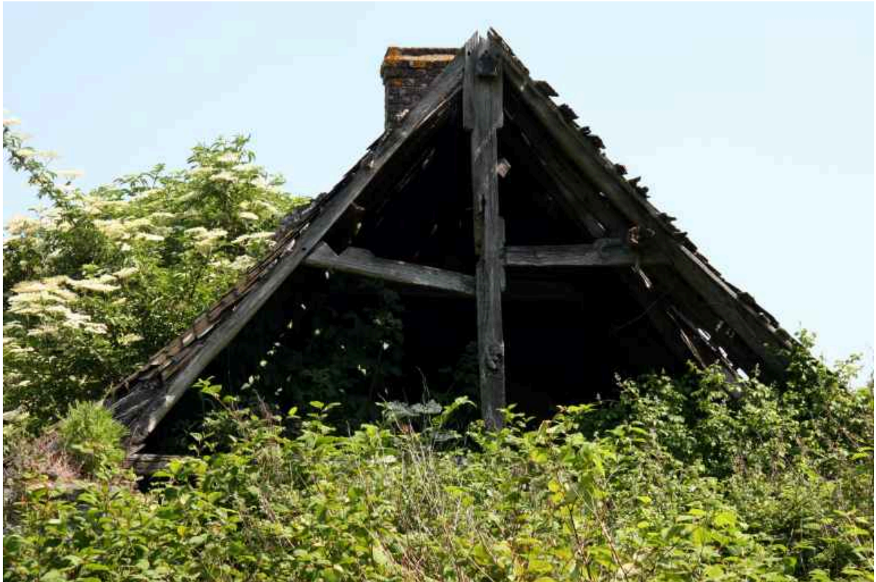
La Cheminée, ferme : charpente.
