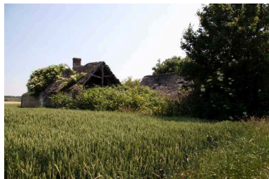
La Cheminée : vue d'ensemble. Phot. Jean-Baptiste Darrasse IVR52_20067205641NUCA
