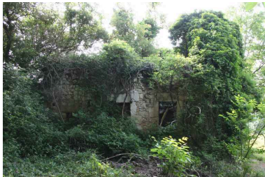
La Chemelière : ferme en ruine. Phot. Jean-Baptiste Darrasse IVR52_20067206124NUCA
