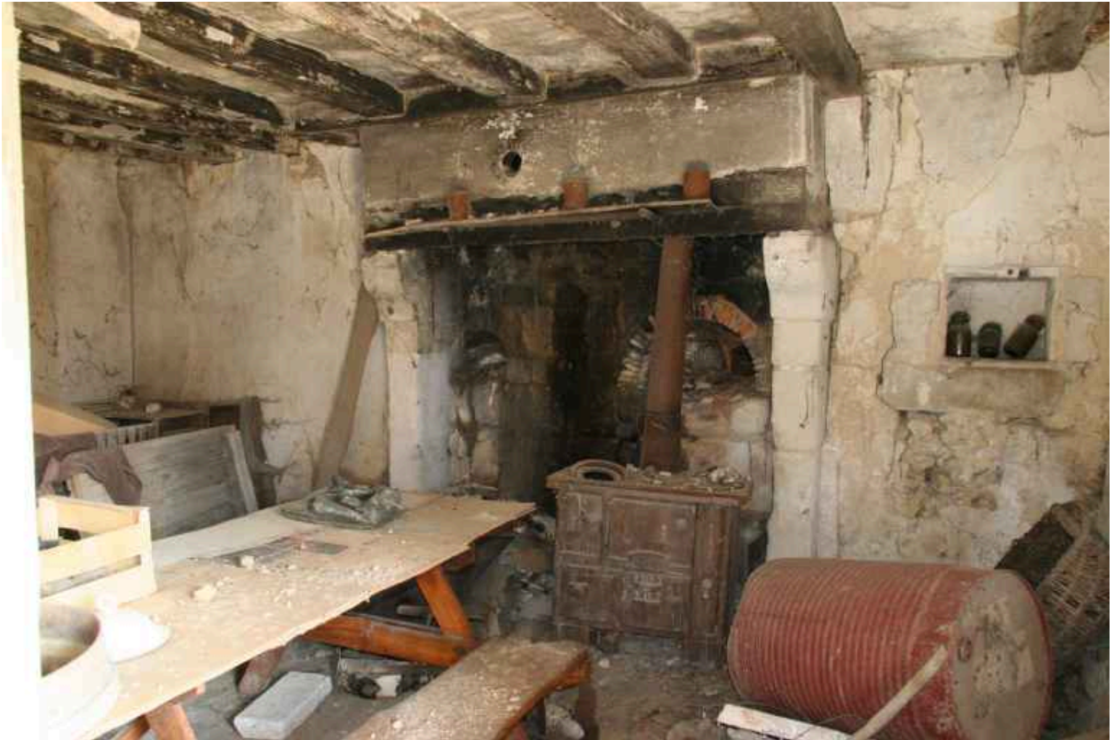
La Tacheraie, maison : cheminée.
