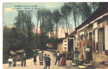
Carrefour de Broc : maison Maupas. Phot. Jean-Baptiste (reproduction) Darrasse IVR52_20067205320NUCA
