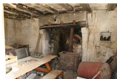
La Tacheraie, maison : cheminée. Phot. Jean-Baptiste Darrasse IVR52_20067205990NUCA
