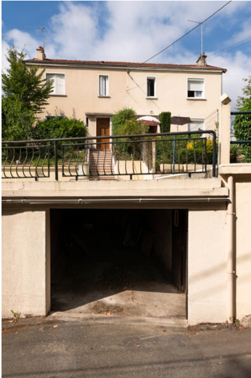
Vue de maisons doubles avec terrassement, impasse du Tyrol.
