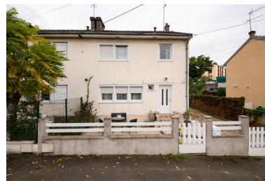
Vue d'un pavillon, cité du Gibet. Phot. Thierry Seldubuisson IVR52_20227201264NUCA
