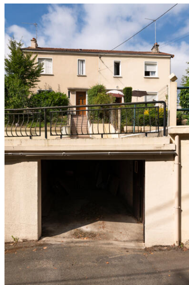
Vue de maisons doubles avec terrassment, impasse du Tyrol. Phot. Thierry Seldubuisson IVR52_20227200934NUCA
