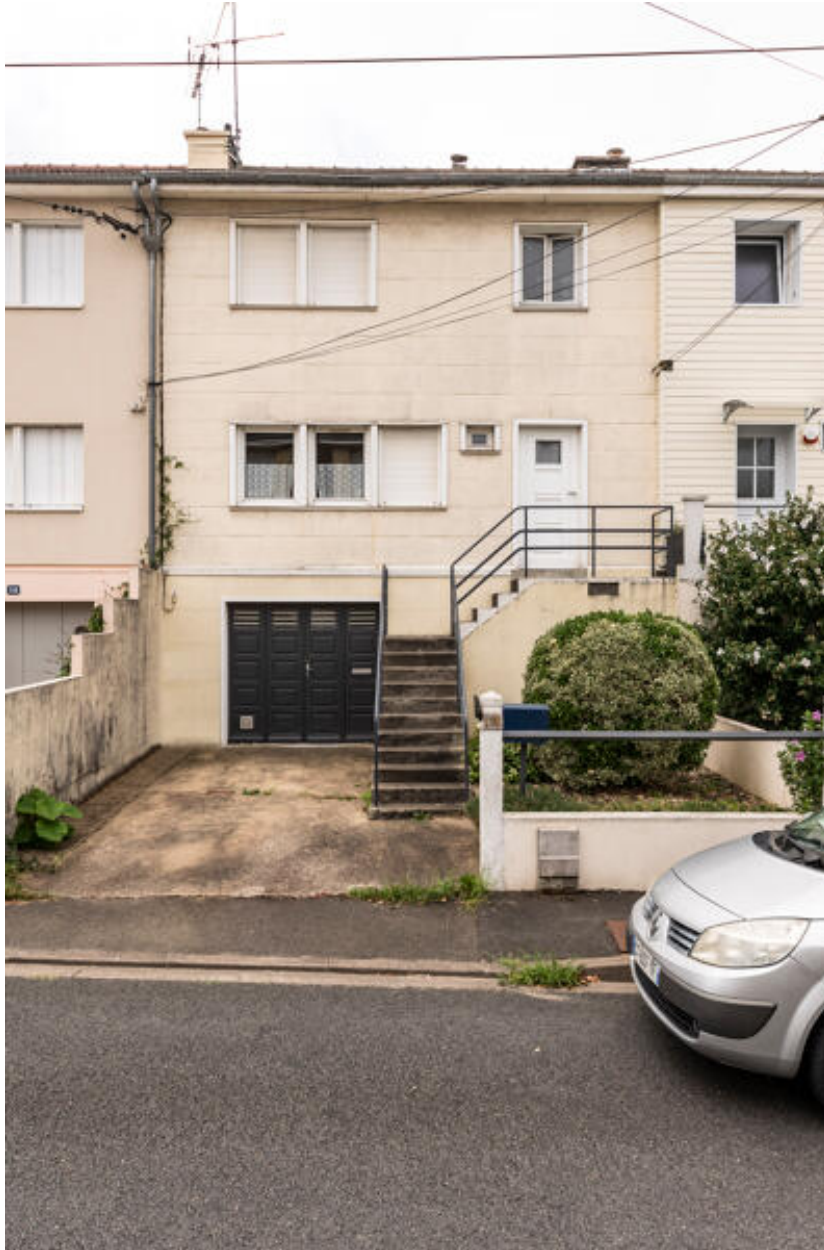
Vue d'une maison phénix au lotissement Bobette.
