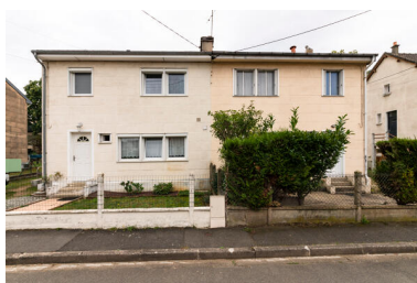
Vue de pavillons jumeaux, cité du Gibet. Phot. Thierry Seldubuisson IVR52_20227201261NUCA
