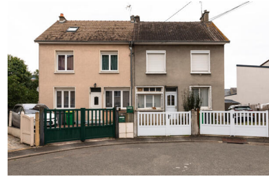
Vue de pavillons jumeaux dans la raquette de retournement de la cité du Gibet. Phot. Thierry Seldubuisson IVR52_20227201263NUCA
