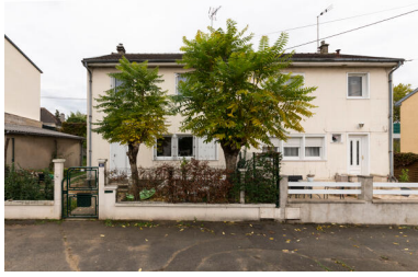
Vue de pavillons jumeaux, cité du Gibet. Phot. Thierry Seldubuisson IVR52_20227201265NUCA
