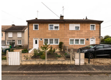
Vue de pavillons jumeaux, cité du Gibet. Phot. Thierry Seldubuisson IVR52_20227201262NUCA
