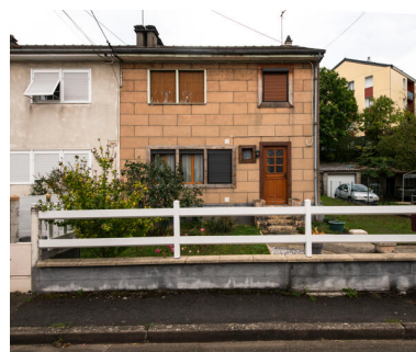
Vue d'un pavillon avec faux joint en façade, cité du Gibet. Phot. Thierry Seldubuisson IVR52_20227201260NUCA
