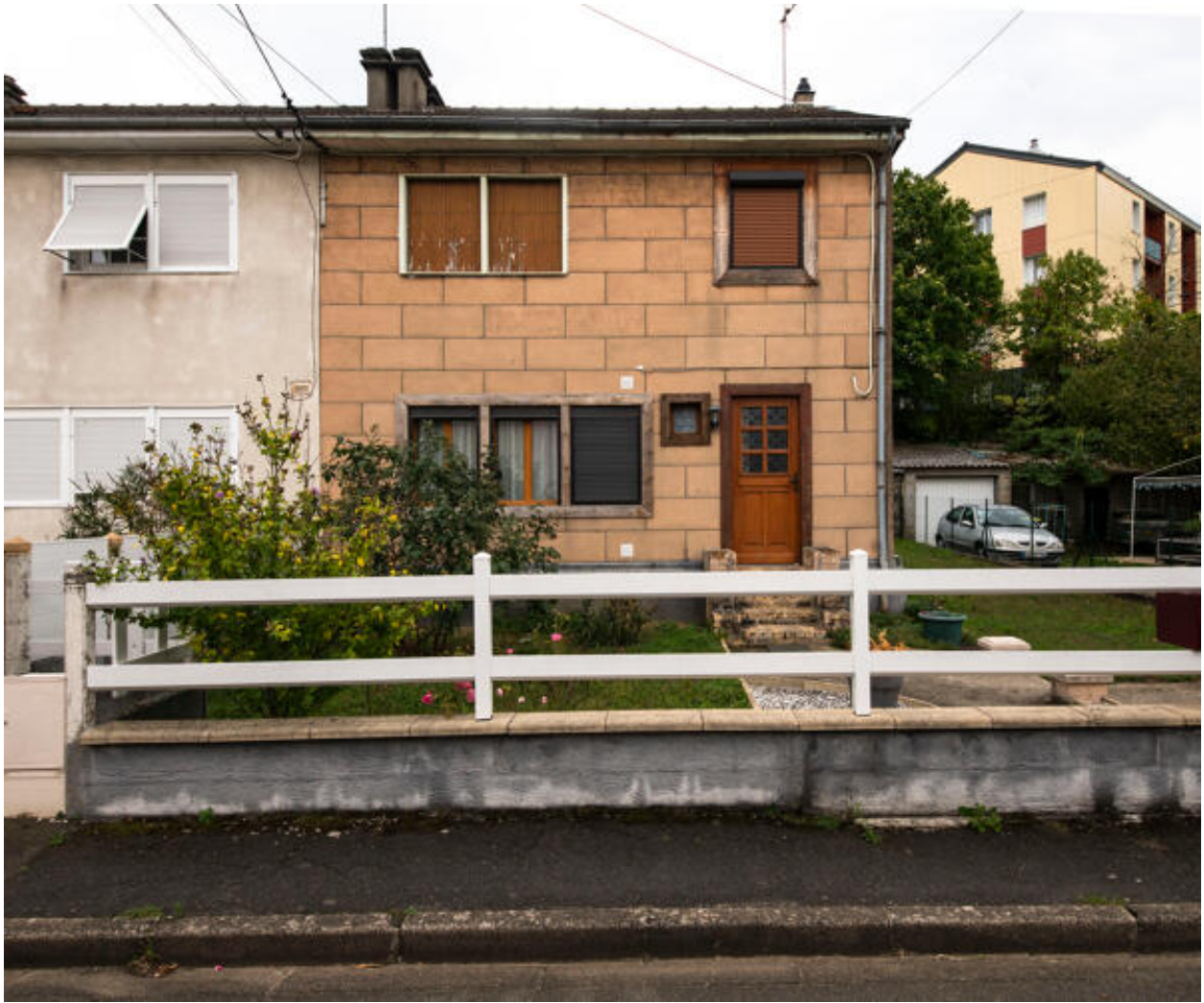
Vue d'un pavillon avec faux joint en façade, cité du Gibet.
