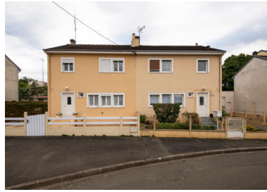
Vue de pavillons jumeaux, cité du Gibet. Phot. Thierry Seldubuisson IVR52_20227201259NUCA
