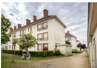
Vue des espaces verts entre les immeubles à logements. Phot. Pierre-Bernard Fourny IVR52_20217200702NUCA
