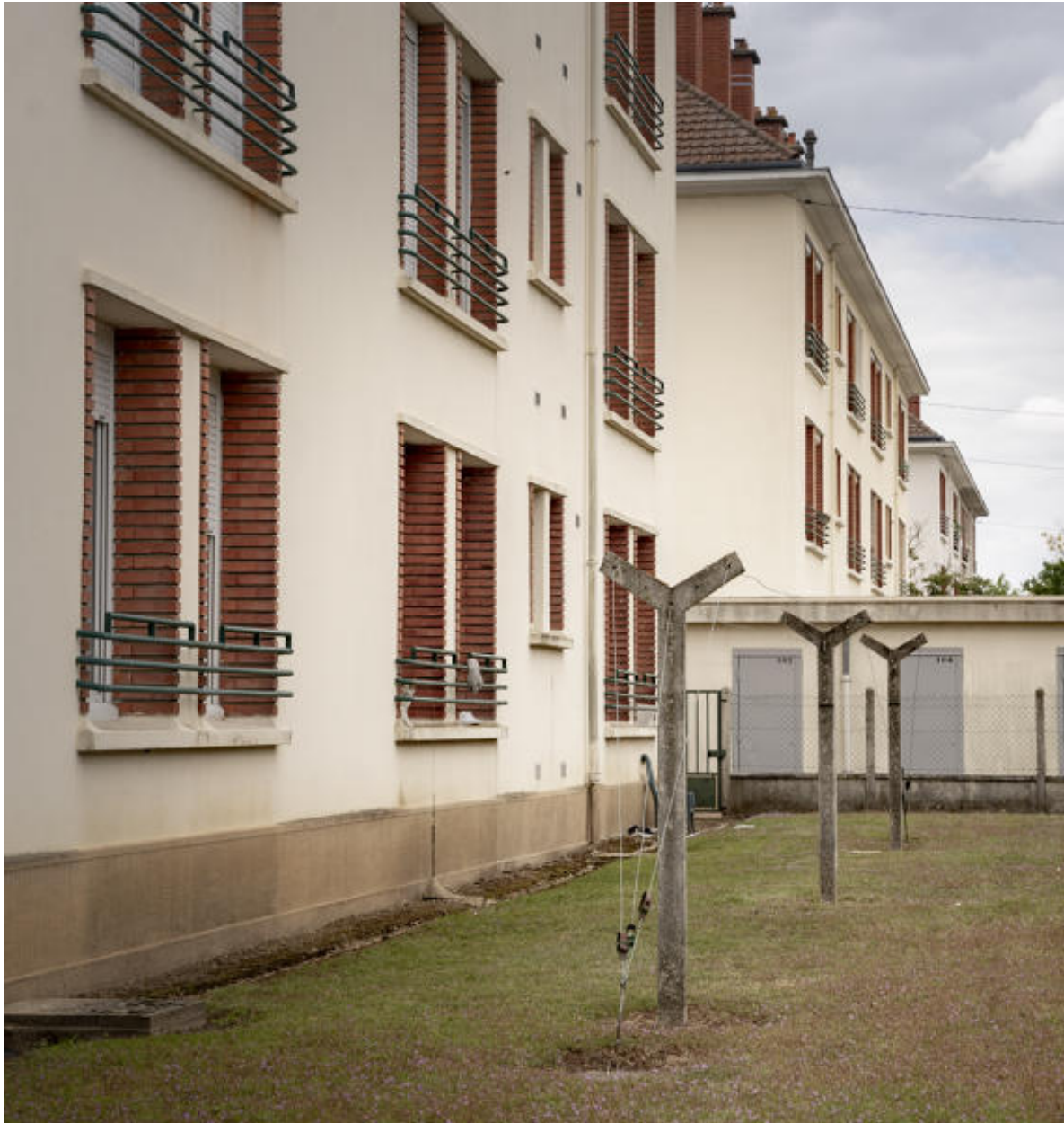
Vue d'un espace commun de séchage.
