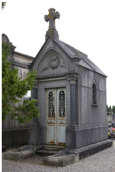
Vue d'ensemble. Phot. François Lasa IVR52_20085300897NUCA
