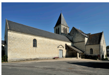
Vue générale. Phot. Bruno Rousseau, Phot. Youenn Communeau IVR52_20114902653NUCA
