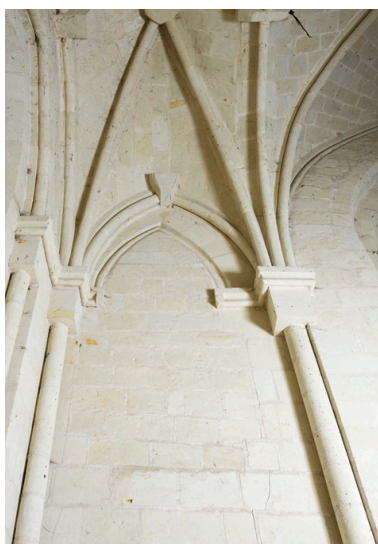
Chapelle nord du transept, traces d'une baie obturée dans le mur situé entre le chœur et cette chapelle, pour confortement du pilier de croisée.
