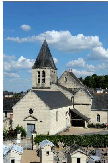
Vue d'ensemble de l'église. Phot. Bruno Rousseau IVR52_20134901612NUCA
