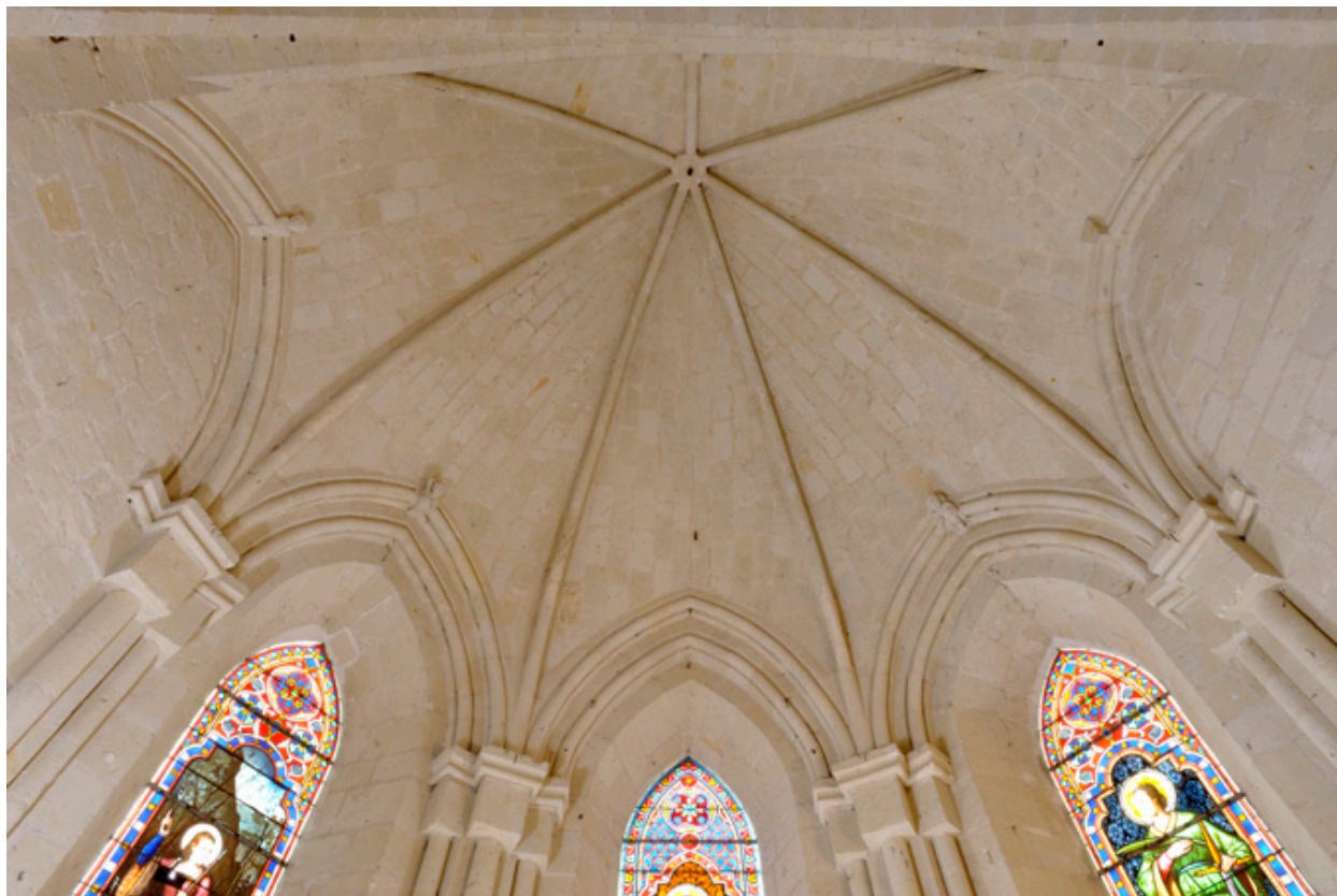
Voûte d'ogives du chœur.
