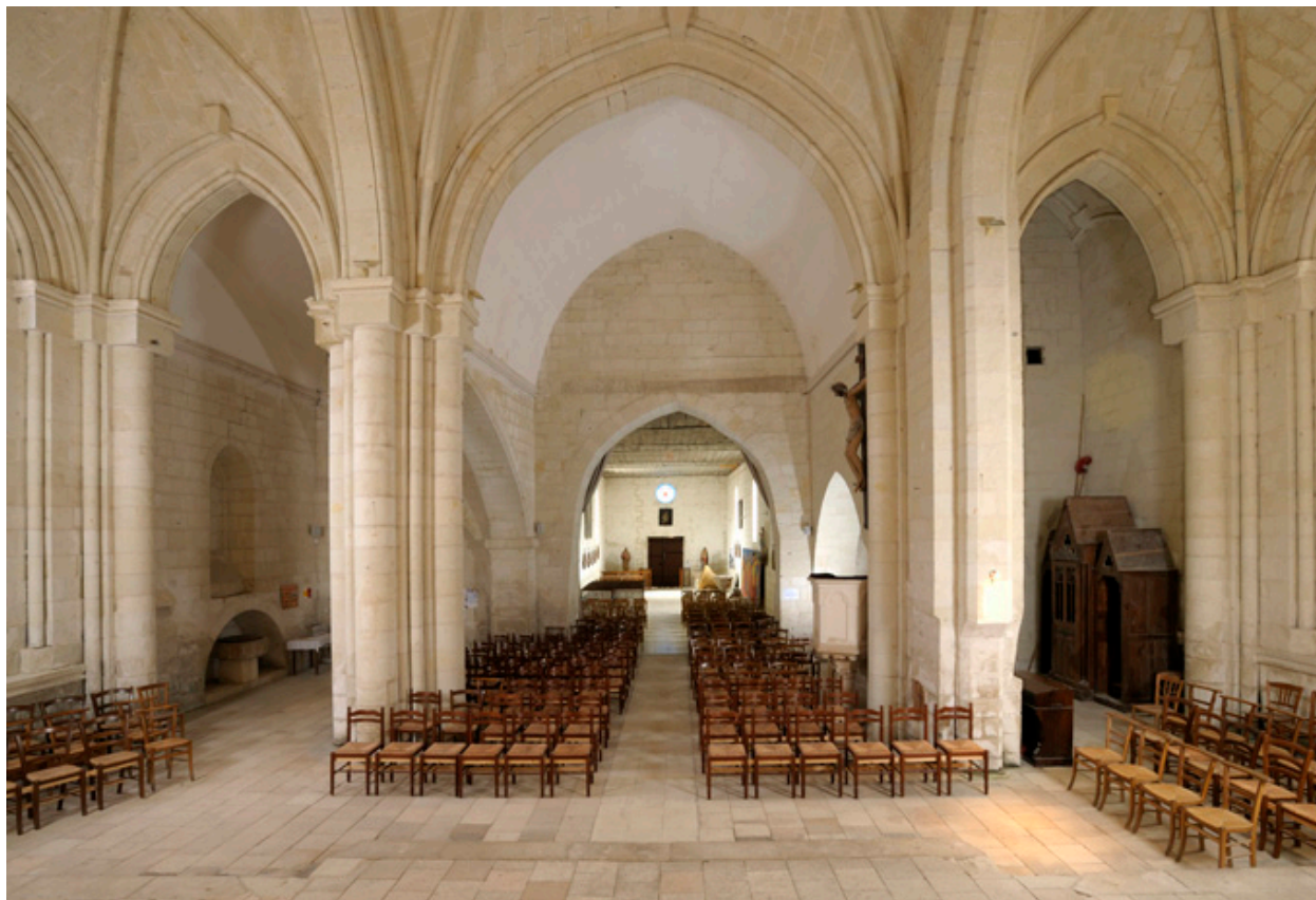
La nef et les travées collatérales, vues du chœur.
