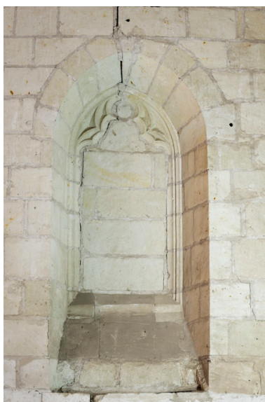
Collatéral sud, baie (obturée) de la première travée en partant du transept. Phot. Bruno Rousseau IVR52_20124901197NUCA
