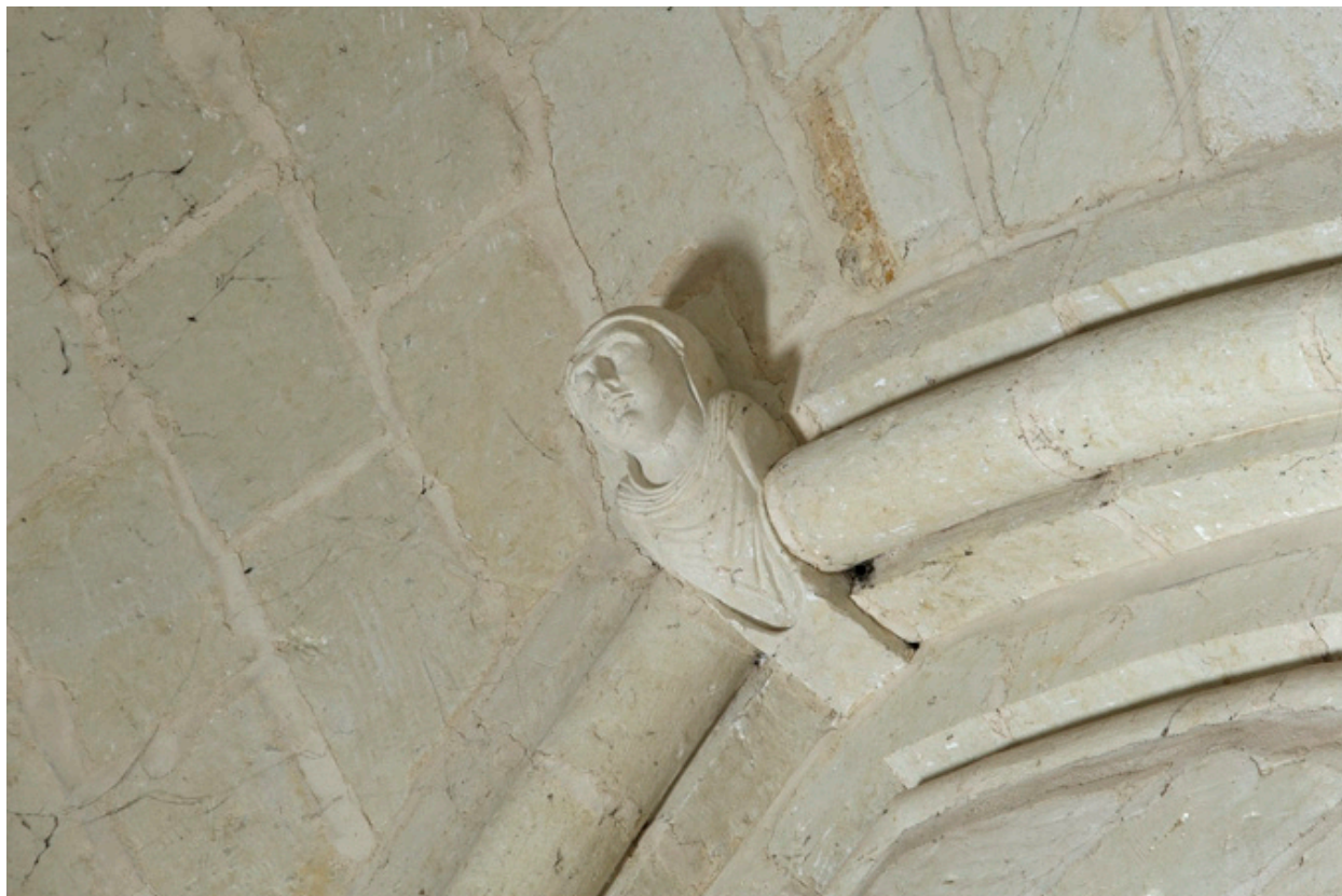
Abside, mur nord, clef du formeret : sainte femme ou religieuse (?), de trois-quart.
