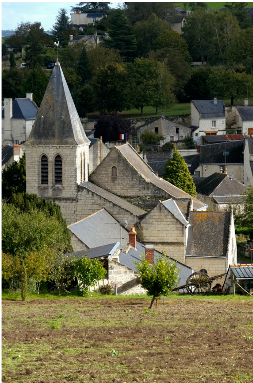
L'église, vue du coteau de la Maumenière.
