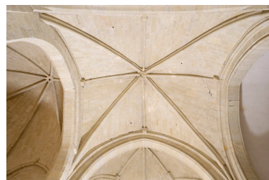
Voûte de la croisée du transept. Phot. Bruno Rousseau IVR52_20124901108NUCA
