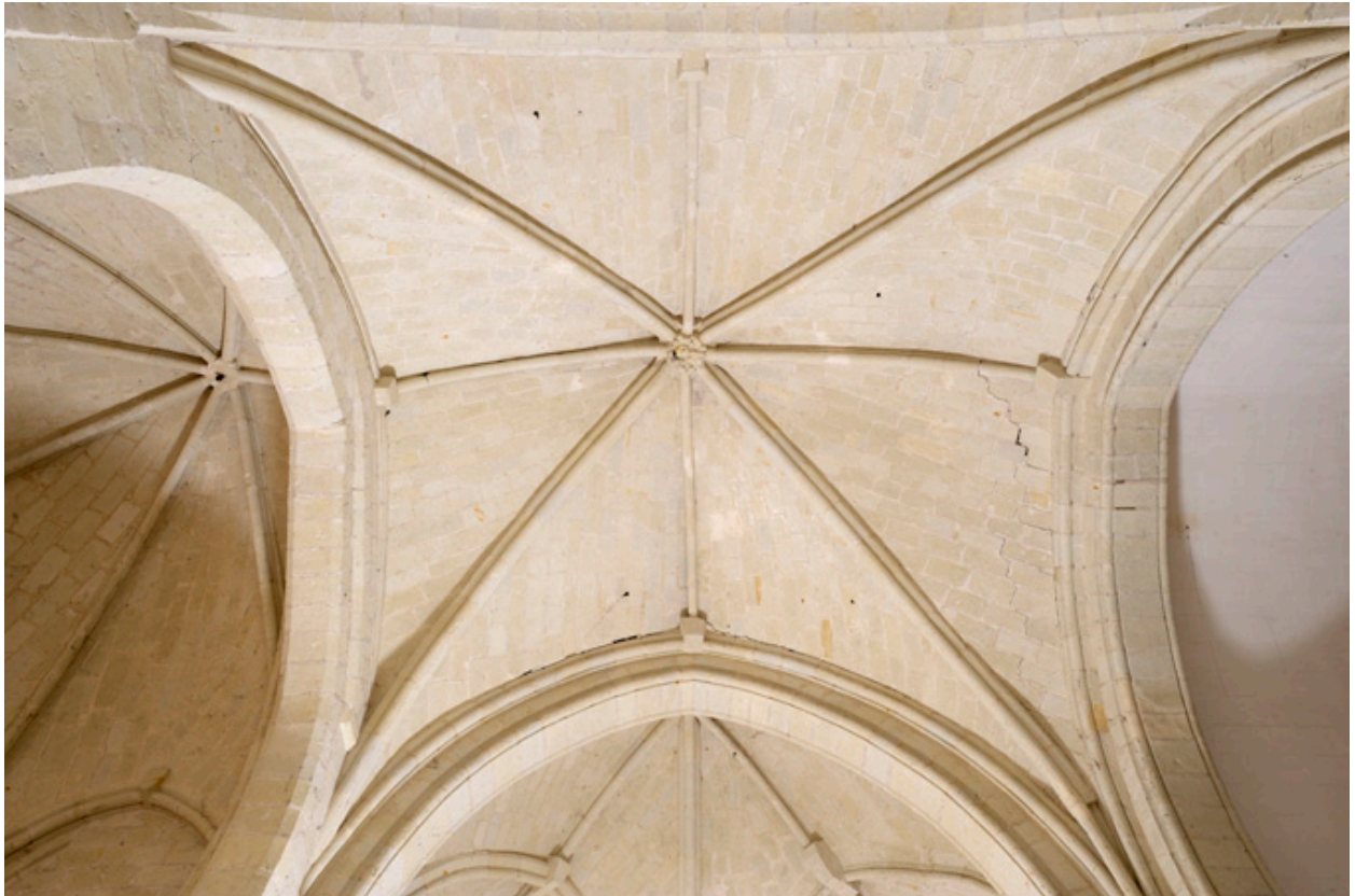
Voûte de la croisée du transept.
