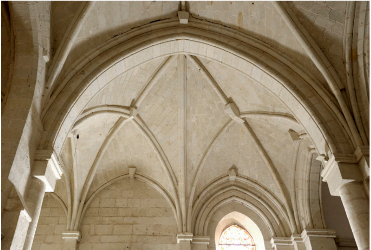
Voûtes du bras sud du transept.
