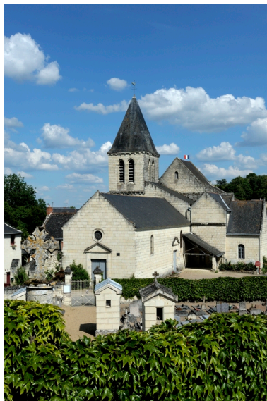
Vue d'ensemble. Phot. Bruno Rousseau IVR52_20134900774NUCA
