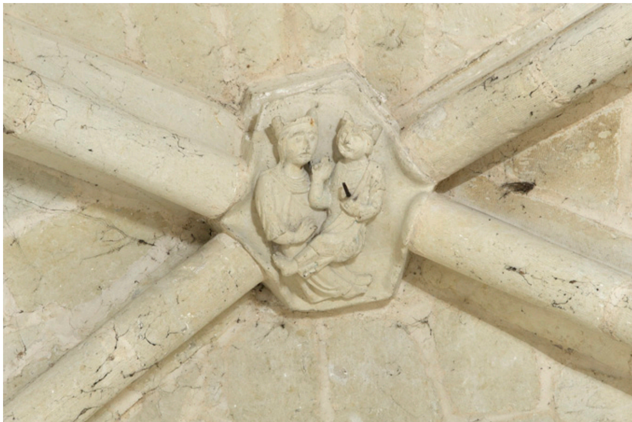
Chapelle orientée du bras sud du transept, clef de voûte : Vierge à l'Enfant.
