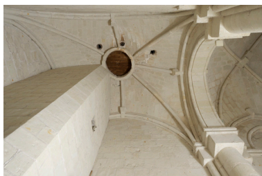
Voûtes du collatéral nord (portant le clocher). Phot. Bruno Rousseau IVR52_20124901107NUCA
