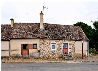
Elévation des deux maisons sur la rue. Phot. Yves Guillotin IVR52_20147202093NUCA
