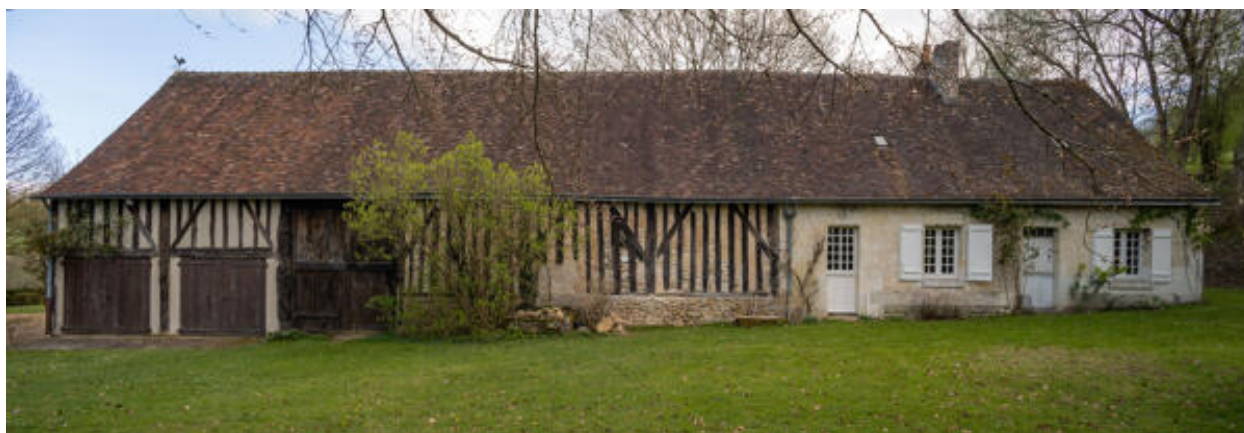
Grange-étable-remise et logement : façade ouest.
