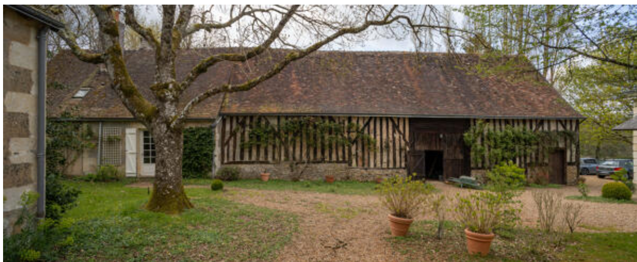
Grange-étable-remise et logement : façade sur cour.
