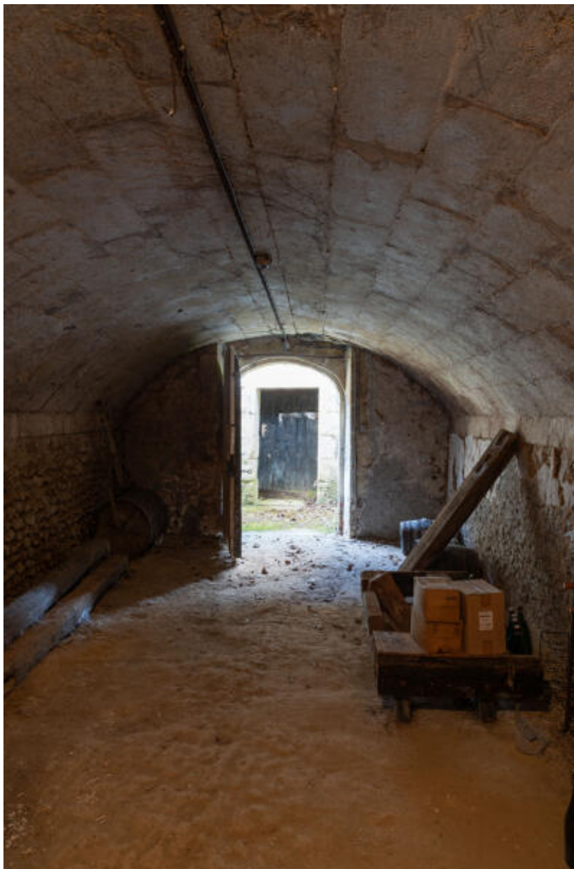
Cellier semi-enterré : vue de l'intérieur.
