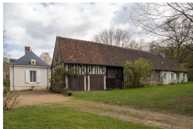
Vue d'ensemble. Phot. Jeanne Minier IVR52_20267200376NUCA
