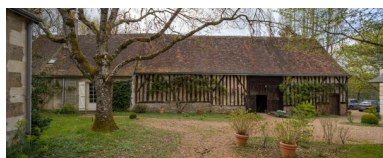
Grange-étable-remise et logement : façade sur cour. Phot. Jeanne Minier IVR52_20267200374NUCA
