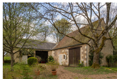
Grange-étable et remise-atelier. Phot. Jeanne Minier IVR52_20267200373NUCA
