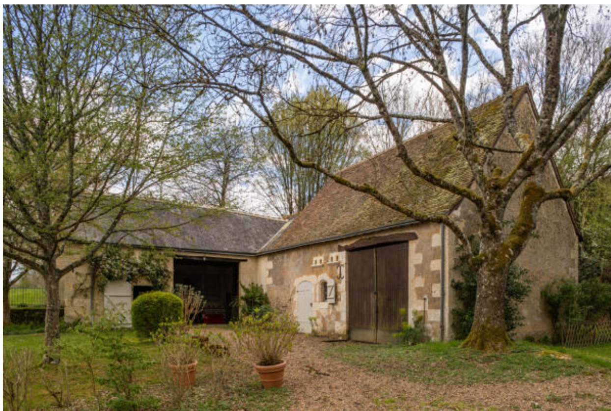
Grange-étable et remise-atelier.
