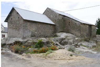
Détail de l'affleurement rocheux. Phot. Denis Pillet IVR52_20084402036NUCA
