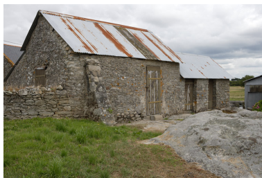
Vue des étable depuis le sud. Phot. Denis Pillet IVR52_20084402025NUCA
