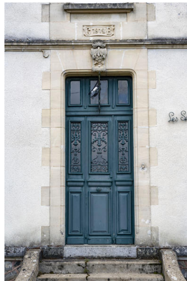
La porte d'entrée. Phot. Pierre-Bernard Fourny IVR52_20215301169NUCA
