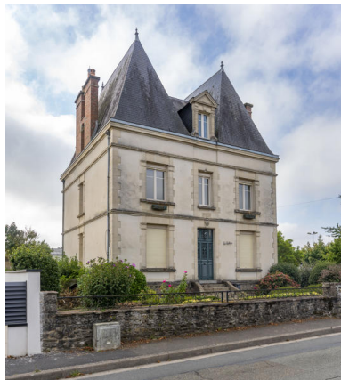
La maison. Phot. Pierre-Bernard Fourny IVR52_20215301168NUCA
