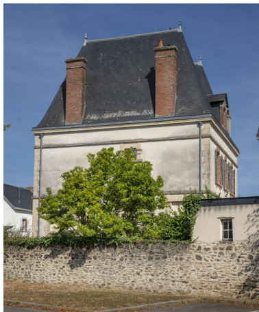
La maison. Phot. Pierre-Bernard Fourny IVR52_20215301276NUCA
