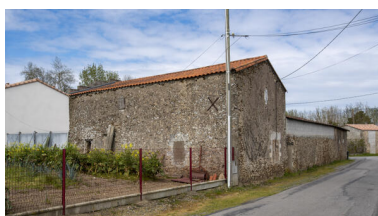
Magasin et communs sud vus de la rue des Châteaux. Phot. Pierre-Bernard Fourny IVR52_20224400108NUCA
