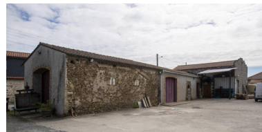
Magasin à vins. Phot. Pierre-Bernard Fourny IVR52_20224400106NUCA
