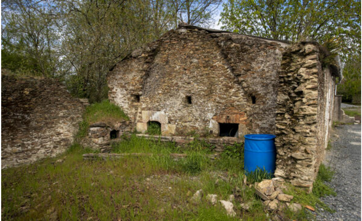
Ruine des communs ouest, fours.
