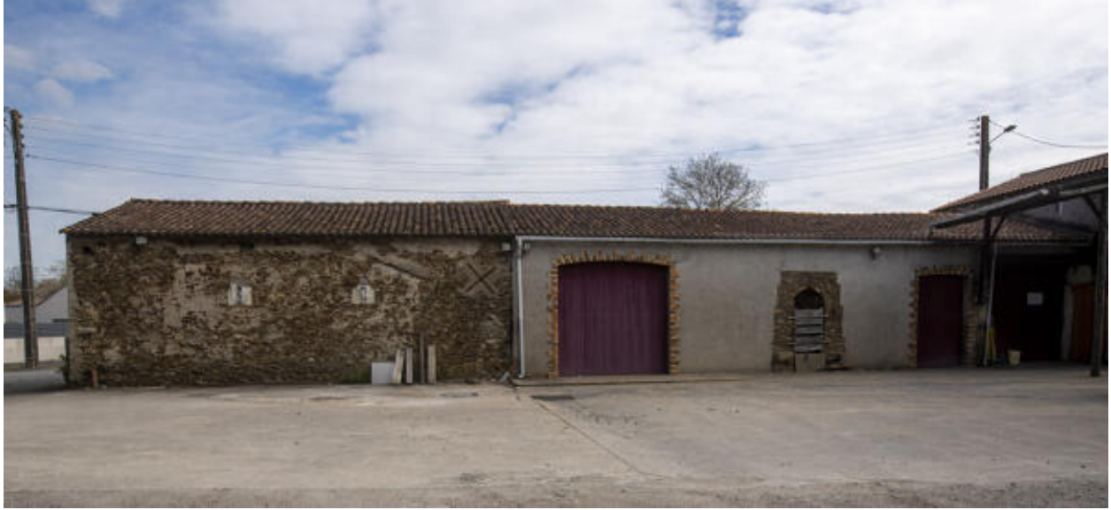
Vue du magasin depuis la cour.
