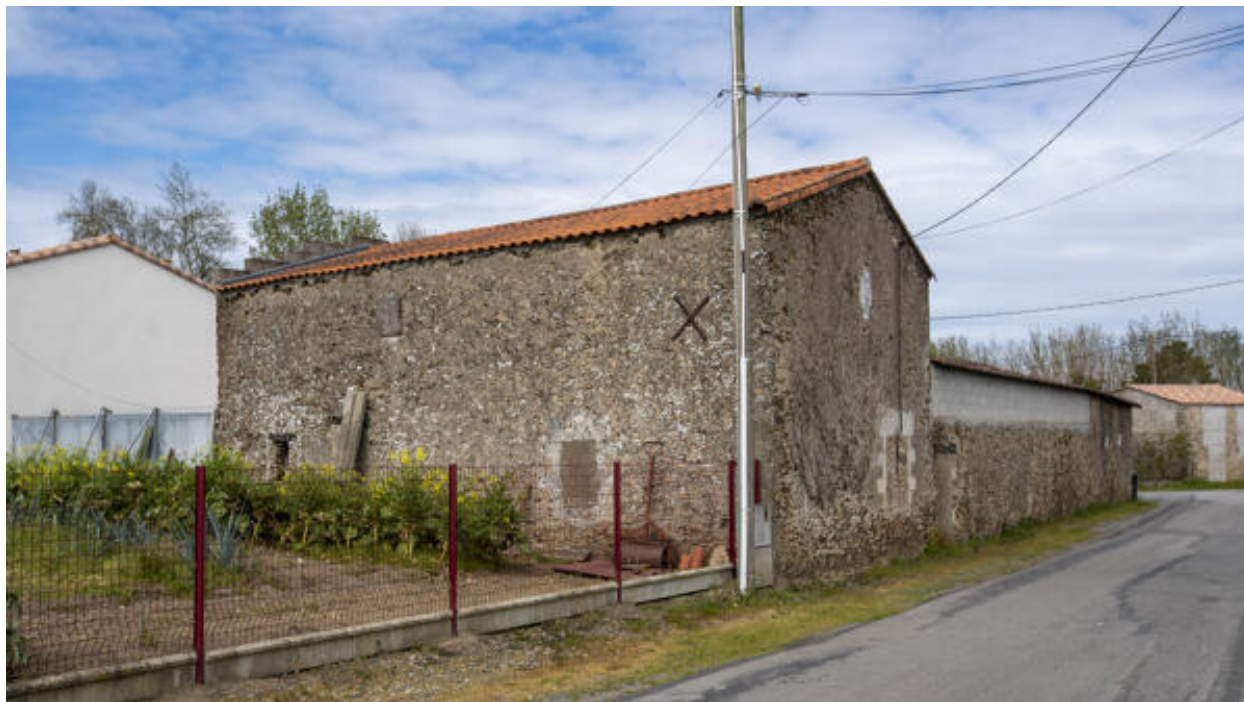
Magasin et communs sud vus de la rue des Châteaux.
