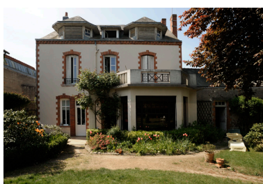
Maison de Jean Pasquier : façade est. Phot. Bruno Rousseau, Phot. Youenn Communeau IVR52_20114901379NUCA
