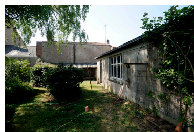
Maison de Jean Pasquier : buanderie et remise. Phot. Bruno Rousseau, Phot. Youenn Communeau IVR52_20114901383NUCA
