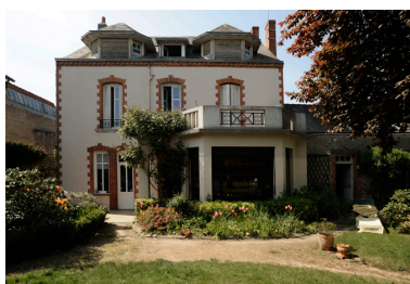
Maison de Jean Pasquier : façade est. Phot. Bruno Rousseau, Phot. Youenn Communeau IVR52_20114901379NUCA
