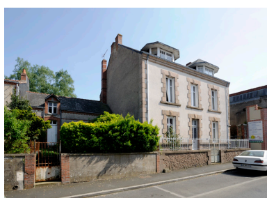
Vue générale de la maison de Jean Pasquier depuis la rue Jeanne d'Arc. Phot. Bruno Rousseau, Phot. Youenn Communeau IVR52_20114901388NUCA
