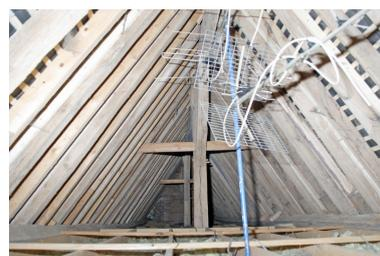
Etage de comble du corps principal : le poinçon de la ferme de charpente nord.
