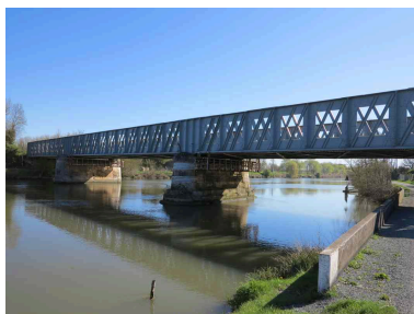
Le pont vu depuis l'aval, au sud-ouest.
