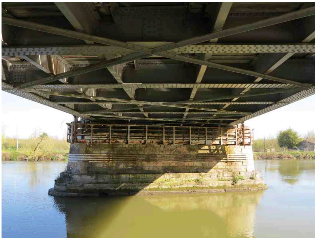
Vue de dessous le pont : pile en pierre et tablier en métal.
