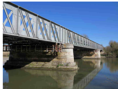
Le pont vu depuis le sud-est.
