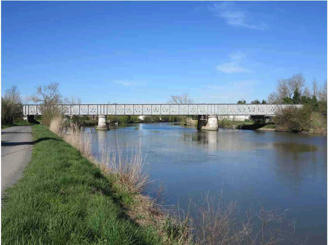
Le pont vu depuis l'amont, à l'est.
