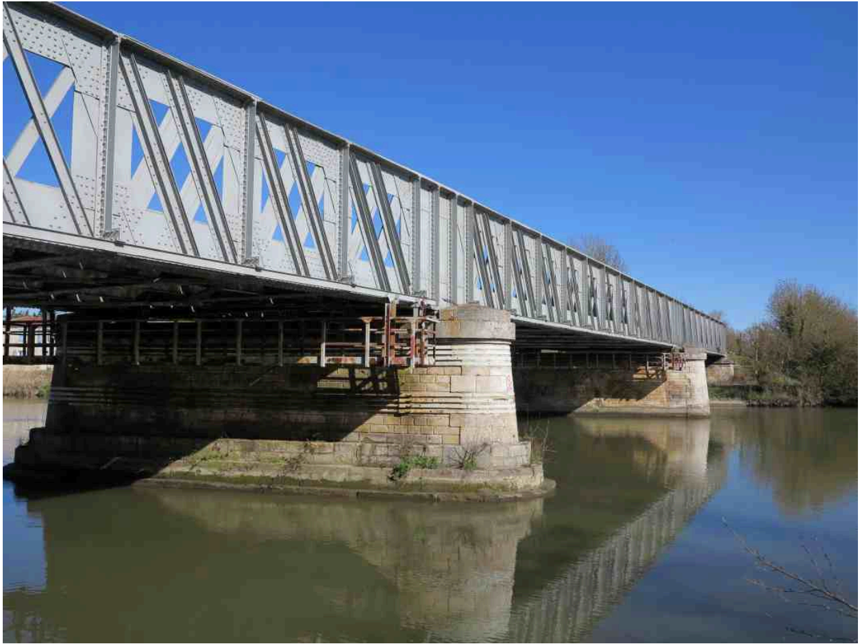
Le pont vu depuis le sud-est.
