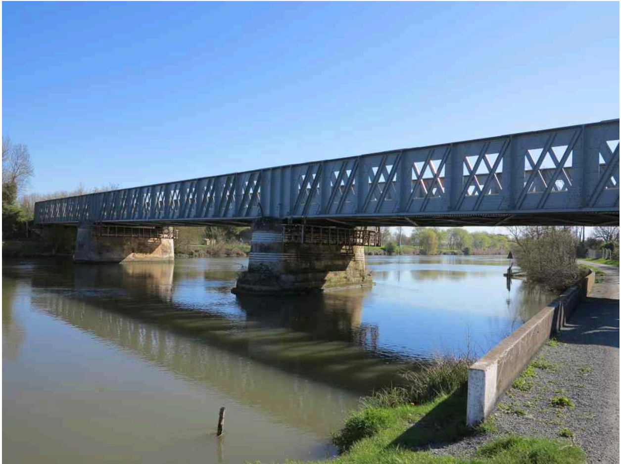
Le pont vu depuis l'aval, au sud-ouest.
