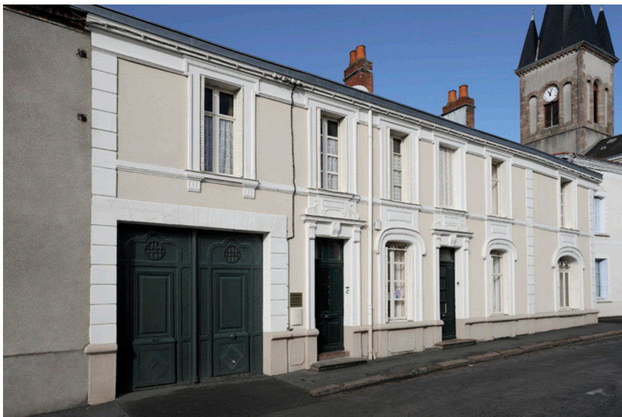
Vue générale de la maison de la famille Aigrault de Elie Durand au numéro 11 place de l'Aire du Four.
