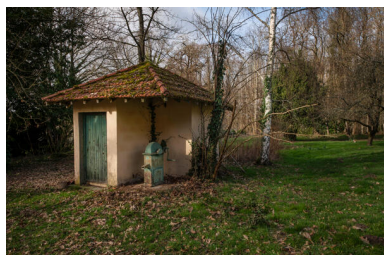
Édicule abritant le puits et la pompe. Phot. Thierry Seldubuisson IVR52_20247200209NUCA
