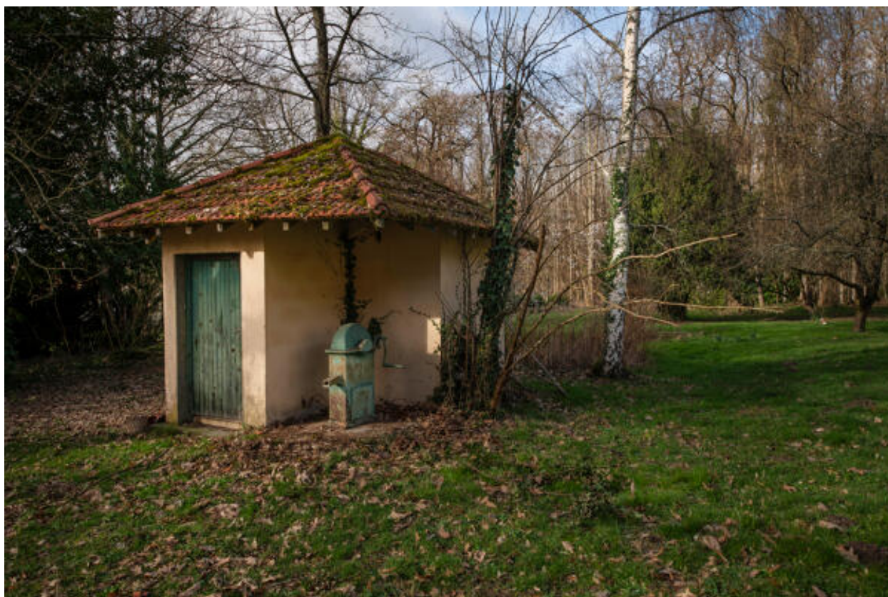
Édicule abritant le puits et la pompe.
