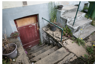
Un détail des escaliers d'accès au sous-sol et au rez-de-chaussée. Phot. Pierre-Bernard Fourny IVR52_20187201518NUCA
