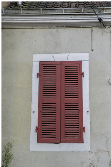
Un détail d'une fenêtre et de la corniche. Phot. Pierre-Bernard Fourny IVR52_20187201517NUCA
