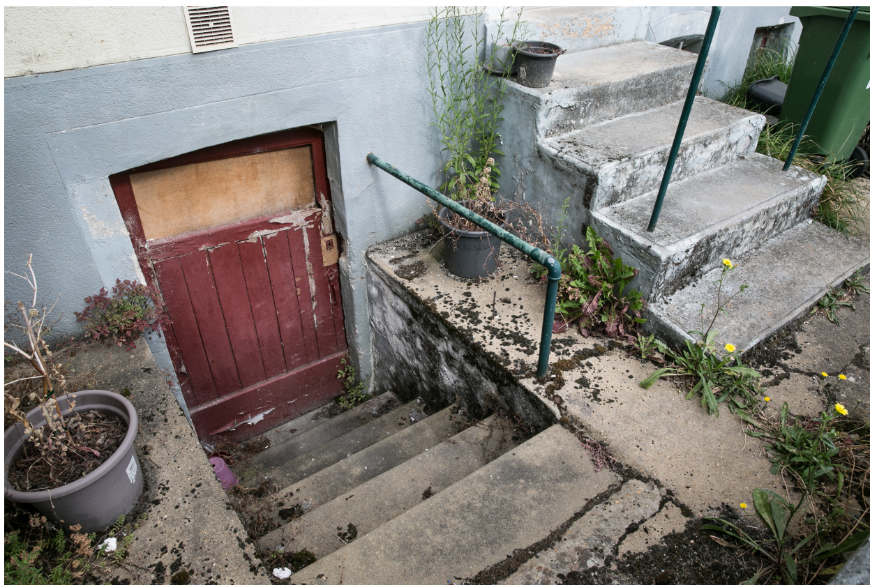
Un détail des escaliers d'accès au sous-sol et au rez-de-chaussée.
