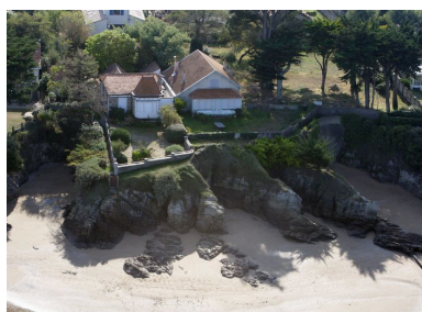
Vue aérienne de villas, Le Cormier. Phot. Denis Pillet IVR52_20114401101NUCA
