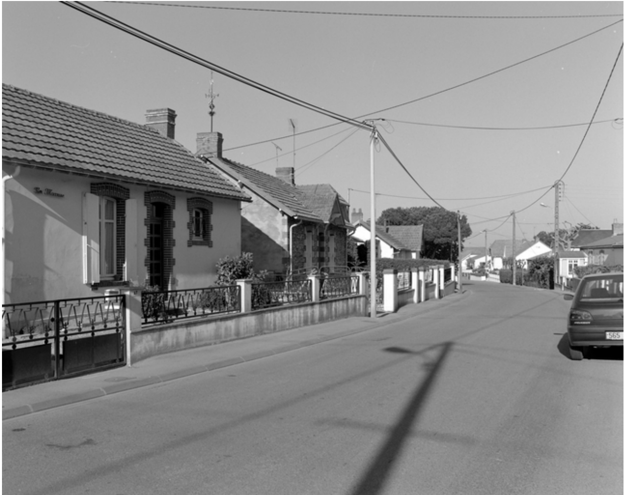
Villas, Redois (rue du) 47-51, vue de l'est.
