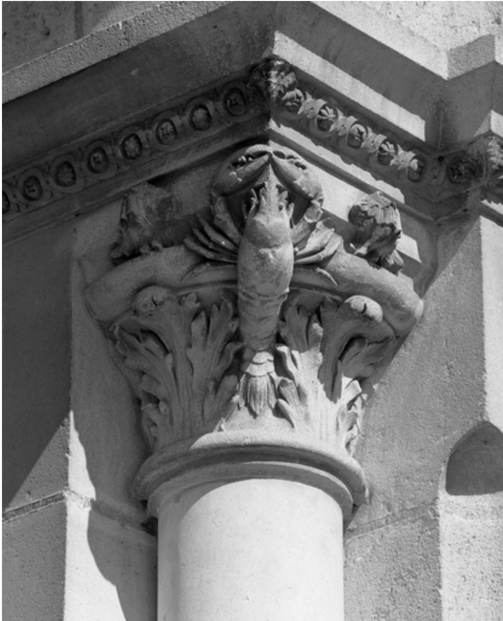
Chapiteau à décor de crustacé, à droite du portail de l'église.
