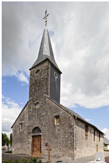
Façade occidentale de l'église de Rennes-en-Grenouilles. Phot. Yves Guillotin IVR52_20215300638NUCA
