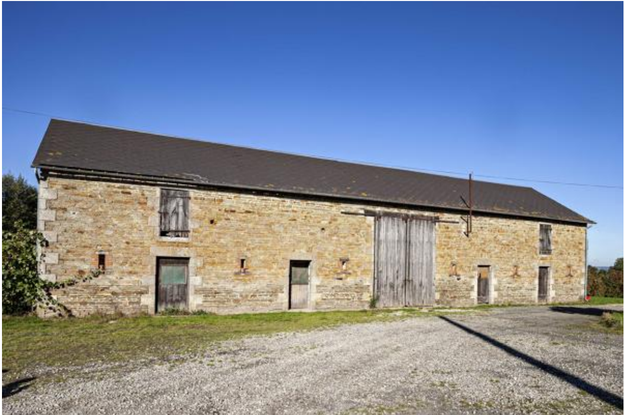
Corps de bâtiment ouest.
