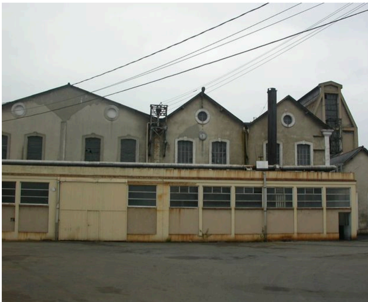
Elévation antérieure de la papeterie.
