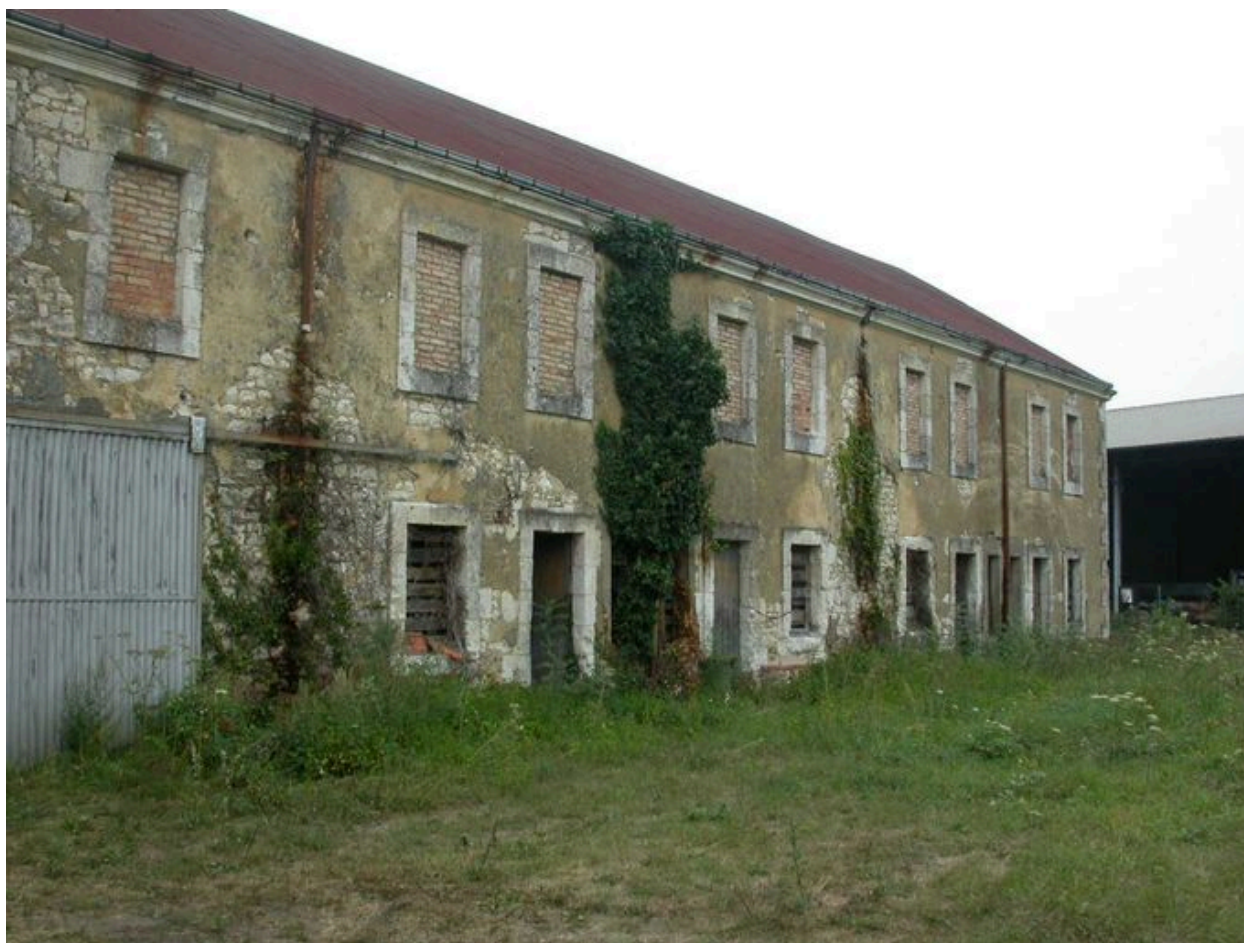
Elévation postérieure des logements ouvriers collectifs de la papeterie.
