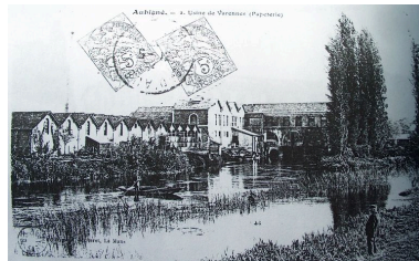
Vue d'ensemble de la papeterie.
