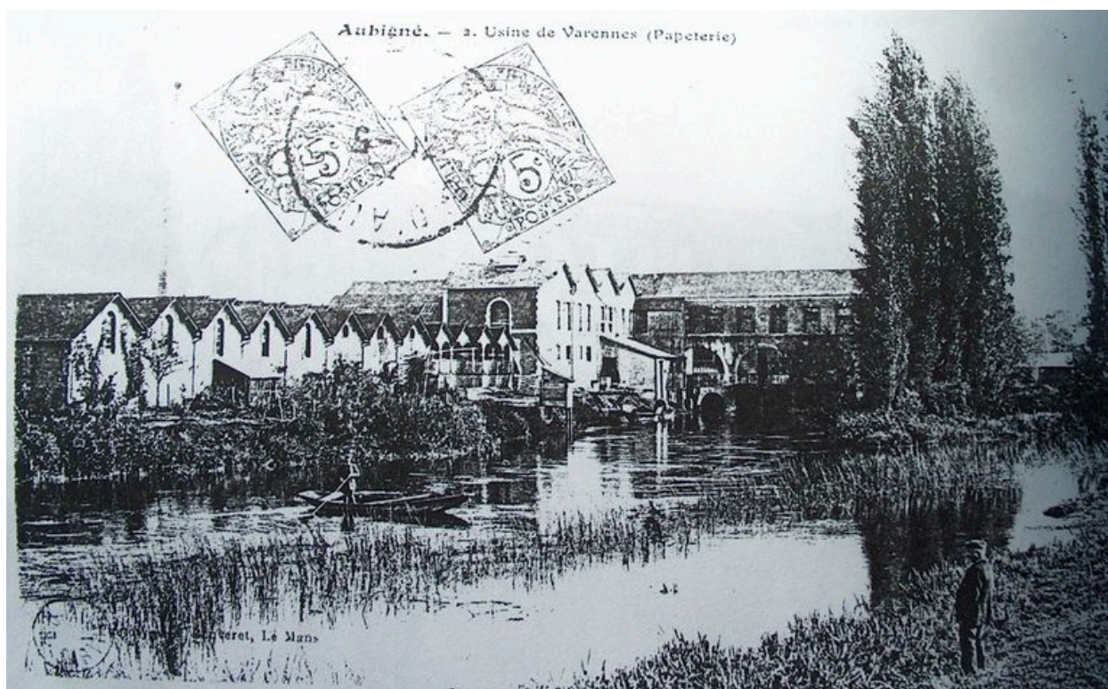
Vue d'ensemble de la papeterie.
