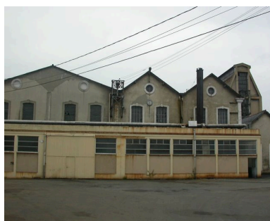
Elévation antérieure de la papeterie. Phot. Jonathan Truillet IVR52_20057200599NUCA
