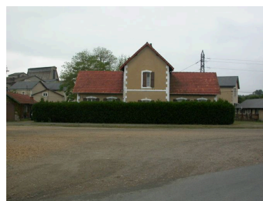
Elévation antérieure de l'école de la cité ouvrière. Phot. Jonathan Truillet IVR52_20057200594NUCA
