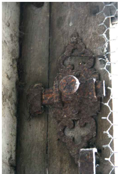
1er étage, garde-robe centrale, détail : targette. Phot. Jean-Baptiste Darrasse IVR52_20067206418NUCA
