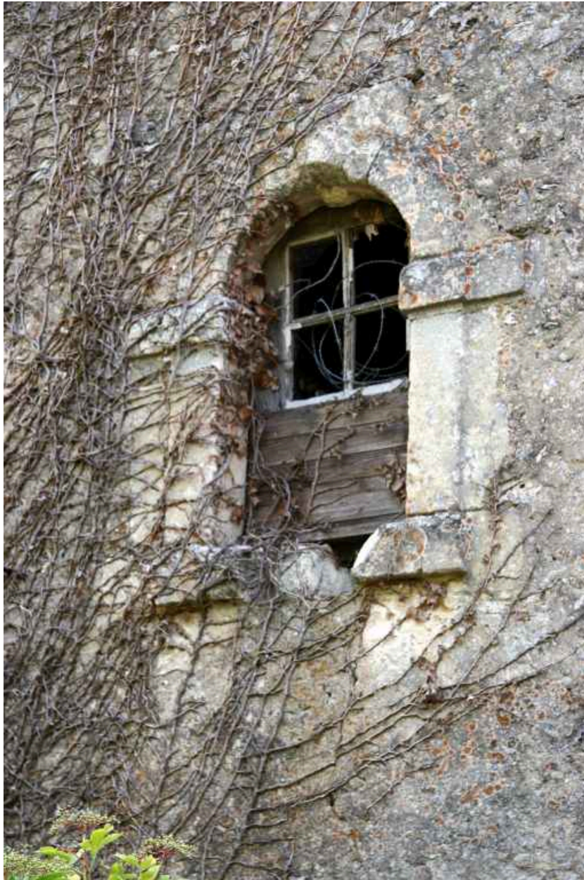
Tourelle d'escalier : baie plein cintre.
