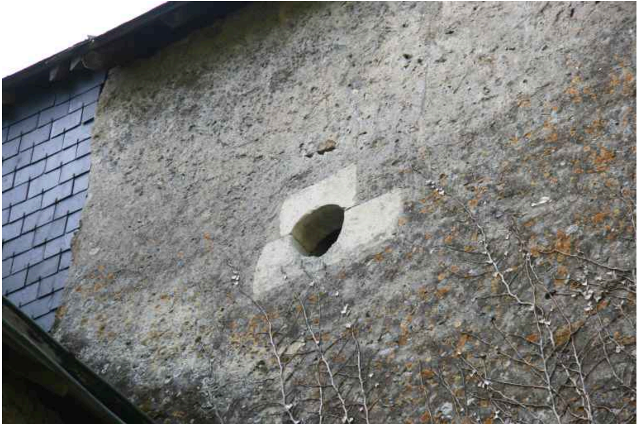
Tourelle d'escalier : bouche à feu ?
