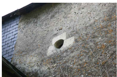
Tourelle d'escalier : bouche à feu ? Phot. Jean-Baptiste Darrasse IVR52_20067206428NUCA
