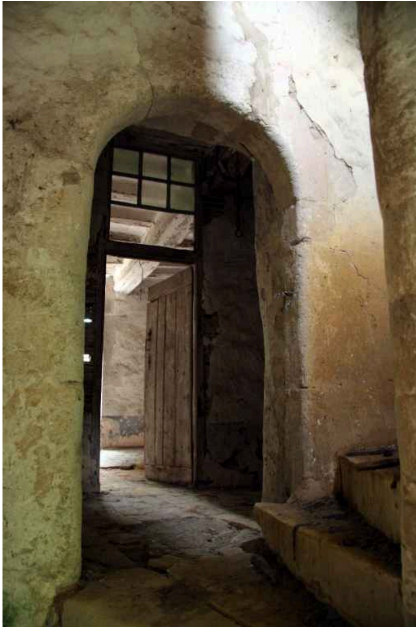
Tourelle d'escalier : palier du 1er étage.
