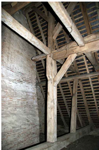
Les combles : charpente à pannes avec sous-faîtage. Phot. Jean-Baptiste Darrasse IVR52_20067206414NUCA
