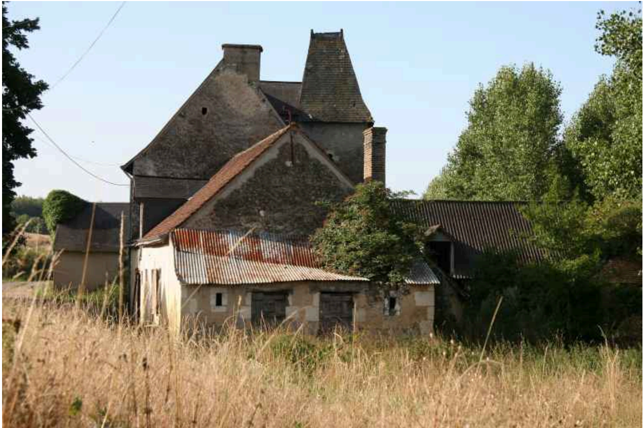
Vue de volume prise du nord.
