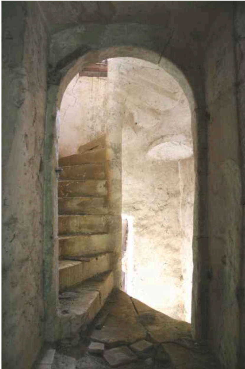
L'escalier en vis vu du sas du 1er étage.
