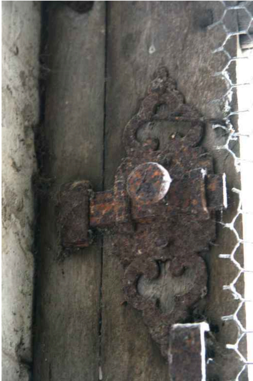
1er étage, garde-robe centrale, détail : targette.
