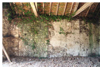
Hangar sud construit anciennement sur des piliers. Phot. Jean-Baptiste Darrasse IVR52_20067206434NUCA
