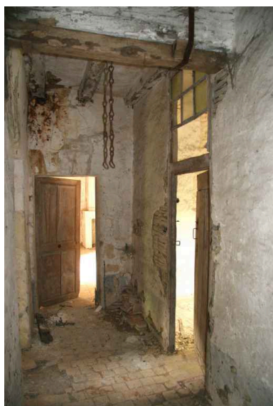
Sas du 1er étage vers la salle nord. Phot. Jean-Baptiste Darrasse IVR52_20067206420NUCA
