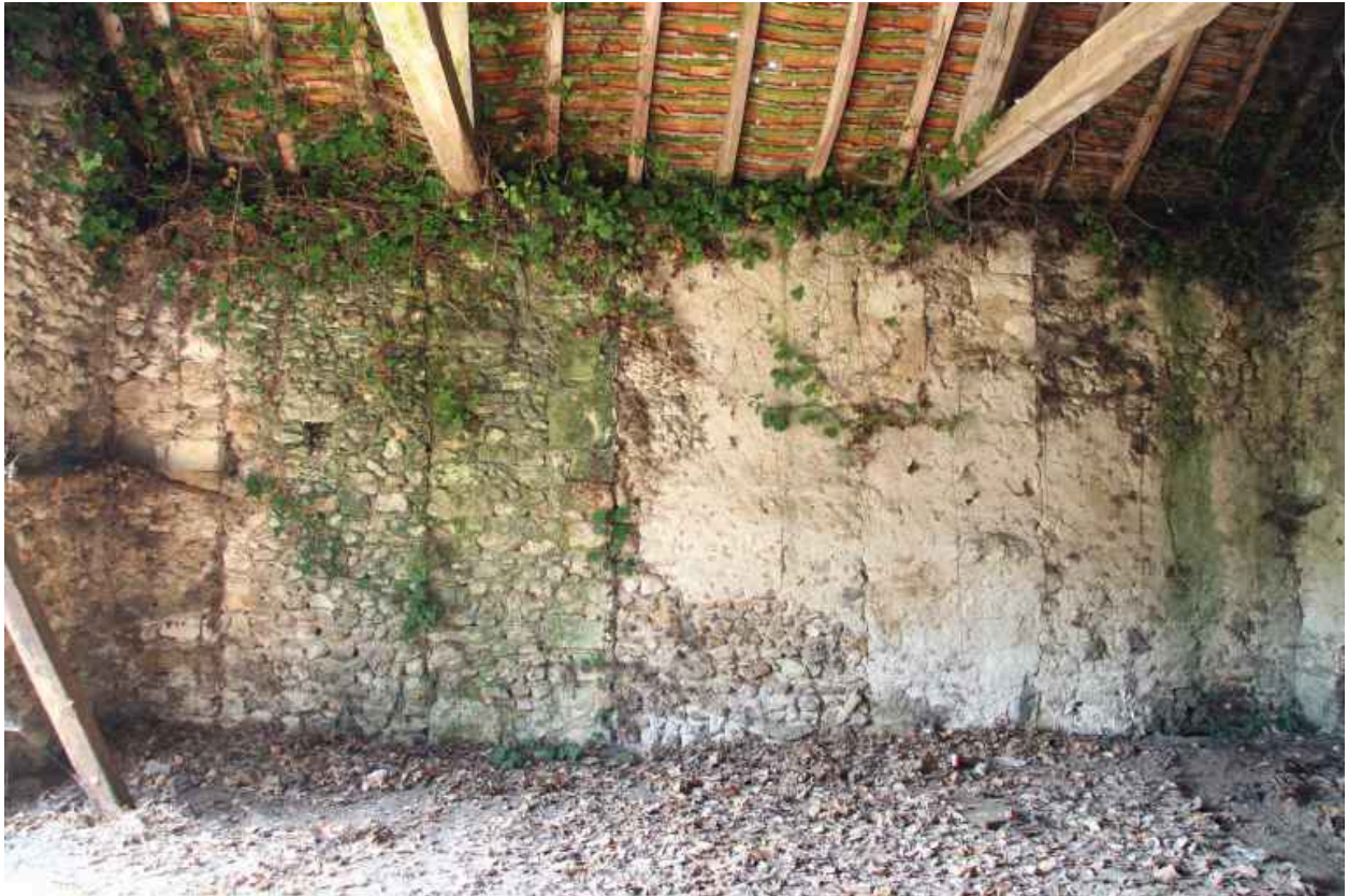
Hangar sud construit anciennement sur des piliers.
