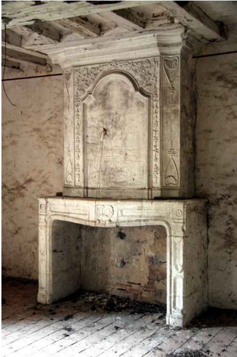
1er étage, salle nord : cheminée en pierre.
