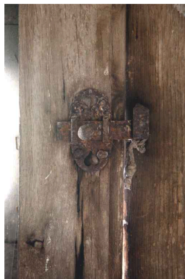
Tourelle d'escalier, détail : targette. Phot. Jean-Baptiste Darrasse IVR52_20067206422NUCA
