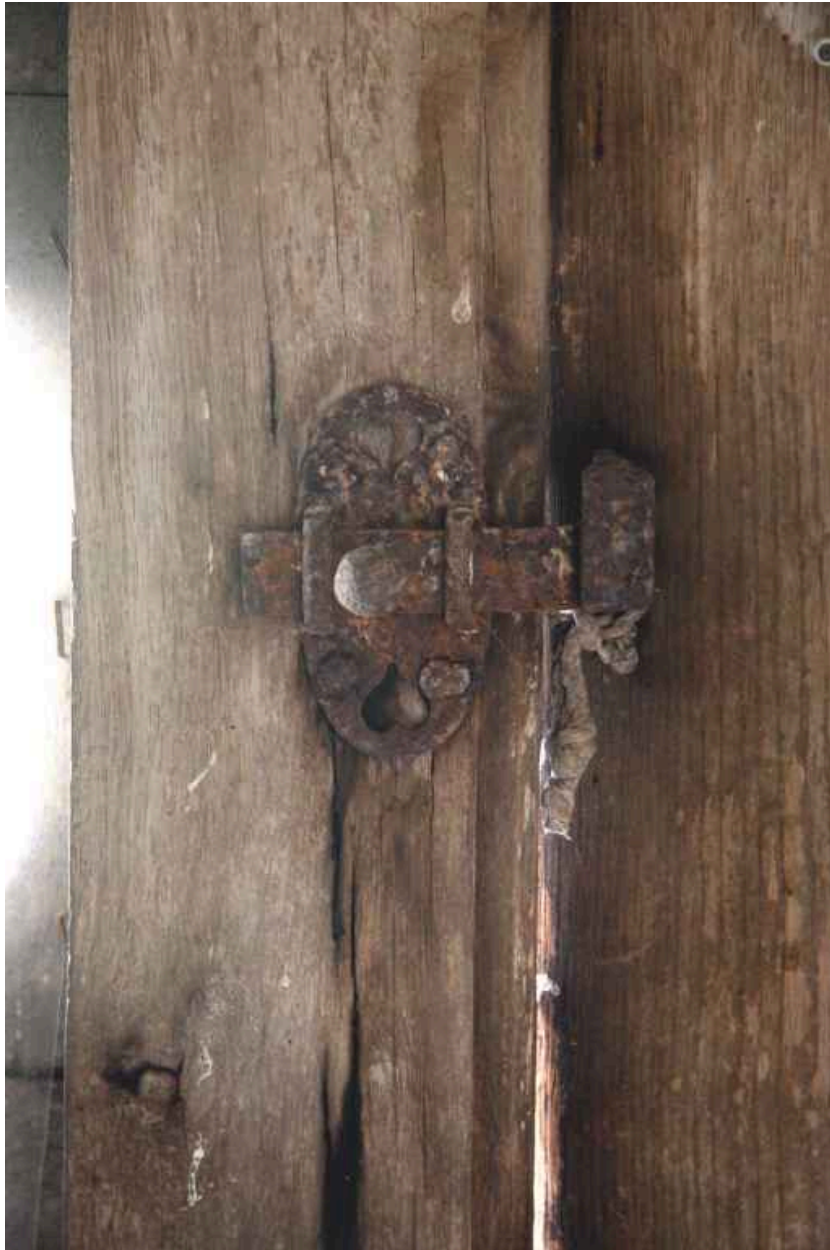
Tourelle d'escalier, détail : targette.
