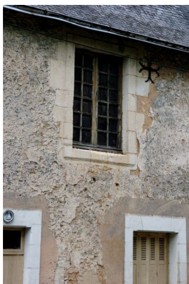
Façade postérieure : baie. Phot. David Huard IVR52_20047205740NUCA
