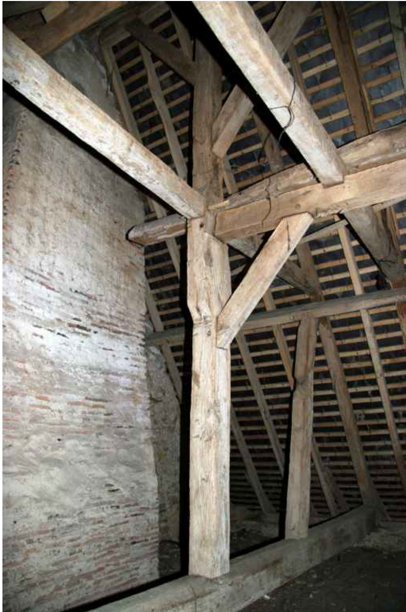
Les combles : charpente à pannes avec sous-faitage.
