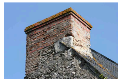
Pignon sud, détail : vestige d'un rondelis en tuffeau. Phot. Jean-Baptiste Darrasse IVR52_20067206431NUCA
