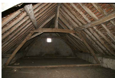
Dépendances sud : les combles. Phot. Jean-Baptiste Darrasse IVR52_20067206433NUCA
