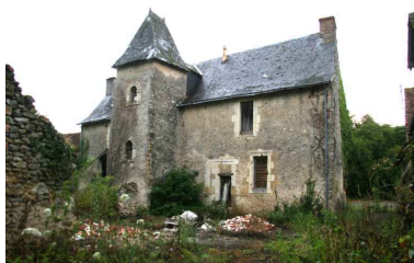
Façade sur cour. Phot. Jean-Baptiste Darrasse IVR52_20067206409NUCA
