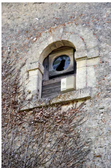
Tourelle d'escalier, dernier étage : baie en plein cintre. Phot. Jean-Baptiste Darrasse IVR52_20067206427NUCA
