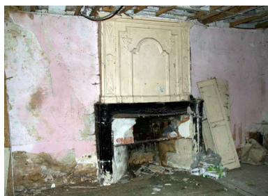
Rez-de-chaussée, salle sud : cheminée. Phot. Jean-Baptiste Darrasse IVR52_20067206412NUCA
