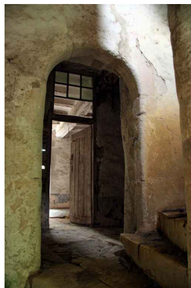
Tourelle d'escalier : palier du 1er étage. Phot. Jean-Baptiste Darrasse IVR52_20067206416NUCA
