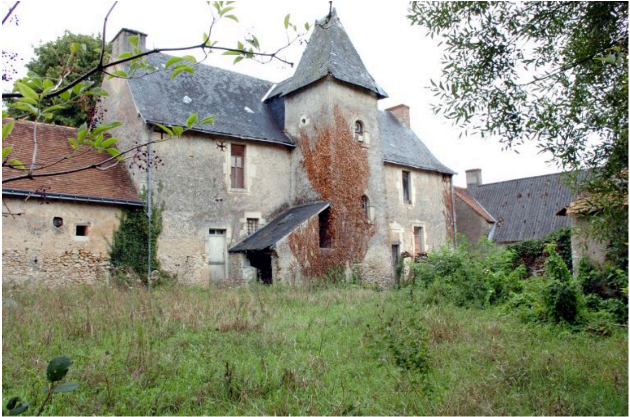
Vue d'ensemble prise de la cour.
