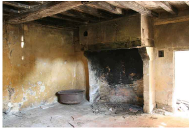
Dépendances sud : la buanderie. Phot. Jean-Baptiste Darrasse IVR52_20067206432NUCA
