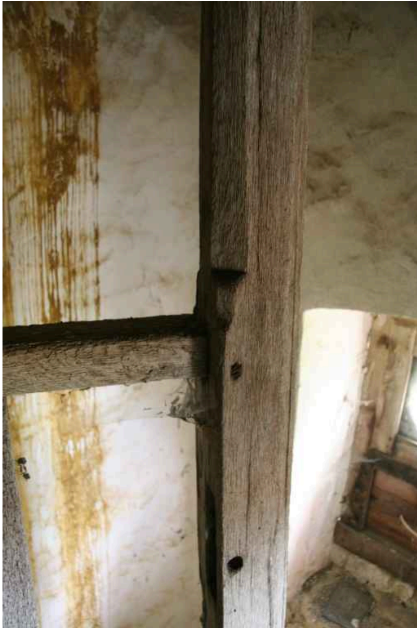
Escalier en vis, poteau du garde-fou : détail.
