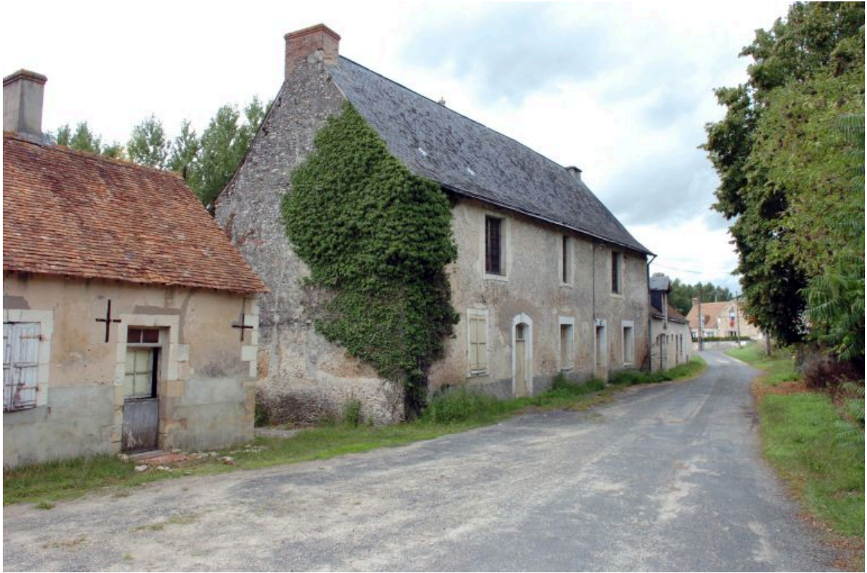
Façade postérieure sur le chemin.
