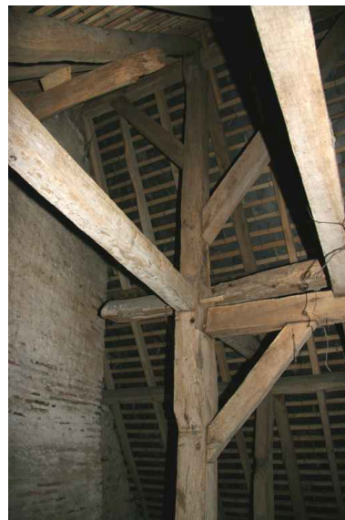
La charpente ne s'appuie pas sur le pignon. Phot. Jean-Baptiste Darrasse IVR52_20067206415NUCA
