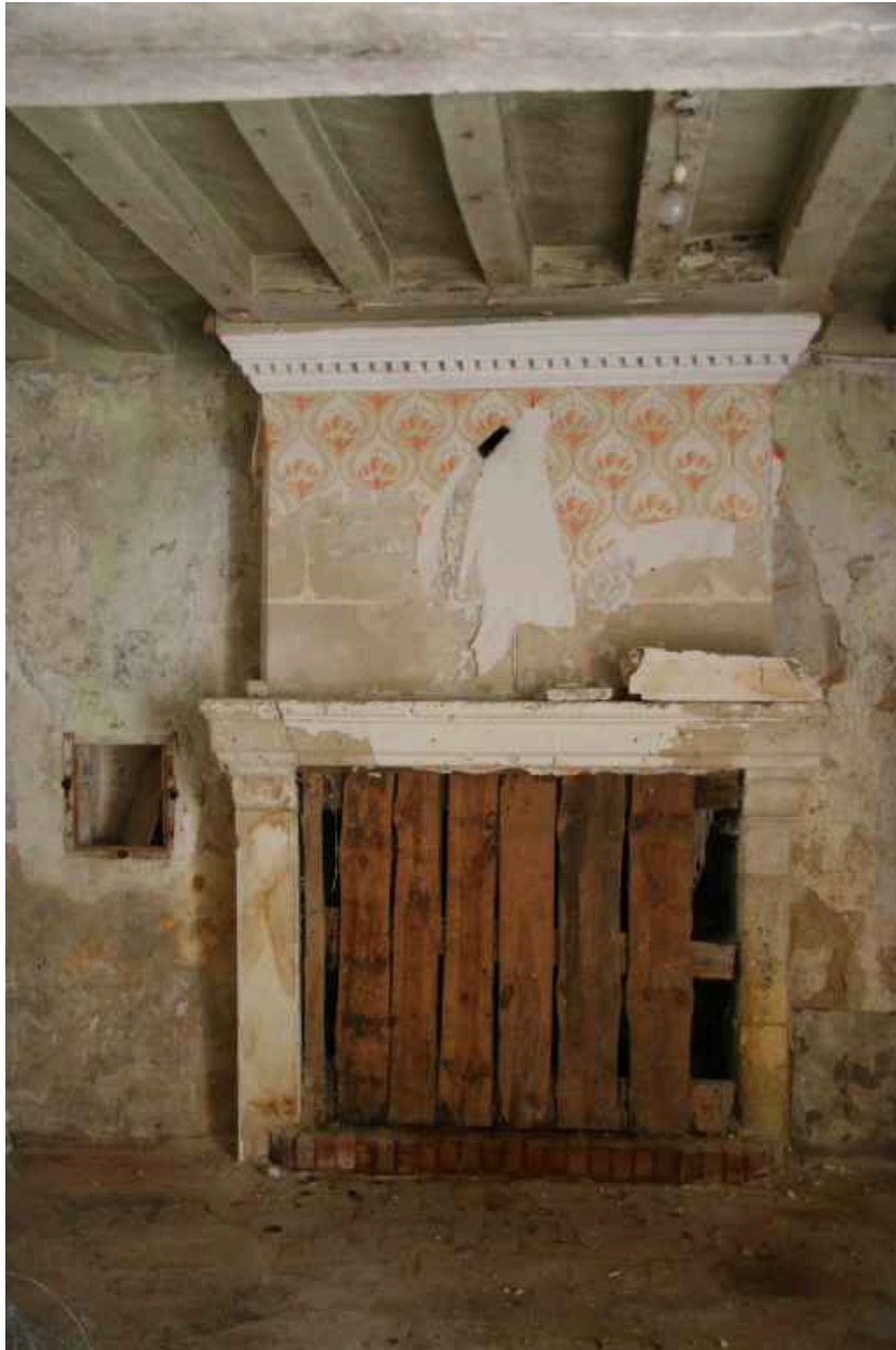
Rez-de-chaussée : cheminée nord.
