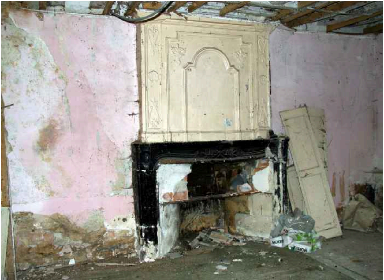
Rez-de-chaussée, salle sud : cheminée.
