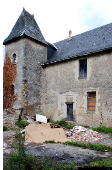
Façade sur cour, détail : croisée en partie bouchée. Phot. David Huard IVR52_20047205737NUCA
