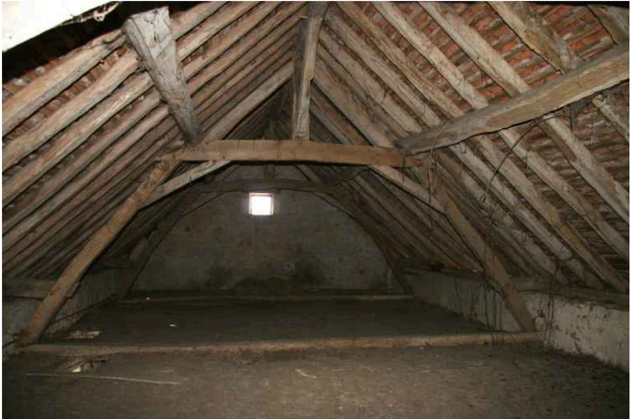
Dépendances sud : les combles.
