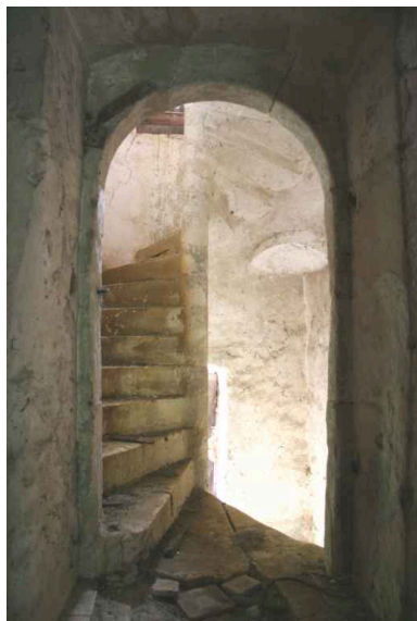
L'escalier en vis vu du sas du 1er étage. Phot. Jean-Baptiste Darrasse IVR52_20067206419NUCA
