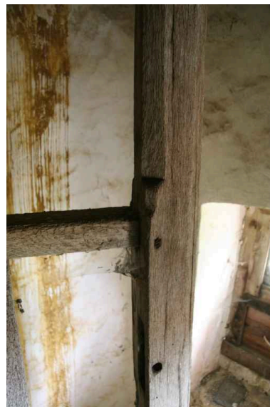
Escalier en vis, poteau du garde-fou : détail. Phot. Jean-Baptiste Darrasse IVR52_20067206424NUCA
