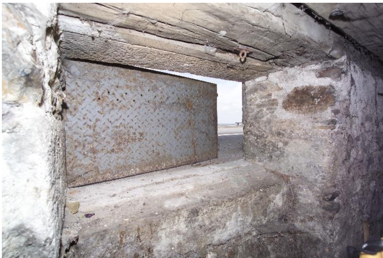
L'ouverture de la cave sur le quai.
