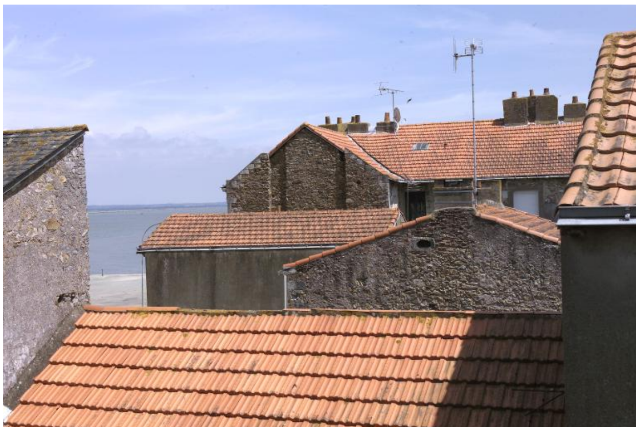
En arrière-plan, la maison vue du n° 32 rue du Général-De-Gaulle.
