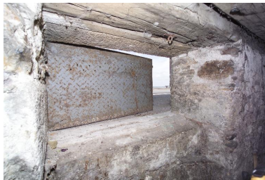
L'ouverture de la cave sur le quai. Phot. Denis Pillet IVR52_20034400585NUCA
